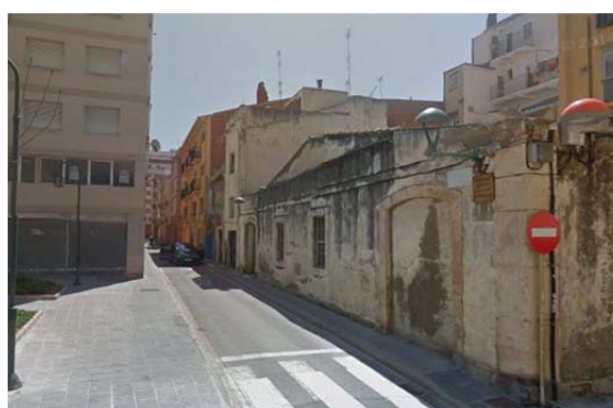
C/ Nou de Santa Tecla: viejas naves en ruinas y nuevos edificios residenciales.
