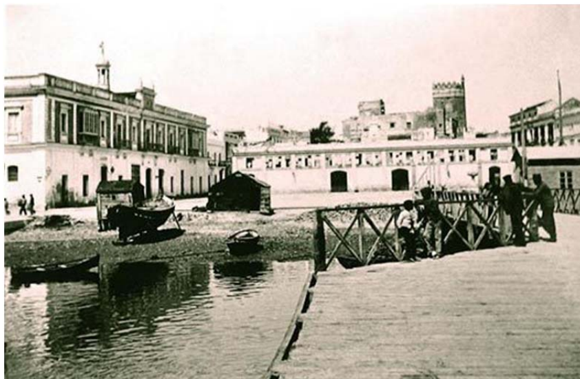
Imagen 25: Plaza de la Pescadería desde el muelle: puede verse el edificio que se construyó frente al Resbaladero, que fue utilizado como almacenes y como estación de bomberos. Este edificio sería derribado para dar paso nuevas edificaciones durante el régimen franquista.
