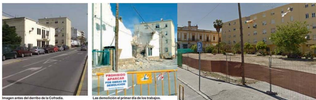
Imagen 94: Plaza de la Pescadería con la Cofradía, durante el derribo y con el solar de la Cofradía.
