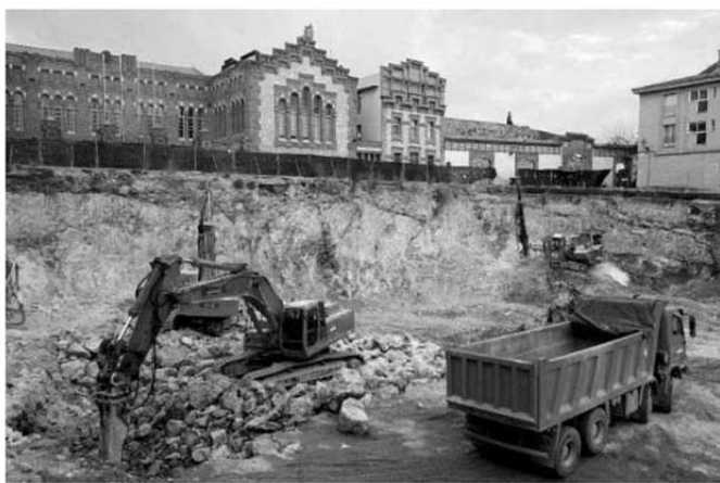
La excavación del aparcamiento ante el rectorado de la URV tendría que haber terminado en febrero
