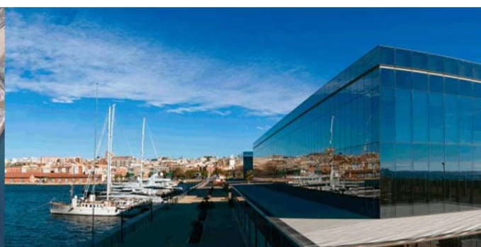
Los edificios del Moll de Lleida que iban a ser derribados donde no se consolidaron los negocios.
