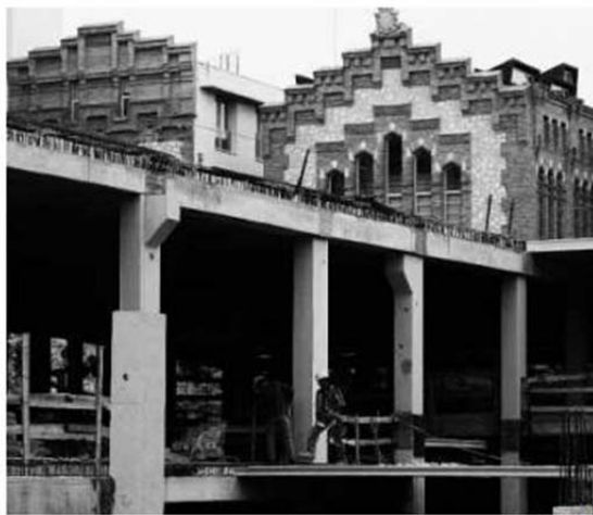
Las obras del parking tapan la fachada del antiguo matadero
