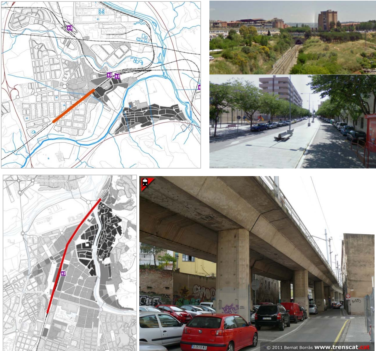
Figura 10. A) Tramo del ferrocarril cubierto en la ciudad de Vic. Planta y fotografías aéreas actuales de la traza de FFCC soterrada. B) Tramo del ferrocarril cubierto en la ciudad de Martorell. Planta y fotografías actuales del Paseo de Catalunya i la llegada de las vías a la ciudad. C) Tramo del ferrocarril en viaducto en la ciudad de Girona. Planta y fotografía actual de la estructura. Fuente: Propia sobre bases del ICC, Google Street View y Bernat Borràs ( www.trenscat.cat ).
