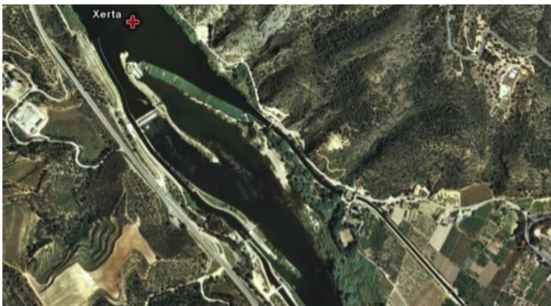
Figura 3.50. Assut de Xerta i inici dels dos canals del riu Ebre (Canal de la Dreta i Canal de l'Esquerra).
