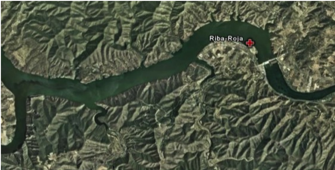
Figura 3.39. Presa del pantà de Riba-roja i localització del punt de mostreig.
