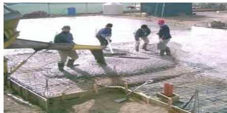
Figura 36: Concreto armado para firme de reforzado con malla electro soldada.
