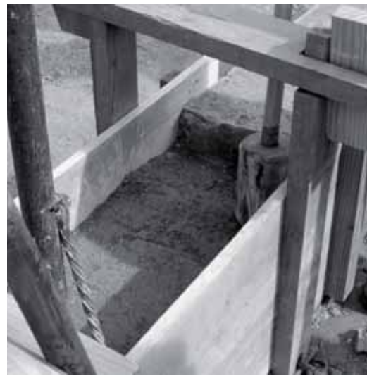
Fig. 10.9 - In queste due foto si vedono l'applicazione della terra e poi l'operazione di compattazione dei grani. Come si può osservare il livello iniziale della terra e quello finale non coincide, questa forte compattazione dei grani ottenuta attraverso l'ausilio dei pestelli dona resistenza alla struttura.
