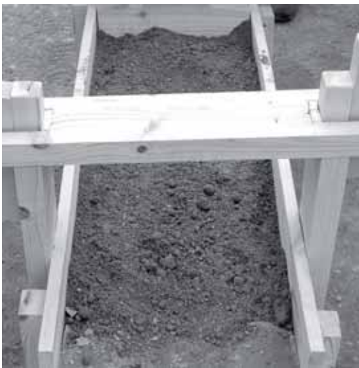
Fig. 10.9 - In queste due foto si vedono l'applicazione della terra e poi l'operazione di compattazione dei grani. Come si può osservare il livello iniziale della terra e quello finale non coincide, questa forte compattazione dei grani ottenuta attraverso l'ausilio dei pestelli dona resistenza alla struttura.
