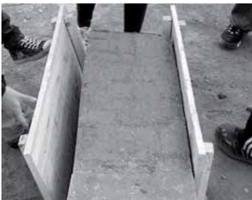
Fig. 10.10 - Nella foto a sinistra, finita la compattazione, si monta la cassaforma. A destra, la parte di parete elevata con la tecnica del pisé .
