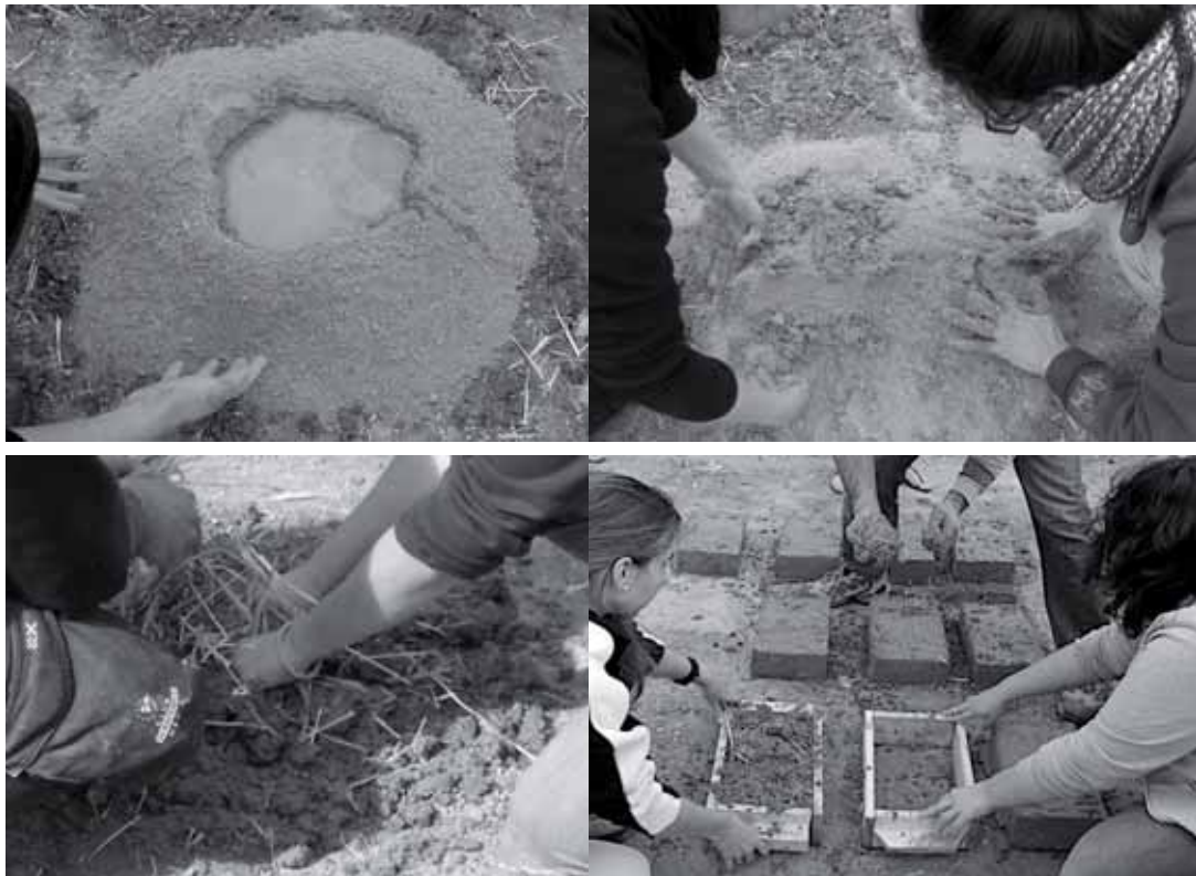
Fig. 10.7 – In queste foto si vedono le operazioni di miscelazione della terra con acqua inizialmente e poi l'aggiunta della paglia. L'ultima foto in basso mostra la gettata dell'impasto nel modulo.
