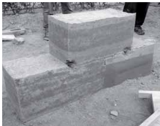
Fig. 10.10 - Nella foto a sinistra, finita la compattazione, si monta la cassaforma. A destra, la parte di parete elevata con la tecnica del pisé .
