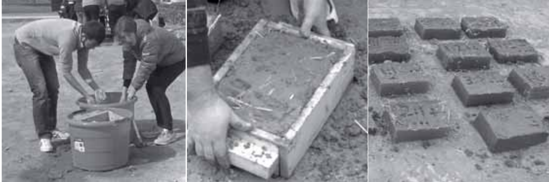
Fig. 10.8 – Nella prima foto a sinistra è visibile l’immersione degli stampi in bacinelle riempite di acqua, la foto centrale immortalata l’attimo precedente il distacco dello stampo e infine l’ultima mostra i vari adobes dopo la produzione.
