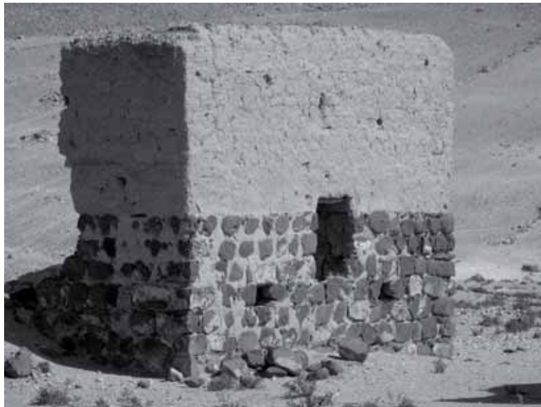
Fig. 2.10 – Imagen de restos de casa con base de piedra en un pueblo de la región de Alepo.
