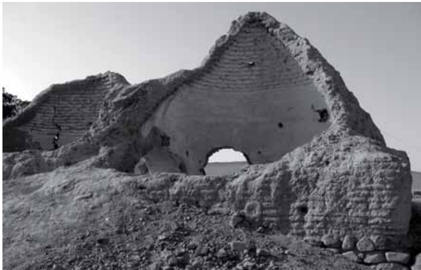
Fig. 2.9 – Imagen de los restos de una construcción con techo en bóveda que no presentan refuerzos de madera en el pueblo de Rasm Hamd.
