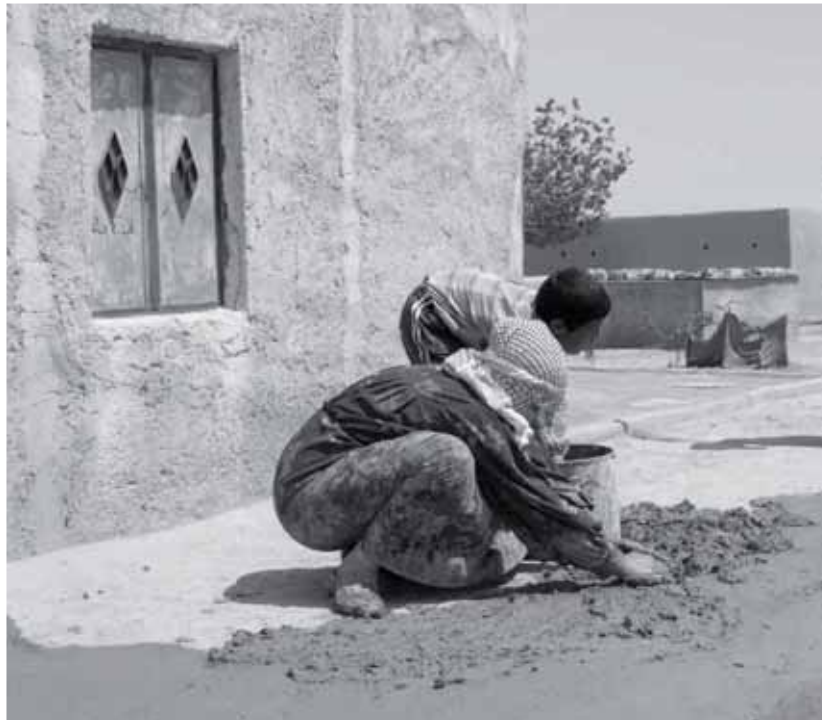
Fig. 2.21 – Mantenimiento del revestimiento aplicando una capa nueva de tierra mezclada con agua y paja en un pueblo sirio. (Imagen de Mecca-Dipasquale 2009:351).
