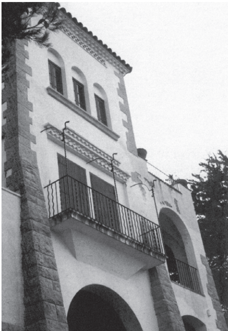
Casa Guàrdia, Punta Prima, S'Agaró Pelai Martínez, arquitecte 1929
