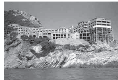
Hotel Cap sa Sal, en construcció, Aiguafreda, Begur, Bosch i Aymerich, arquitecte
