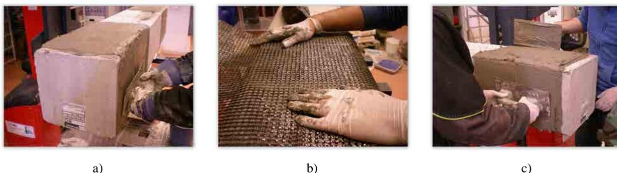
**Figura D.6 Aplicación del *TRM* en las vigas V: a) aplicación de la primera capa de mortero, b) imbibición del tejido en la matriz, c) acabados superficiales en la segunda capa de mortero.**
