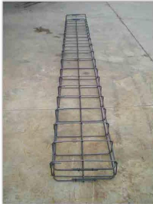
**Figura C.2 Armadura montada de las vigas M.**
