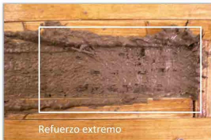
**Figura A.80** Refuerzo extremo embebido en el mortero.
