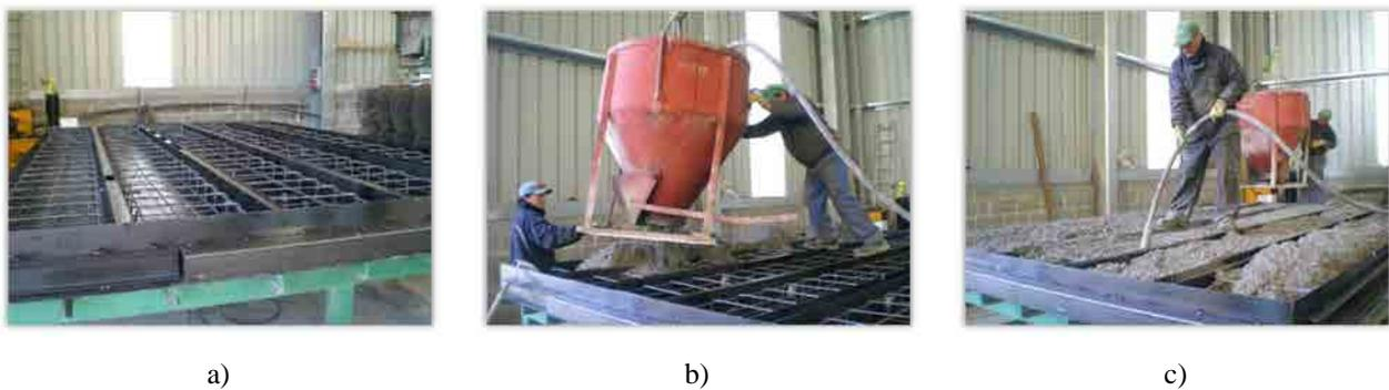
**Figura C.3 Procesos ejecución de las vigas M: a) montaje de la armadura, b) vertido del hormigón, c) vibrado del hormigón.**
