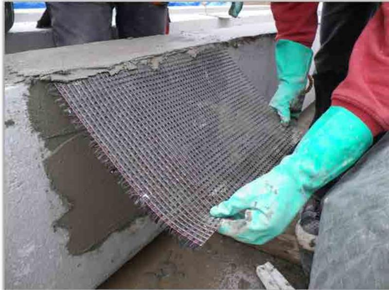
Figura 2.25 Instalación del TRM mediante técnica de aplicación húmeda.
