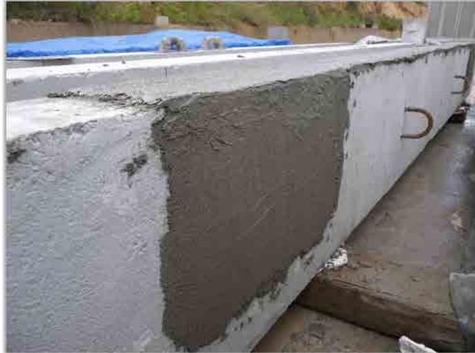
**Figura C.8 Vigas M durante la fase de curado de los refuerzos.**
