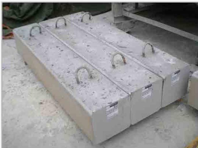
**Figura D.3 Vigas V terminadas y en fase de curado.**
