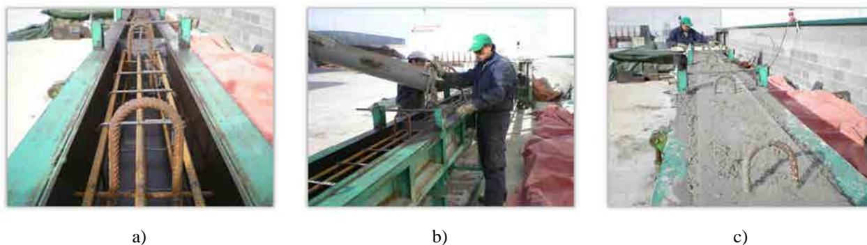
**Figura D.2 Procesos ejecución de las vigas V: a) montaje de la armadura, b) vertido del hormigón, c) enrasado y acabados de la cara superior.**
