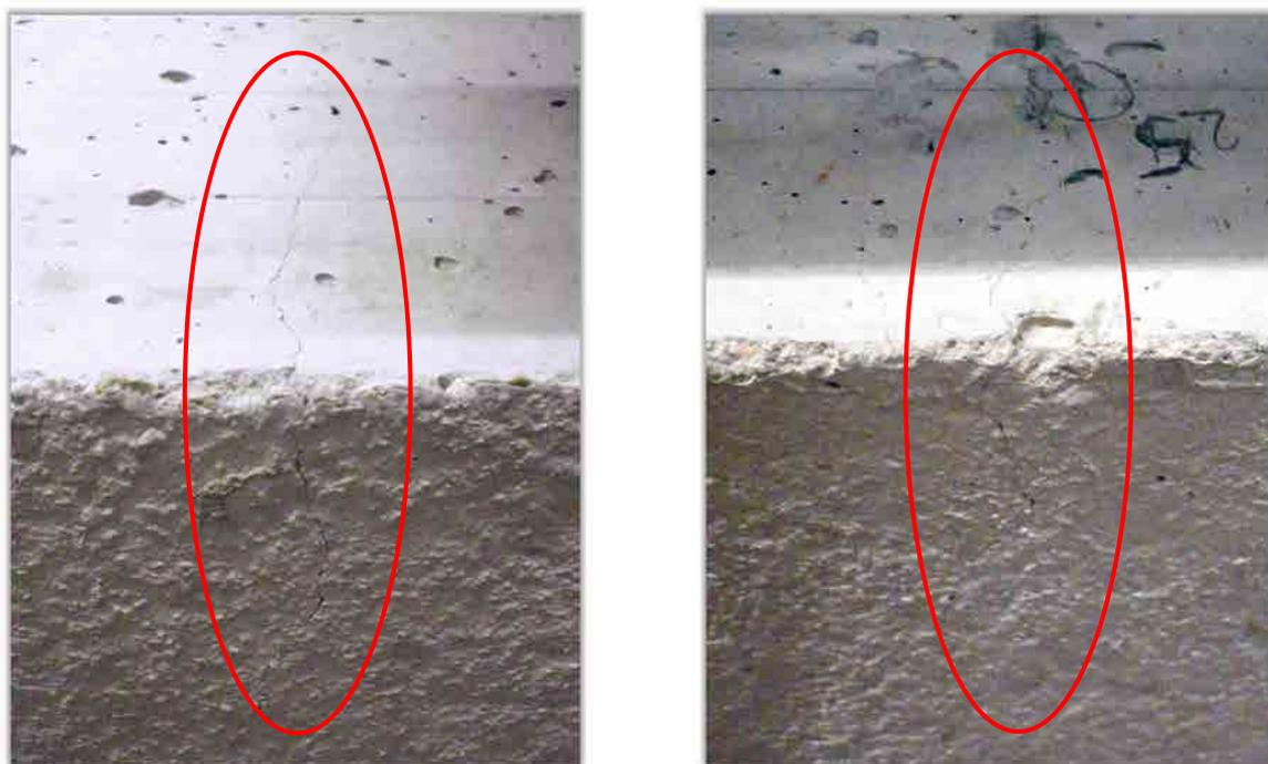
**Figura C.41 Fisuras aparecidas durante el transporte y/o acopio de la viga M-A4R3-02.**
