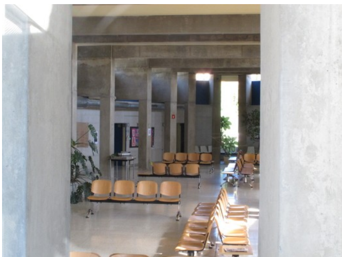
Il·lustració 135: Centre d'Assistència Primària a Sant Hipòlit de Voltregà, Barcelona (1984-1986). Viaplana/Piñón, arqts. [Autora. Fotografia de 2012]
