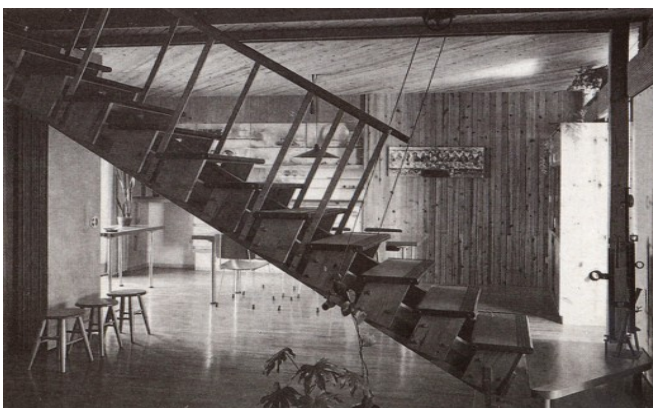
Il·lustració 32: Escala desplegada a l'habitatge de l'arquitecte al carrer Àngel Baixeras 7, Barcelona (1956-1976). Moragas i Gallissà. [FAD 1989, p. 30]
