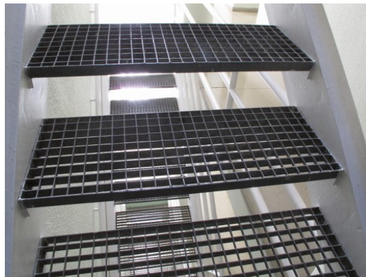
Il·lustració 93: Edifici d'habitatges al carrer Galileu 281-285, Barcelona (1974). Mora/Piñón/Viaplana, arqts. [Autora. Fotografies de 2013]
