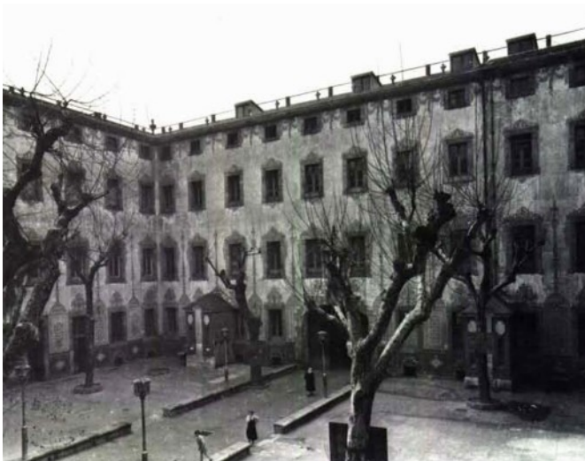
Il·lustració 239: Estat de l'antiga Casa de Caritat al 1982. [ITeC 1982]
