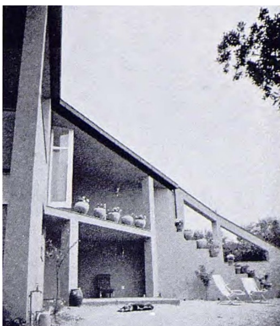
Il·lustració 83: Casa Puig, L'Ametlla del Vallès. Barcelona (1973). Mora/Piñón/Viaplana, arqts. [Mora, Piñón, Viaplana, 1976]
