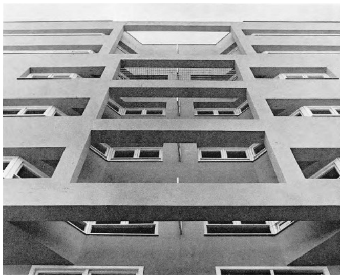
Il·lustració 89: Edifici d'habitatges al carrer Galileu 281-285, Barcelona (1974). Mora/Piñón/Viaplana, arqts. Fotos: F.Català-Roca [Mora, Piñón, Viaplana, 1976]
