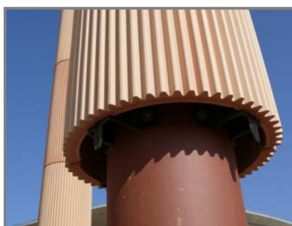
Pieza en proceso de colocación Muestra del sistema de sujeción, entre piezas y al pilar expuesta en Taller Cumella Foto: María Celina Vacca
