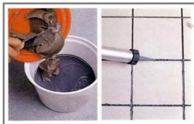
Colocación de mortero en base a resinas epoxi de dos componentes por medio de pistola.
