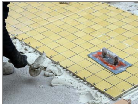
Colocación de los pavimentos
