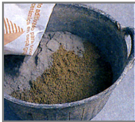
Balde de mezcla de mortero para colocación por capa gruesa.
