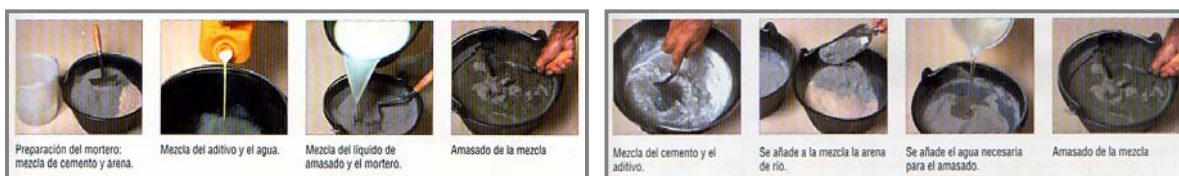
Preparación de mortero con aditivo líquido polvo
