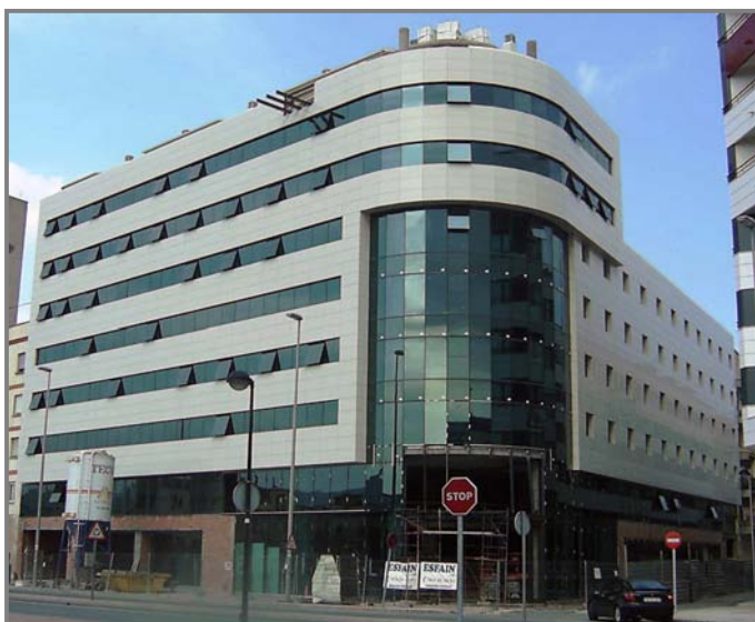
Hotel Luz Castellón. Fachada ventilada con piezas de gres porcelánico
