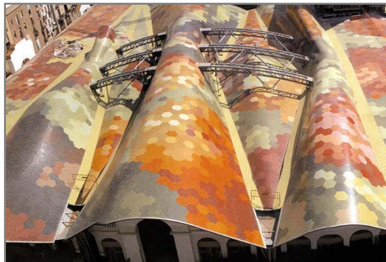
Vista parcial de la cubierta
