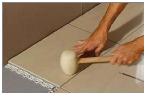
Corte y colocación
