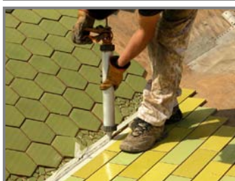
Tareas de rejuntado
