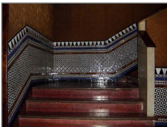
Escalera con arrimadero de azulejos sevillanos
