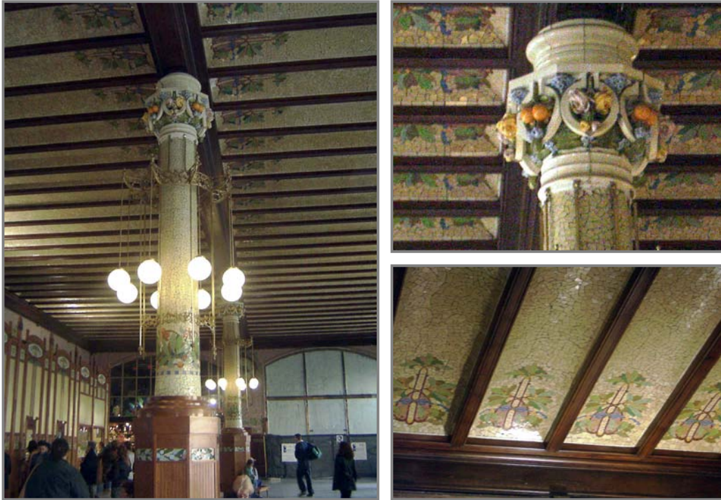
Detalles de la columna del vestíbulo de la Estación del Norte en Valencia. Relieves probablemente producidos por La Ceramo, Valencia, 1906 – 1917 y detalle de techo, con bovedilla revestida de trencadís.
