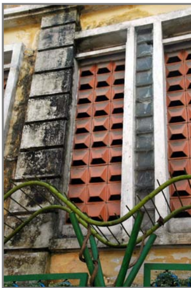
Pieza para celosía fotografiada en Saigón (Vietnam); la forma solapa una abertura que evita la entrada de agua de lluvia y sol, y permite la entrada y circulación de aire. Usada en varios edificios coloniales franceses, es de terracota, de alrededor de los años '20, y mide entre 15 x 15 cm o 20 x 20 cm aproximadamente.
