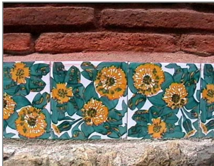
Mayólica utilizada por Gaudí en la Casa Vicens (1882/88) y restaurada por TAU Cerámica usando la misma técnica de fabricación y los mismos materiales.
