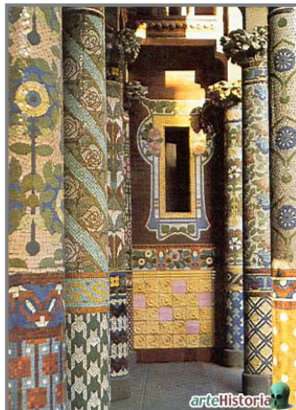
Fachada y columnas revestidas de trencadís
