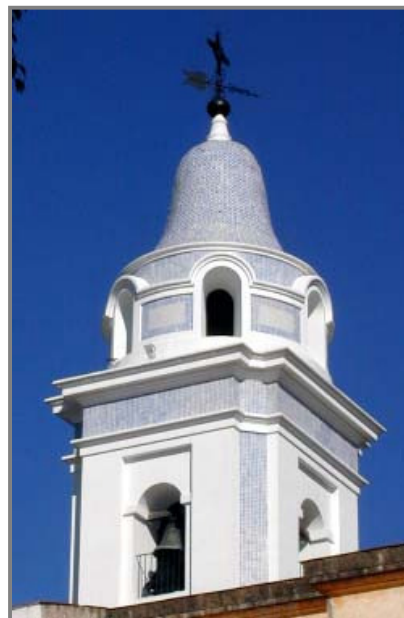
Torre y cúpula revestidas con azulejos franceses del Pas de Calais
