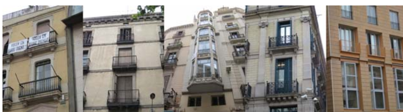
8.81. Fotos balcones edificios.
