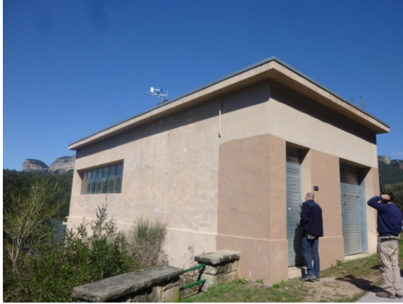
Figura 23. Estación meteorológica situada en el tejado de la caseta propiedad de ATLL.
