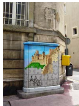
» figura 3.11: Intervención en armario de servicios. Carcassonne, Francia.
