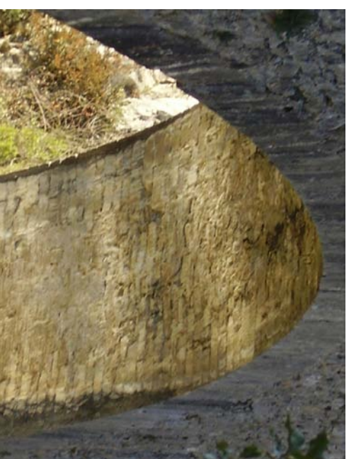
5. Bóveda en la clave
