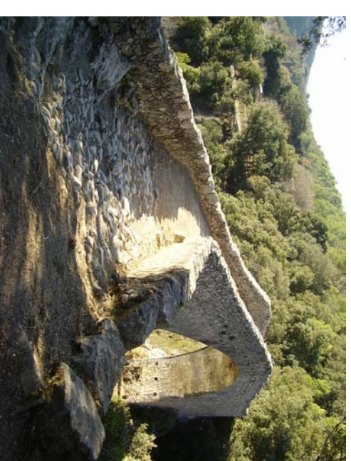
3. Calzada desde la orilla izquierda
