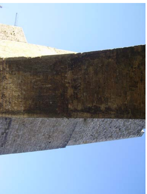
5. Bóveda del arco sexto
