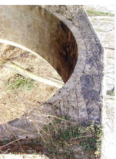
6. Bóveda y paramento visto desde aguas abajo
