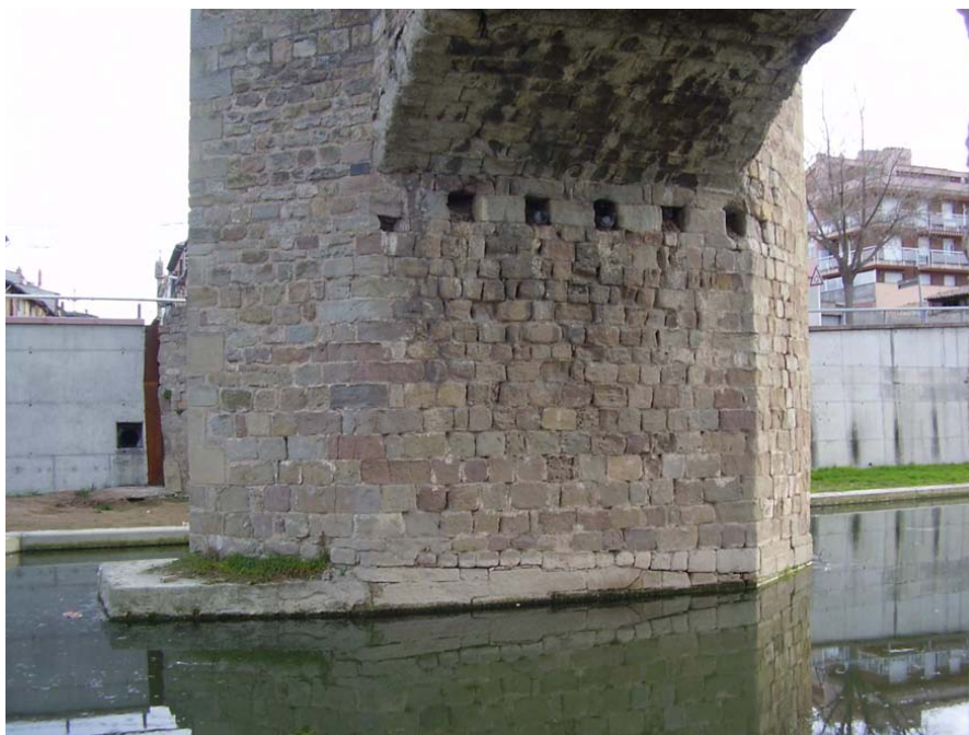
Imagen 5.3 Pila y arranque del arco quinto
