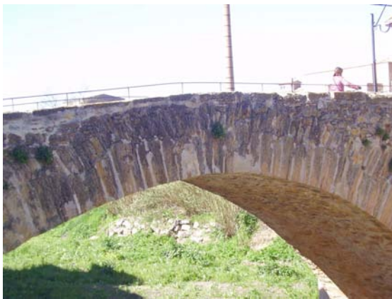
Imagen 9.5 A la izquierda: detalle de las dos roscas que forman las bóvedas.
