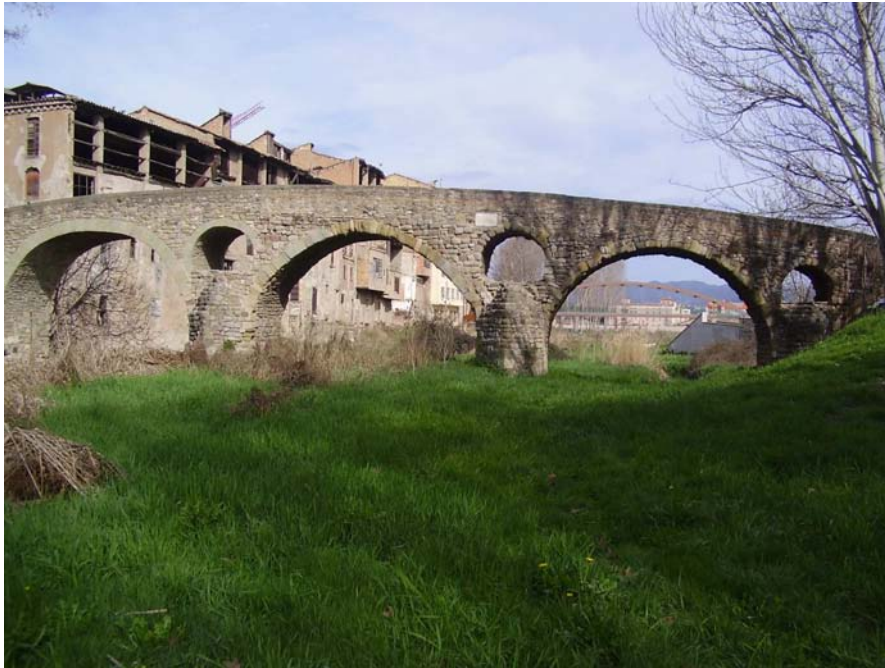
Imagen 6.1 Vista general del puente
