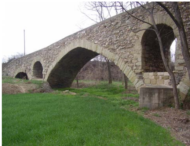
Imagen 7.7 Arcos cuarto y quinto y arquillos dos y tres.
