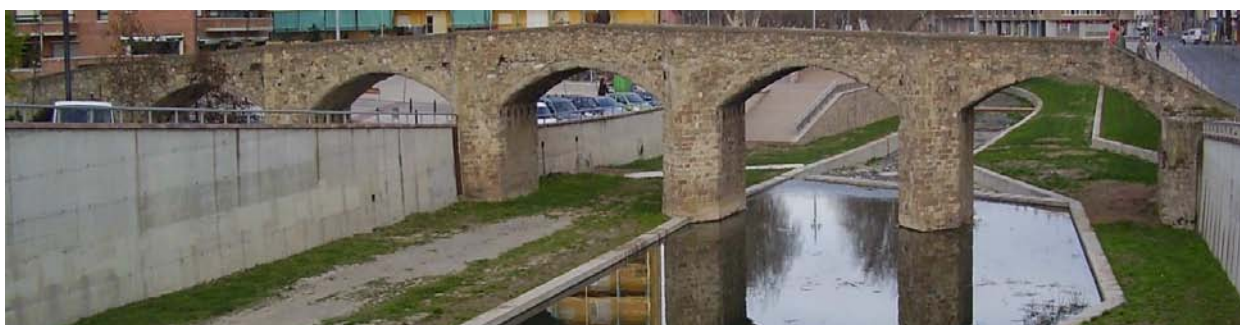
Imagen 5.1 Vista del puente desde aguas arriba.
