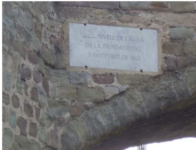
Imagen 5.5 Placa indicadora del nivel alcanzado por las aguas en la inundación del 5 de octubre de 1863
