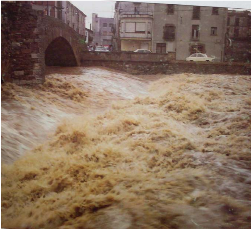
Imagen 9.13 Efecto de la sobreelevación provocada por el puente y por la forma de la escollera en una de las crecidas periódicas del río Daró , visto desde el margen derecho y aguas abajo. 1
