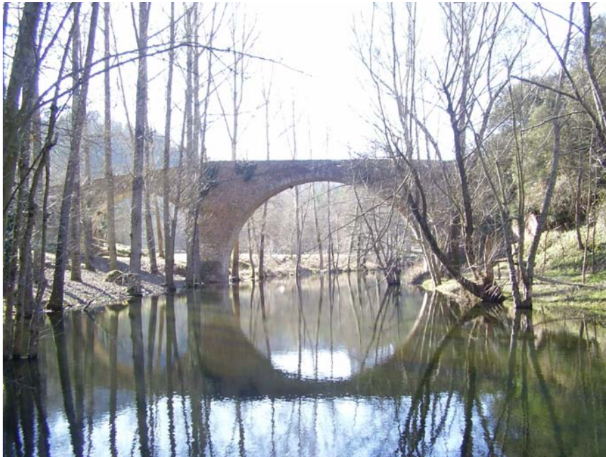
Imagen 8.1 Vista general del puente.
