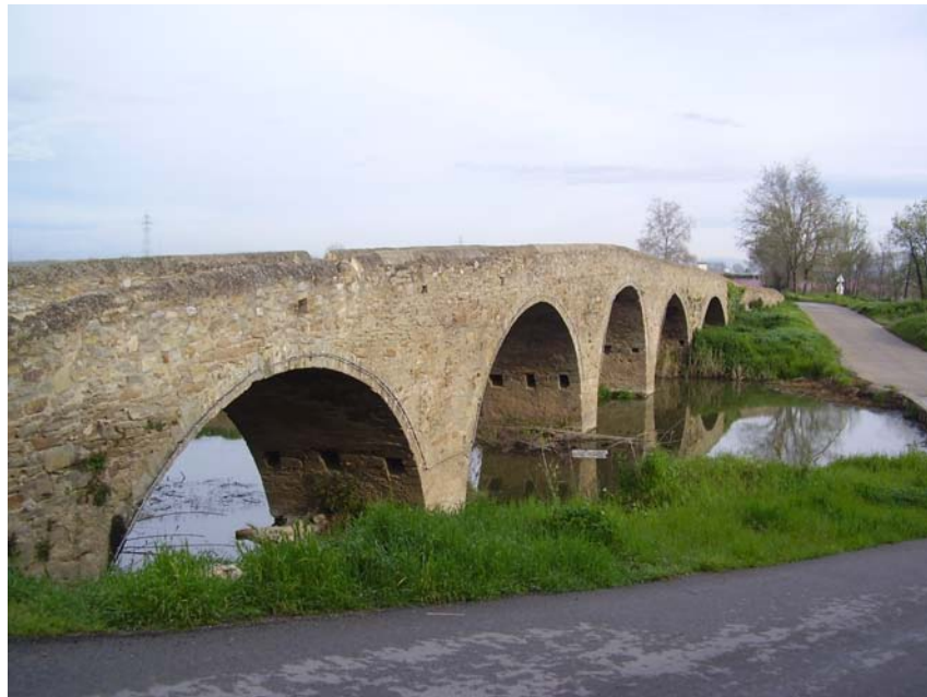
Imagen 10.1 Vista general del puente desde la orilla derecha aguas abajo
