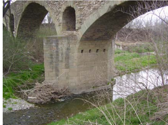
Imagen 7.5 A la izquierda: pila con espolón, entre la bóveda dos y tres.
