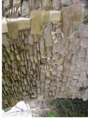
3. Arranque de bóveda
