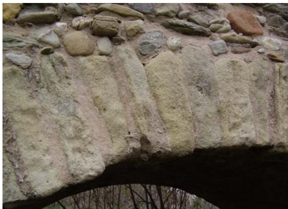
Imagen 7.8 A la izquierda: detalle de la boquilla y de la formación del paramento de los tímpanos
