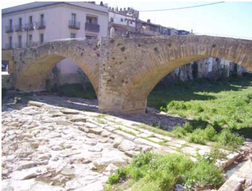
Imagen 9.7 A la izquierda: detalle de la escollera bajo la planta del puente vista desde el margen izquierdo y aguas abajo.
