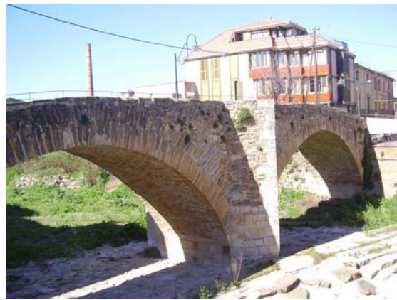
Imagen 9.5 A la izquierda: detalle de las dos roscas que forman las bóvedas.
