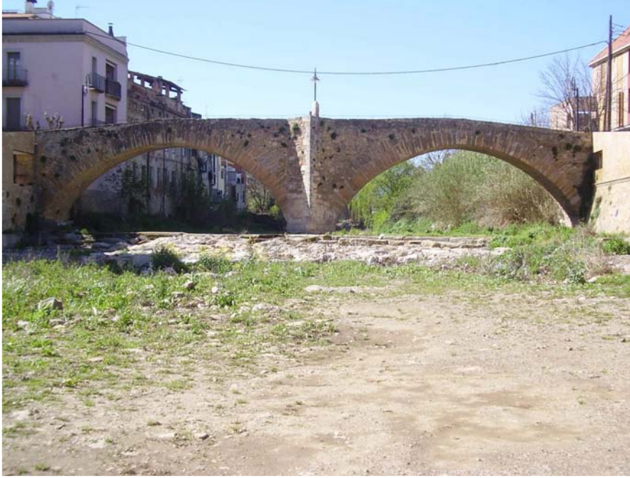
Imagen 9.1 Vista general desde aguas abajo.
