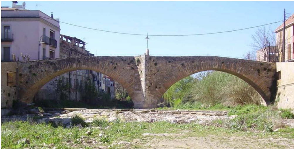
Imagen 9.4 Vista del puente desde el lecho del río aguas abajo.
