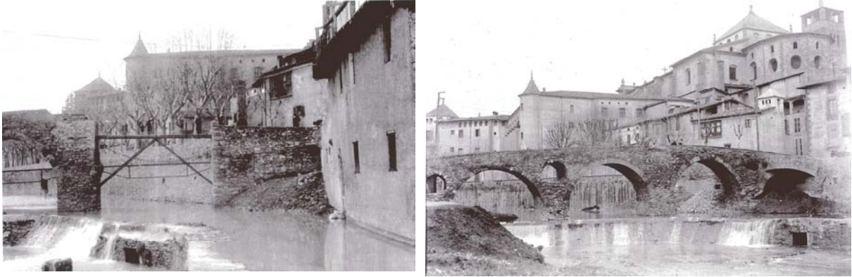
Imagen 6.13 A la izquierda: el puente con una pasarela en sustitución del arco uno volado durante 1939 visto desde el aliviadero del azud.
