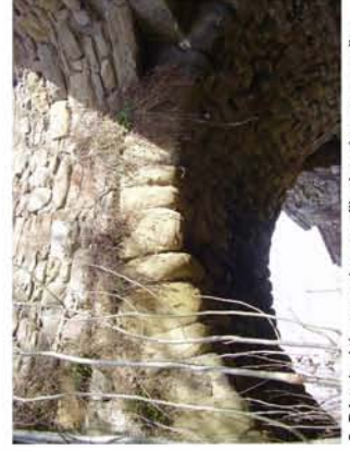
6. Bóveda del arco extremo orilla derecha, aguas arriba
