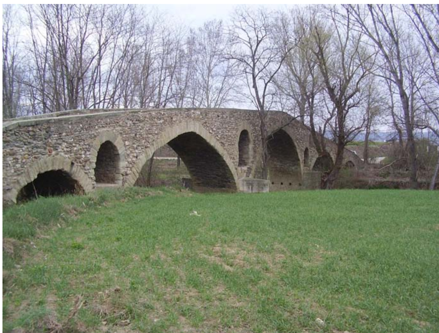
Imagen 7.1 Vista general del puente desde la orilla izquierda aguas arriba.
