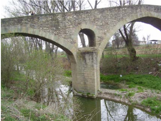
Imagen 7.5 A la izquierda: pila con espolón, entre la bóveda dos y tres.
