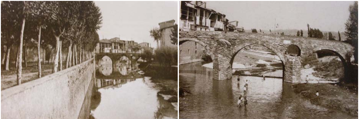
Imagen 6.11 A la izquierda: vista del puente desde el muro de encausamiento del lado izquierdo.
