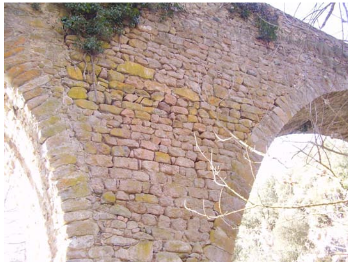
Imagen 8.7 Paramento de la zona entre bóvedas visto desde aguas abajo
