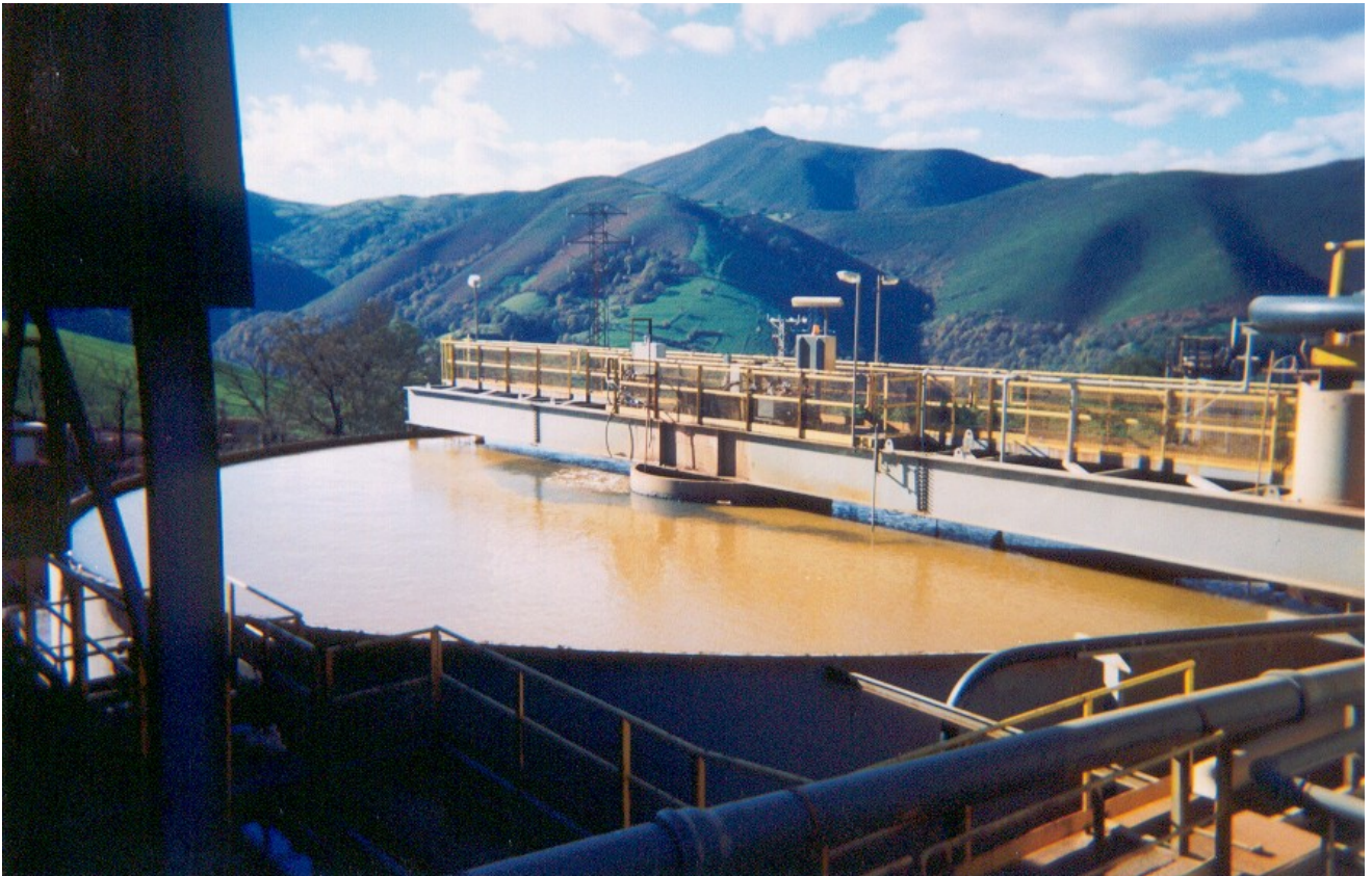
Figura 4.1. Vista de un tanque de lixiviación cianurada (Planta El Valle-2002)
