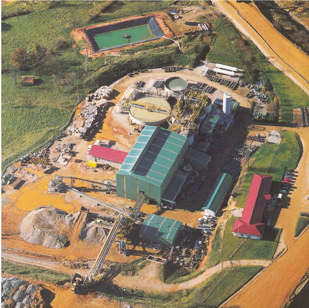
Figura 4.4. Vista de la planta de tratamiento El Valle (Boinás)
