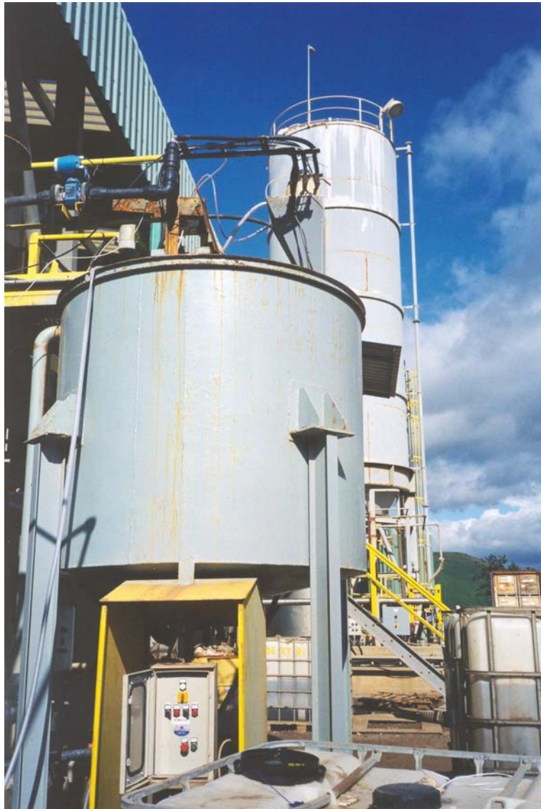
Figura 6.10.- Vista general de la planta piloto.
