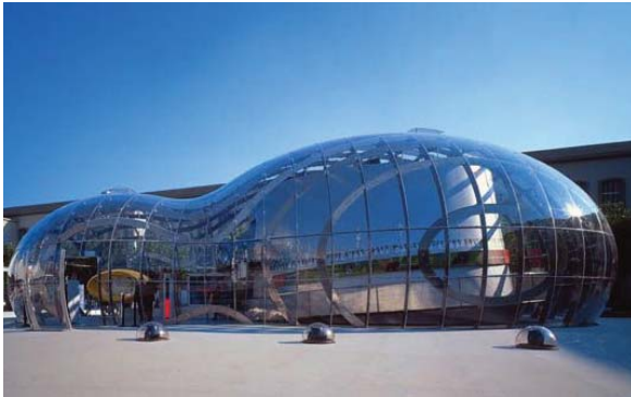
ABB + Franken Architekten, pabellón BMW, 1999
