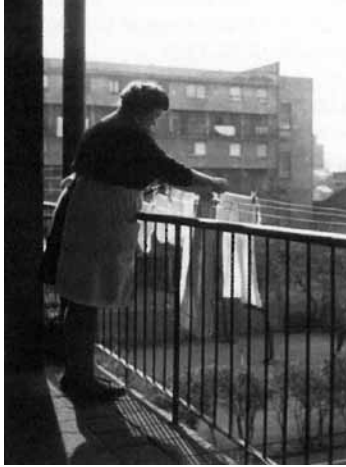
7.22 Casa Bloc, Barcelona, GATCPAC. Fotografía del pasillo de acceso.
