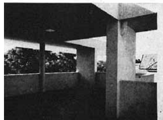
5.4 Casa en Villa del Parque. Sistema Helios. Wladimiro Acosta.
