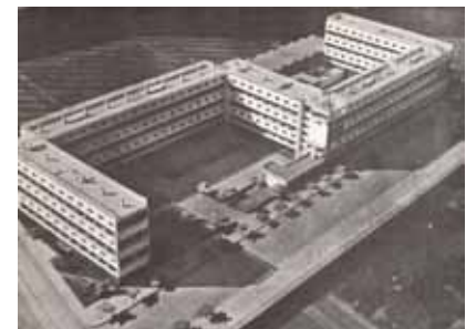
6.49 Casa Bloc. Foto aérea del conjunto.
