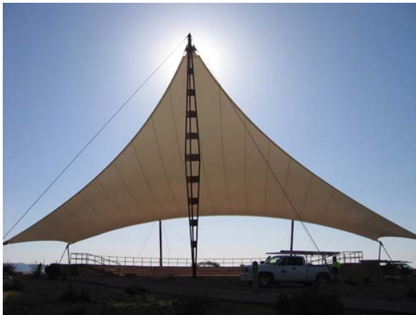
fig. 1-16 Lámina textil con revestimiento de PVC.
