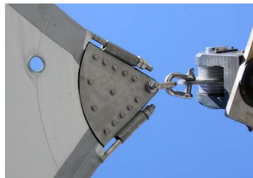
fig. 1-11 Puño de tesado puntual.
