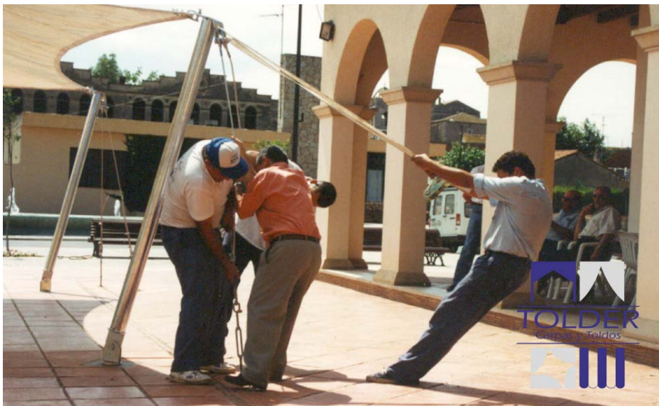
fig. 1-12 Operarios tesando con pocos medios una estructura.
