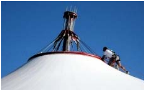
fig. 1-10 Cabeza de tesado superior de un conoide.
