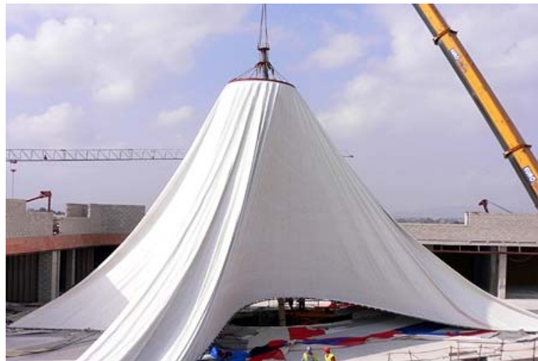
fig. 1-92 Proceso de montaje de un conoide.
