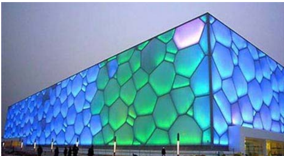
fig. 1-62 Piscina Olímpica Beijing 2008.
