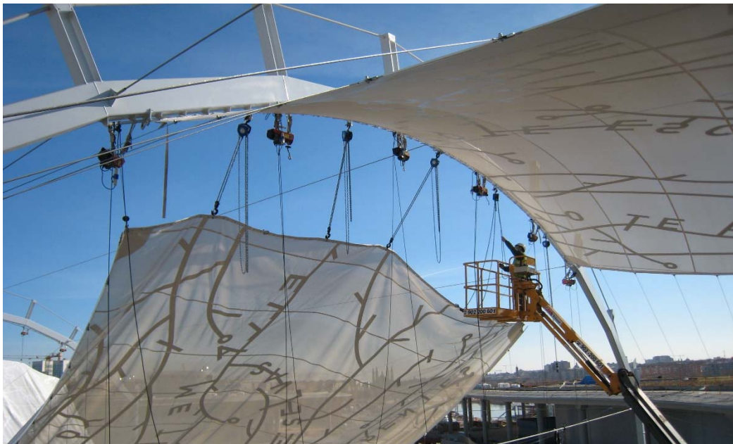
fig. 1-102 Proceso de tesado de una superficie textil en la expo de Zaragoza.
