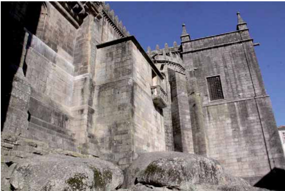
Fig. 70 - Vista de la capilla mayor desde el exterior. Pedro Sobral.
