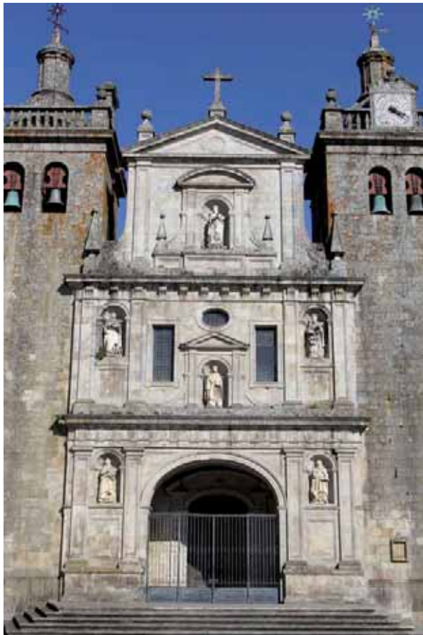
Fig. 67 - Fachada de la catedral. Carlos Alves..
