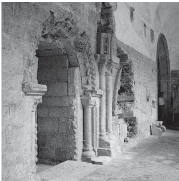
Fig. 85 - Descubierta del claustro gótico de la catedral. IHRU.
