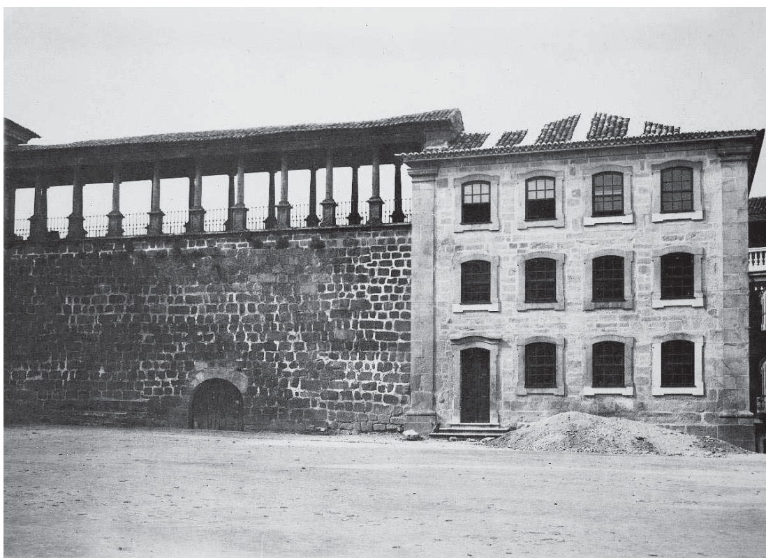
Fig. 28 - Remodelación del muro sur entre la torre y la catedral. IHRU.
