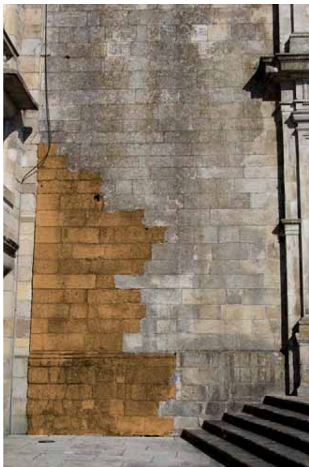
Fig. 66 - Vestigios de la primitiva torre señalados a rojo. Carlos Alves.
