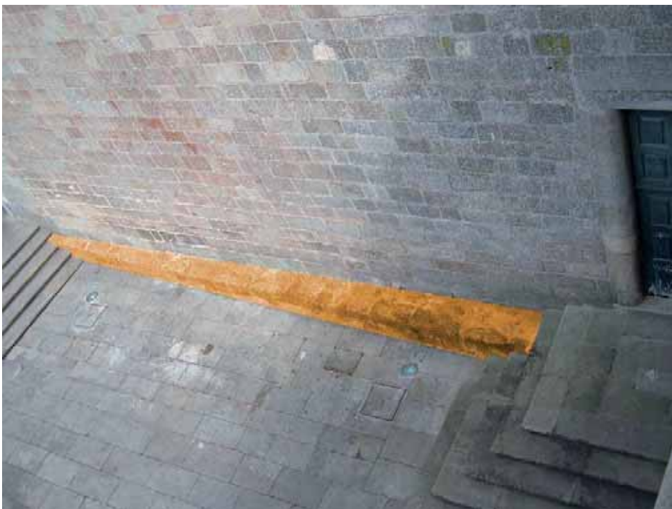
Fig. 38 - Muro exterior del claustro gótico. Carlos Alves.
