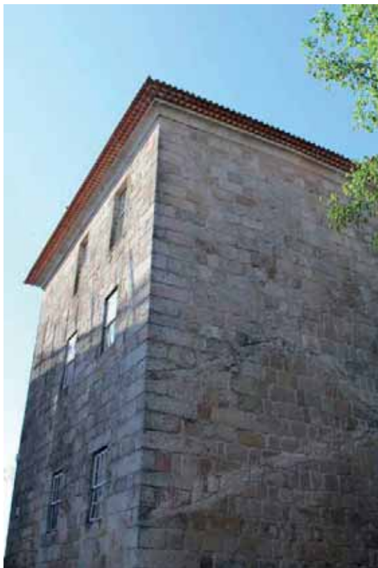
Fig. 22 - Detalle de los sillares utilizados en la reconstrucción de la torre. Carlos Alves.
