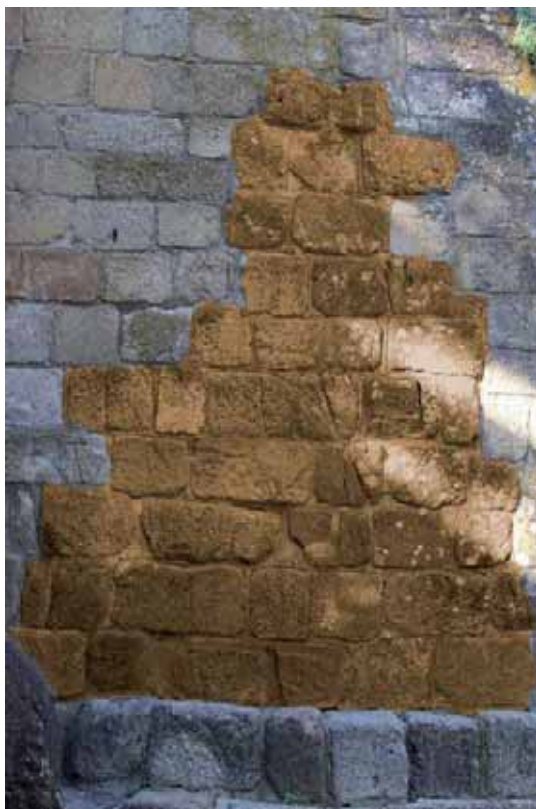
Fig. 14. Diferenciación constructiva en la torre sureste. Carlos Alves.
