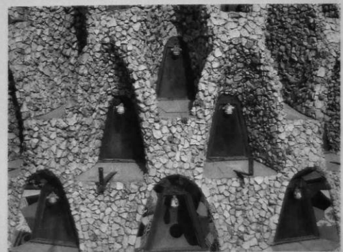
Fig. 12.—Revestimiento de azulejo troceado en el intradós de las hornacinas de la base de la linterna y restos de la iluminación artificial moderna. (Foto Jordi Isern, febrero de 1990).
