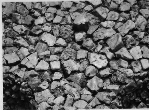
Fig. 9.—Fragmentos de roca arenisca vitrificada usada como revestimiento de la linterna del Palau Güell. (Foto Jordi Isern, febrero 1990).
