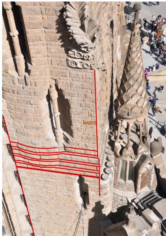
Il·lustració III-9 Filades amb el naixement de la base cilíndrica de la torre de Sant Bernabé
