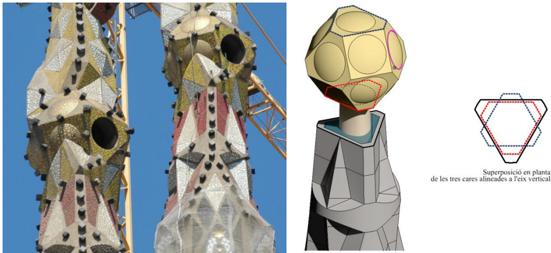
Il·lustració VI-29 Fotografies en detall de l'element i gràfic explicatiu de la relació entre la cara inferior de la macla i la base que la suporta.
