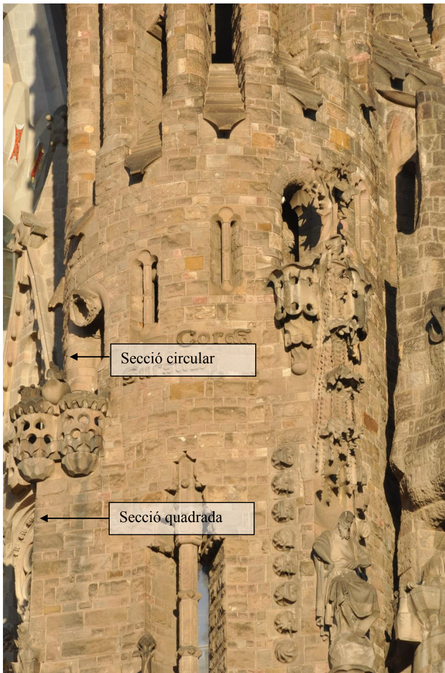
Il·lustració V-7 Fotografia del tram on es produeix el canvi de secció quadrada a circular. S'hi veuen les dues alçades de les juntes 21cm+42cm
