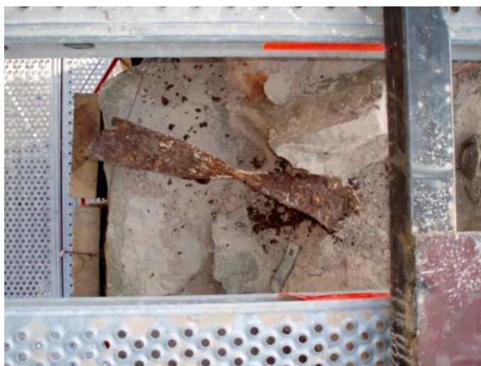
Il·lustració IV-39 Fleix dins el massís del pinacle envoltant la part del nucli
