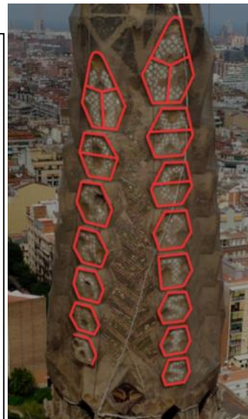
Il·lustració VI-2 Especejament dels blocs que contenen les lletres Hosanna i Excelsis
