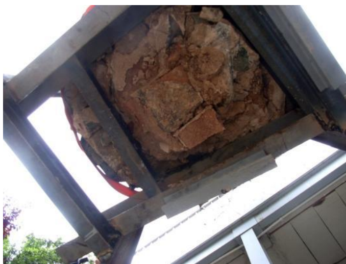
Il·lustració IV-38 Vista inferior de la base del coronament del pinacle un cop desmuntat per la seva restauració. Fotografia de Bis Arquitectes. S'identifiquen clarament la part del nucli, la part de pedra perimetral i la part de reomplert.
