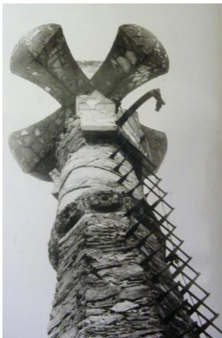
Il·lustració IV-37 estat de deteriorament del pinacle abans del 1983
