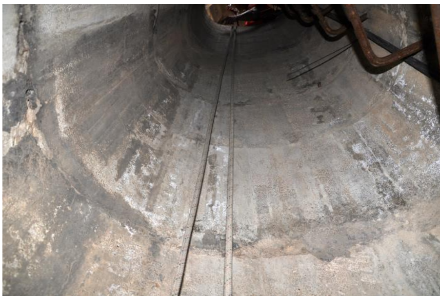
Il·lustració VI-21 Fotografia de l'últim tram de xemeneia fins la macla. S'hi veuen les marques de l'encofrat.
