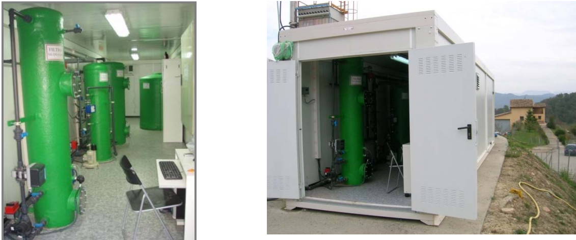
Figura 1.3. Instalación de los bio-filtros en el vertedero de Orís.
