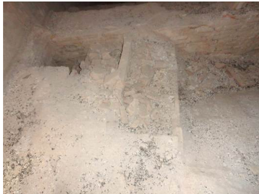
Fig. 103 Tabiquillos sobre bóveda capilla
