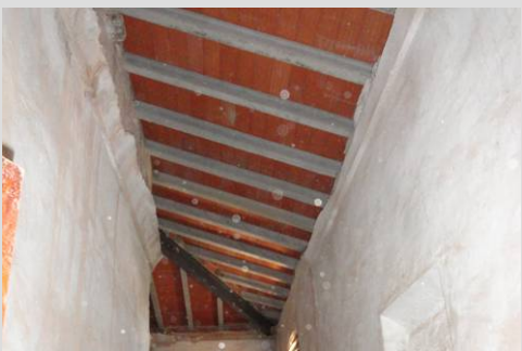
Fig.6 Sustitución de la cubierta (zona posterior)
