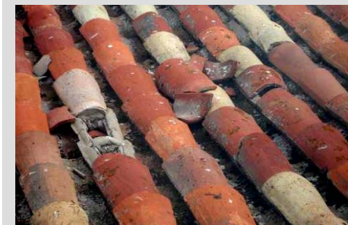
Fig. 44 Rotura tejas
