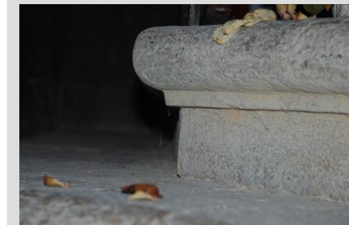
Fig. 34 Escalón altar de piedra caliza
