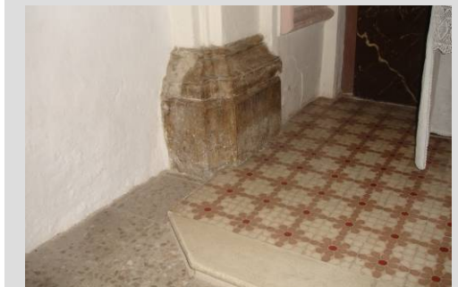
Fig. 32 Solado de baldosa hidráulica y terrazo (capilla lateral)
