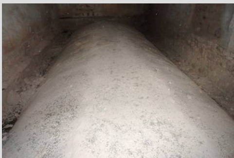
Fig.31 Extradós bóveda capilla
