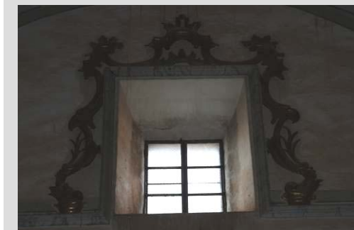
Fig. 18 Ventana desde interior
