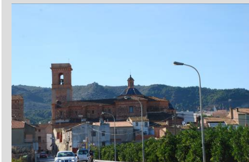
Fig. 3. Vista desde la CV-320
