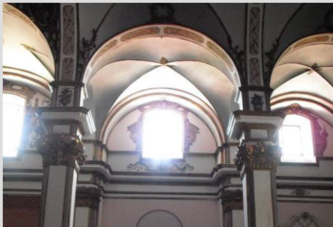
Fig.7 Bóvedas de cañón (nave central)
