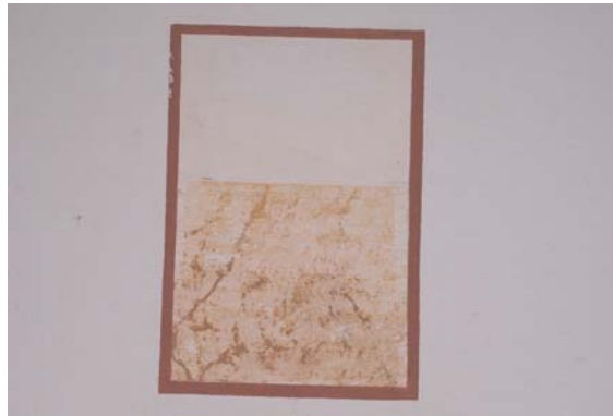
Fig. 200 Estado revestimiento en 2001
