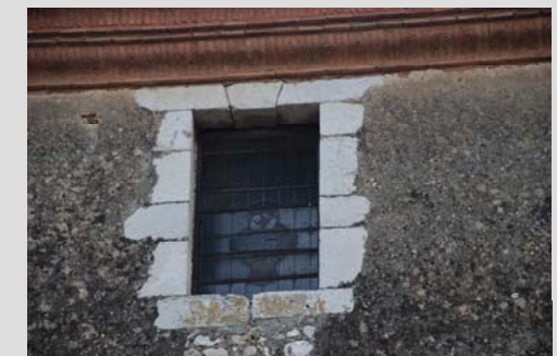
Fig. 10 Ventana naves laterales (Vista exterior)
