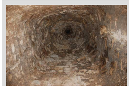
Fig. 26 Remate torre cúpula por aproximación
