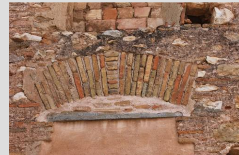
Fig.29 Formación dintel
