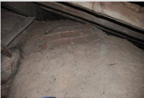
Fig. 39 Bóveda doble arista
