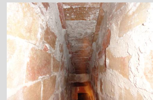
Fig. 47 Tabiquillos y tablero cubierta nave
