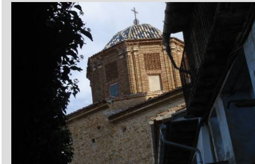
Fig. 8 Cúpula: vista exterior
