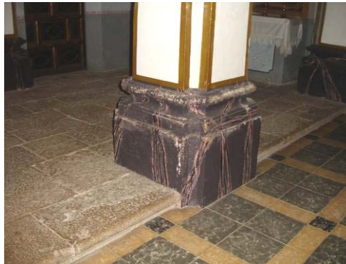
Fig. 92 Baldosas hidráulicas y pétreas
