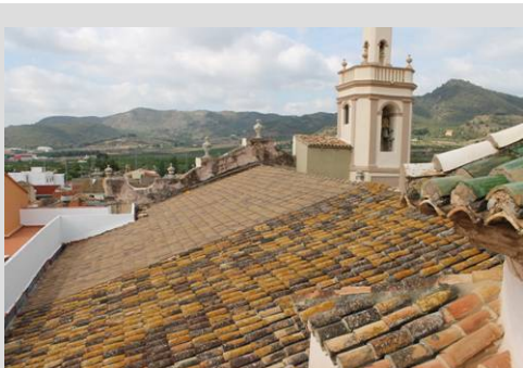
Fig.5 Reparación de la cubierta (zona pies)
