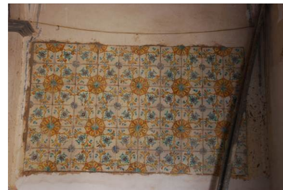
Fig. 72 Recolocación baldosa cerámica
