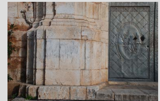
Fig. 20 Detalle portada: pilastra y retropilastras
