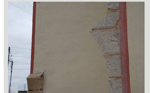
Fig. 27 Arranque arcos (Detalle)
