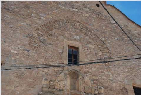
Fig.25 Muro de mampostería ordinaria
