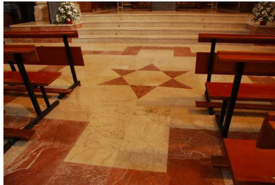
Fig. 140 Solado nave: mármol
