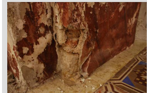
Fig. 26 Pilastra toral de mampostería
