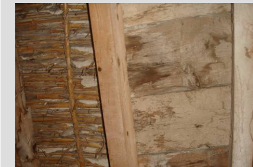
Fig. 50 Enlatado de tablas y de cañizo
