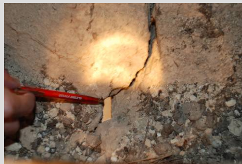
Fig. 56 Fisura cúpula
