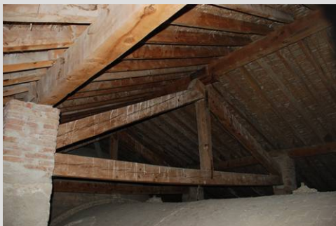
Fig. 51 Cercha de cubierta
