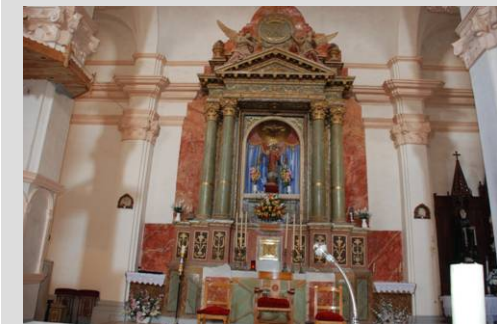
Fig. 56 Altar mayor: estuco. Muros interiores: enjalbegado
