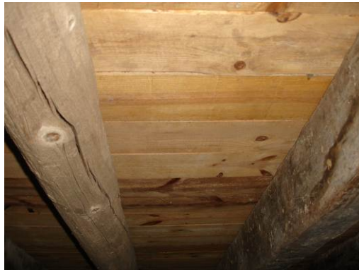
Fig. 34 Entablado de cubierta
