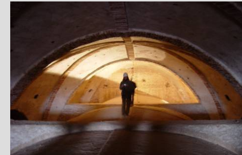
Fig.32 Bajocubierta sobre la n. central
