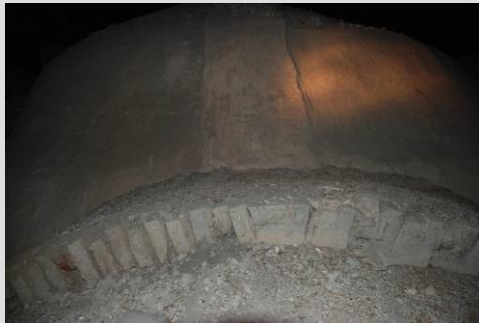
Fig. 24 Arco de piedra, costilla de la bóveda
