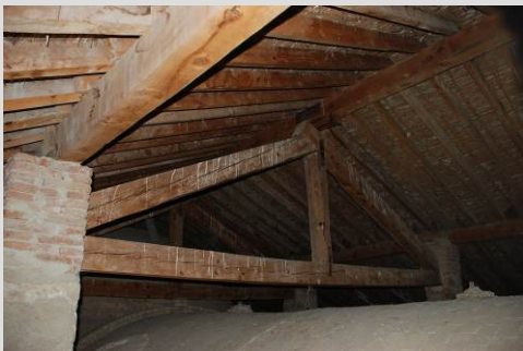
Fig. 9 Cubierta con cuchillo (Vilar de Canes)
