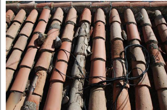
Fig. 177 Fisura cúpula y arco fajón
