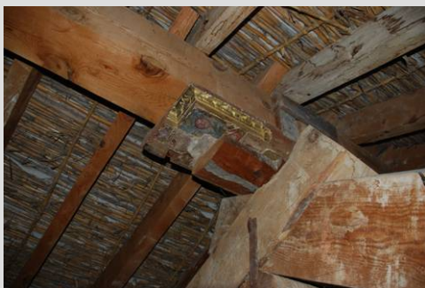
Fig. 28 Tabla policromada entre la viga cumbreira y la cercha
