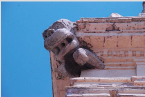
Fig. 24 Gárgola de piedra caliza
