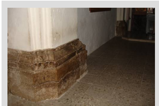
Fig. 30 Basa pilastras nave (caliza)
