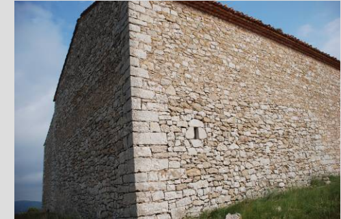
Fig. 23 Muro evangelio y hastial
