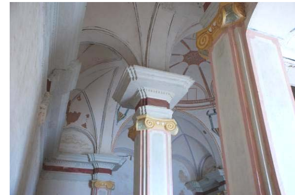
Fig. 66 Vista general nave derecha
