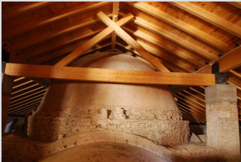
Fig.27 Bajocubierta: cúpula y entramado de madera
