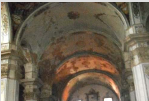
Fig. 13 Iglesia de la Purificación y San Blas, Puertomingalvo – Teruel (1734)
