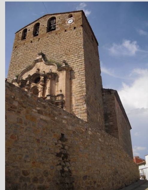
Fig.2 Imafrente y fachada epístola
