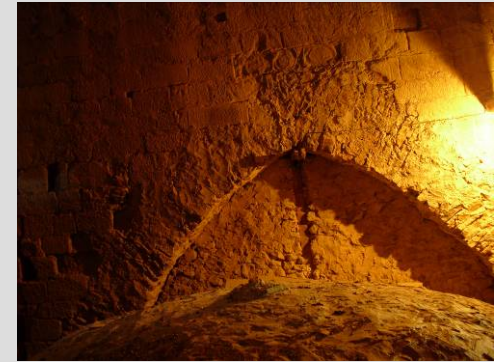
Fig.15 Arco de descarga. Interior torre.
