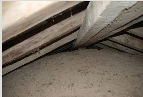
Fig. 54 Apoyo directo sobre cúpula
