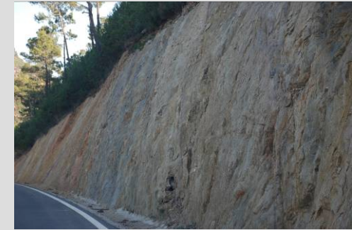
Fig.22 Corte del terreno en las proximidades de Montán
