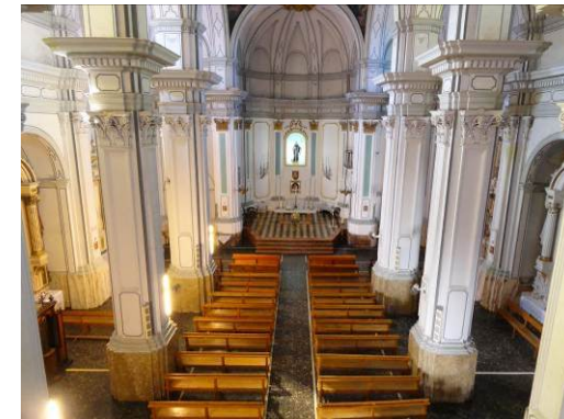
Fig. 9 Vista general: pilares
