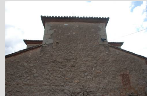
Fig. 23 Muros lado posterior
