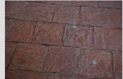
Fig. 58 Solado original: baldosa cerámica artesanal
