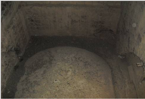
Fig.24 Extradós bóveda coro
