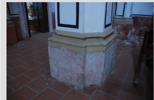
Fig. 33 Sillar de caliza para la basa
