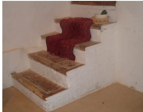
Fig. 176 Escalera sacristía, solado (XX)
