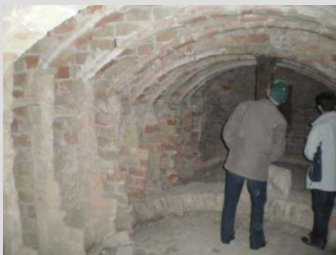
Fig. 2 San Vicente de Piedrahita (bajocubierta)
