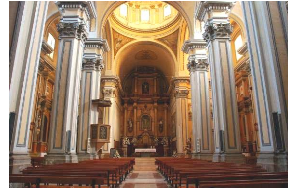
Fig. 138 Vista general: pilares
