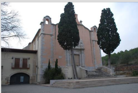
Fig. 14 Escalinata de acceso
