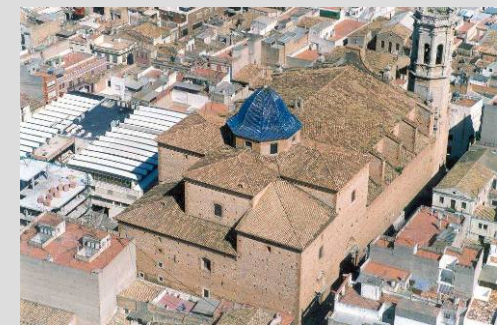
Fig.3 Vista aérea fachada posterior ( http://www.cult.gva.es )
