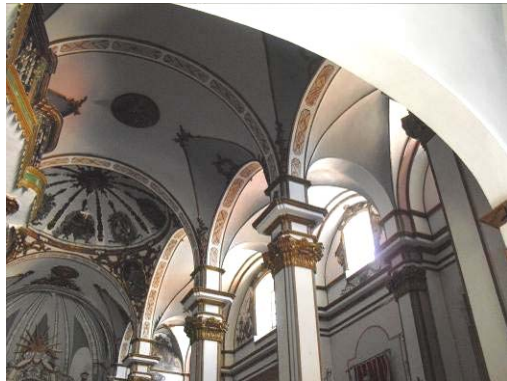
Fig. 91 Tabiquillos tramo pies
