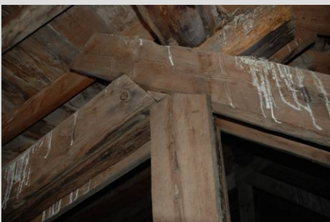
Fig. 52 Encuentro viga cumbre, jabalones y pendolón
