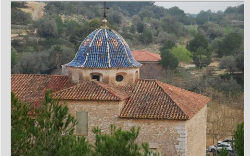
Fig. 31 Vista general cubiertas
