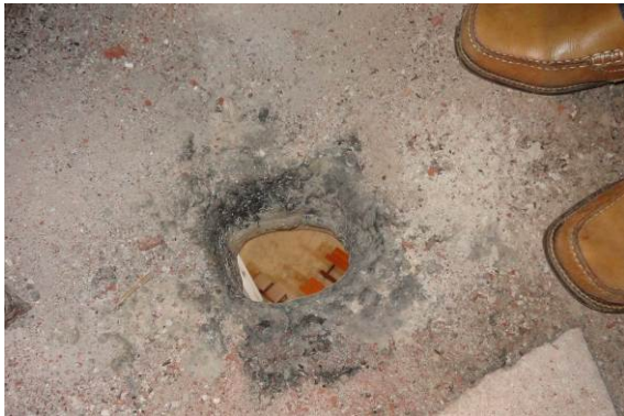
Fig. 139 Extradós bóveda nave central
