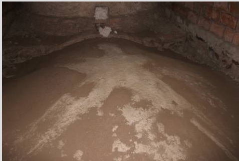
Fig. 36. Extradós bóveda arista (camarín)
