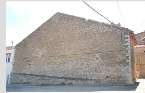
Fig. 20 Muro de cerramiento posterior
