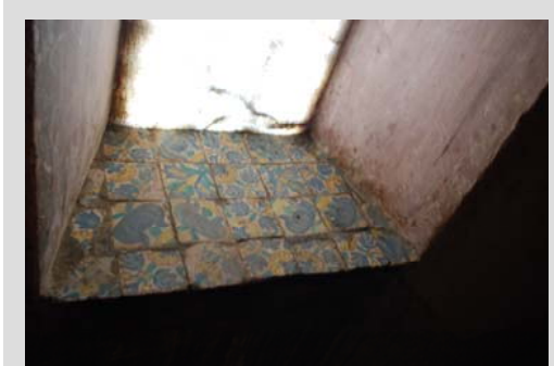
Fig. 42 Azulejería seriada (Ventana escalera)
