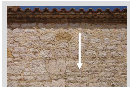
Fig. 36 Fisura vertical en fachada lateral
