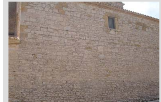
Fig. 15 Huella posibles ventanas
