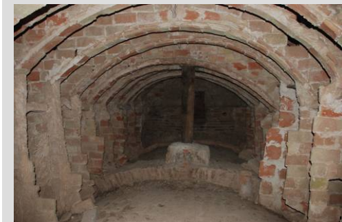
Fig. 28 Aligeramiento de tabiquillos. Macizado cúpula
