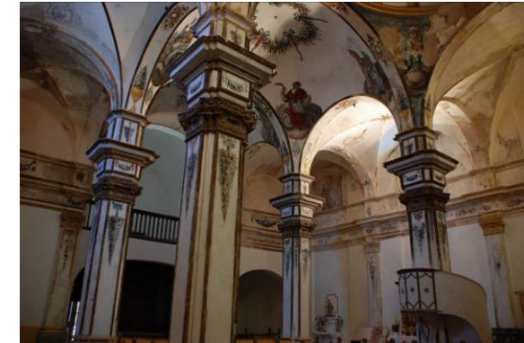
Fig. 33 Vista general: abovedamientos
