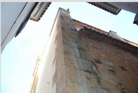
Fig. 44 Encadenado de sillares
