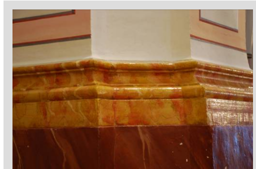
Fig. 7 Moldura basa ática
