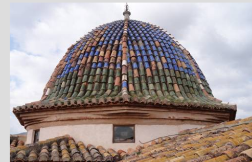
Fig.34 Teja vidriada (cúpula)
