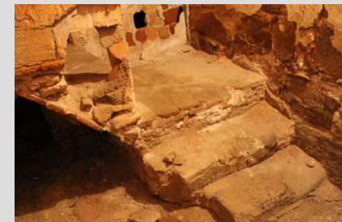
Fig. 40. Formación de la escalera de la torre
