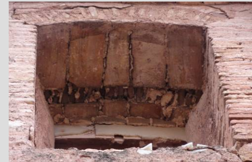
Fig.28 Formación jambas
