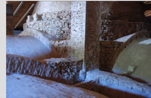
Fig.29 Estribos de los arcos y recrecido de la cúpula
