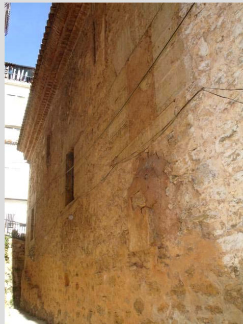
Fig.19 Muro fachada posterior
