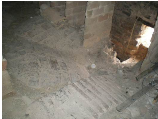
Fig. 127 Extradós bóveda pies
