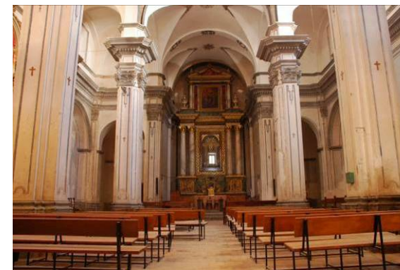
Fig. 78 Vista general: abovedamientos
