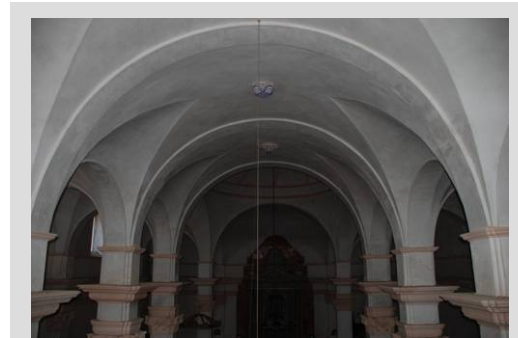
Fig. 14 Bóvedas de cañón con lunetos: nave central
