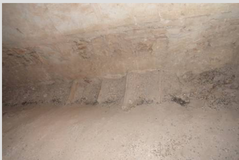
Fig.32 Lengüetas bóveda capilla
