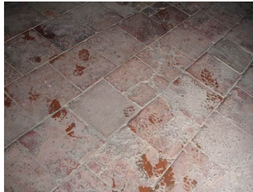
Fig. 128 Solado barro cocido
