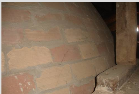
Fig. 46 Bóveda reconstruida (Crucero)
