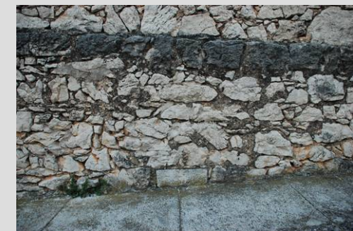
Fig. 38 Detalle muro piñón: primera piedra
