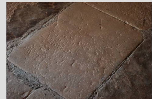
Fig. 47 Pétreo piconado. Capa mortero
