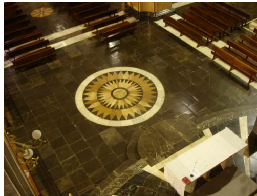
Fig. 188 Revestimientos y solados
