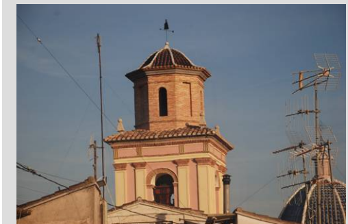
Fig. 9 Remate torre (después de la restauración de 1999)
