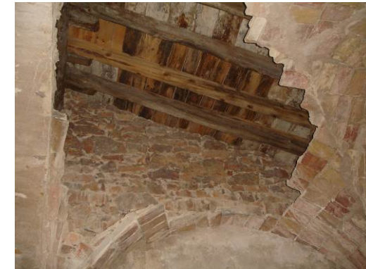
Fig. 36 Hundimiento bóveda almacén del coro
