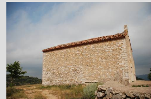
Fig. 15 Muro lateral derecho
