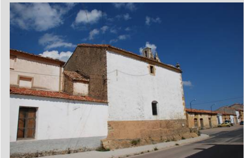
Fig. 2 Acceso desde Avda. Llosar
