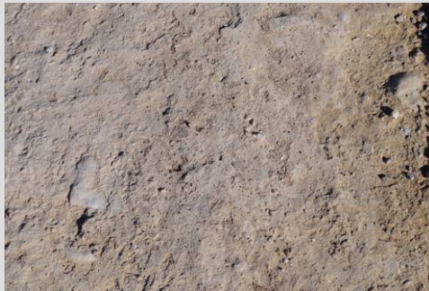
Fig. 12 Vía augusta a su paso por Benlloch: Detalle
