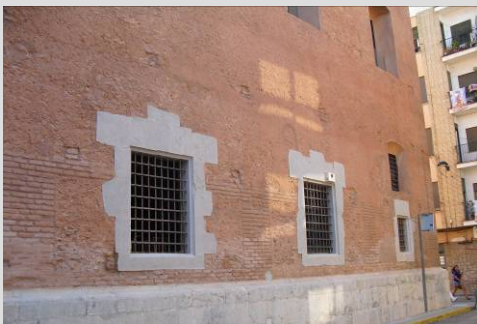
Fig.31 Mampostería verdugada Formación vanos: sillería, ladrillo
