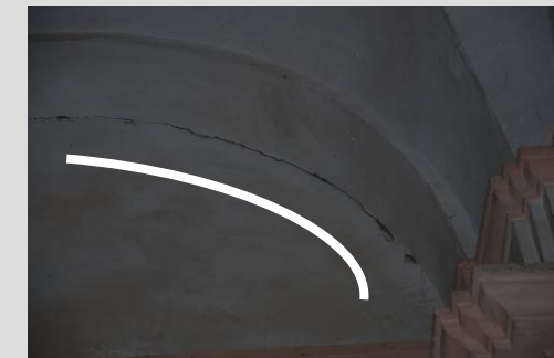
Fig. 51 Fisura perimetral
