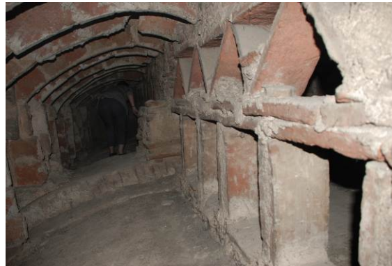
Fig. 55 Celosía y tabiquillos (bajo cubierta)
