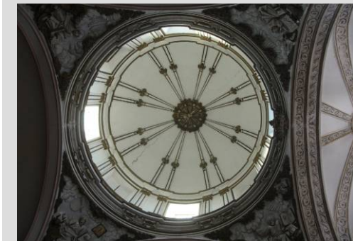
Fig. 9 Cúpula: vista interior
