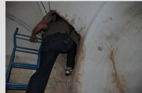
Fig. 14 Acceso zona bajo cubierta
