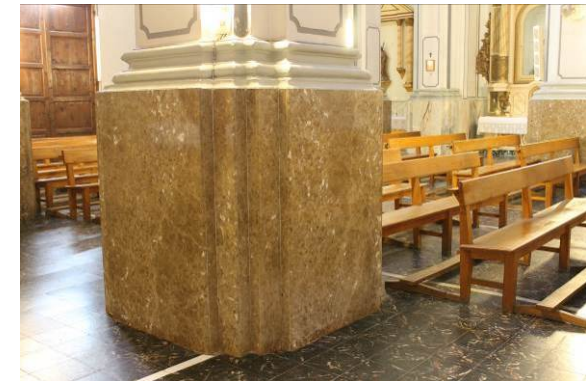
Fig. 3 Revestimiento basas
