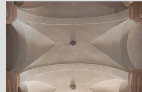
Fig. 55 Revestimiento de las bóvedas: cal
