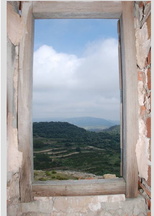
Fig. 29 Ventana de calida a la cubierta
