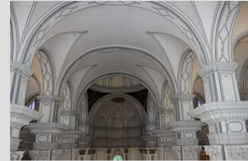
Fig. 12. Bóveda de cañón con lunetos
