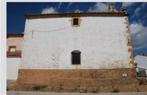
Fig. 24 Roca de cimentación
