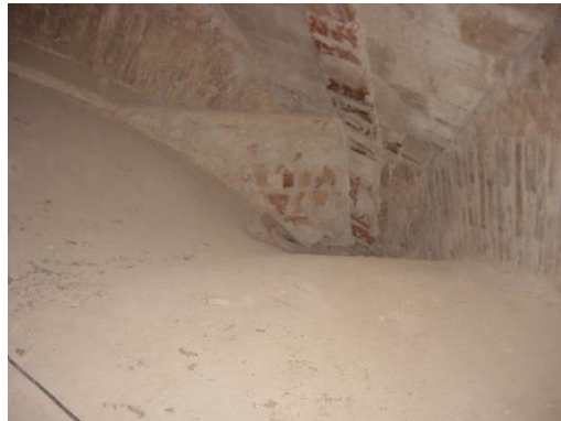
Fig. 187 Tabiquillos tramo pies
