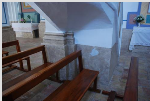
Fig. 31 Desconchado pilar del púlpito
