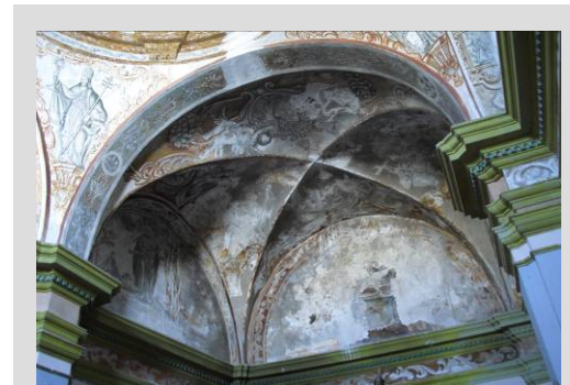
Fig.8 Bóveda arista (trasagrario)
