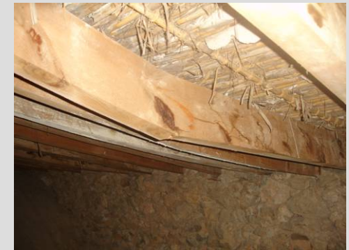
Fig. 65 Rotura cabio
