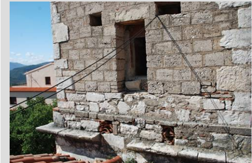
Fig. 43 Muro campanario: exterior
