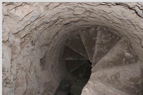
Fig. 13 Escalera de caracol (Quart de les Valls)
