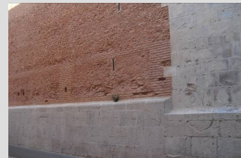
Fig.27 Sillería de Sagunto y de Benadresa
