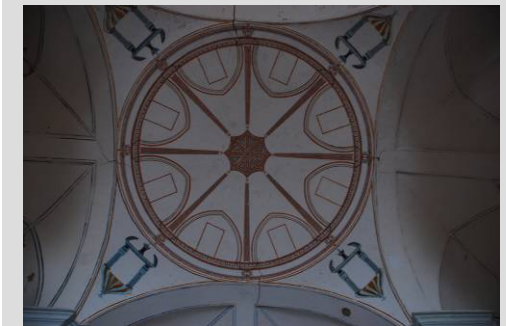
Fig. 10 Crucero: bóveda vaída
