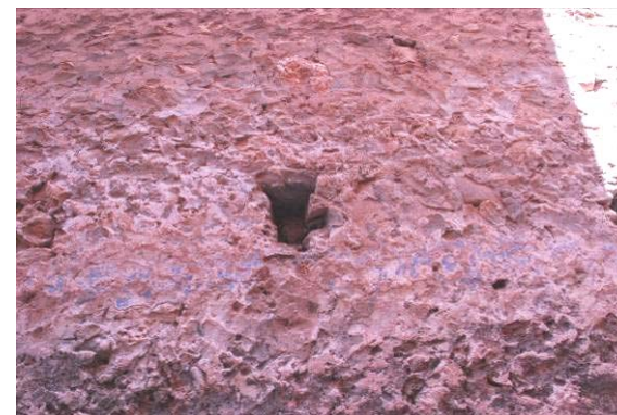
Fig. 114 Muro de mampostería ordinaria
