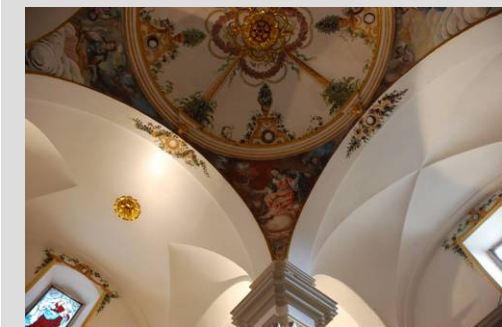
Fig. 10 Cúpula vaída (crucero)
