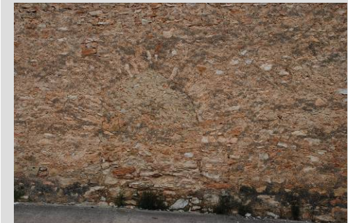
Fig. 19 Vano tapiado muro testero
