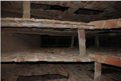
Fig. 65 Cubierta de tabiquillos cerámicos (San Vicente de Piedrahita)
