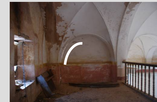
Fig. 52 Apoyo sobre cúpula
