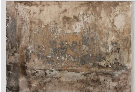
Fig. 42. Bajo cubierta zona pies
