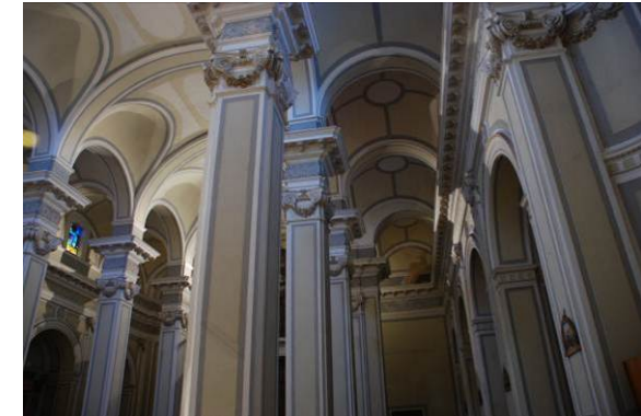
Fig. 54 Vista general: pilares
