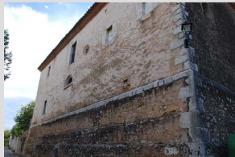
Fig. 29 Fachada posterior: zócalo y muro de mampostería.
