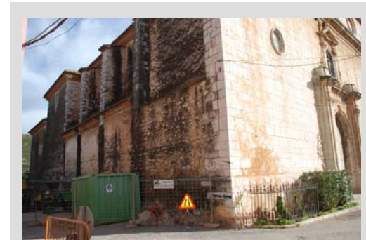
Fig. 24 Recrecido exterior muro (Primer tramo)
