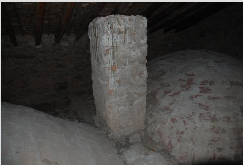
Fig. 56 Recrecido de pilar: mampostería (Vilar de Canes)
