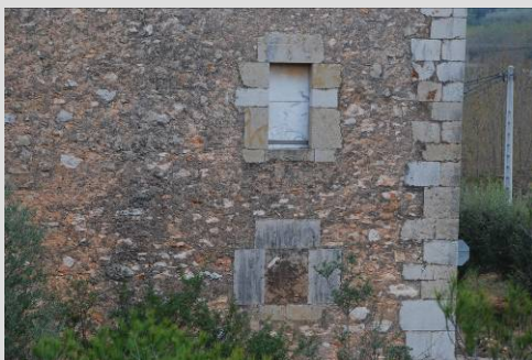
Fig. 28 Formación ventanas inferiores
