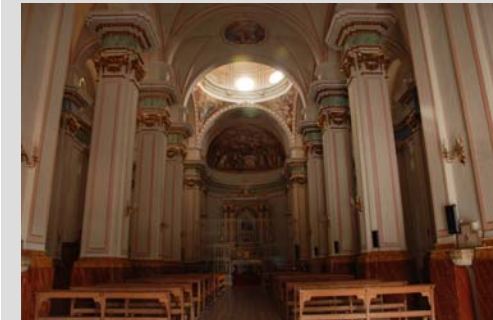
Fig. 12 Bóveda de cañón con lunetos
