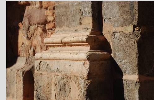
Fig. 32. Muro lateral: Zócalo de piedra y pilastras de ladrillo
