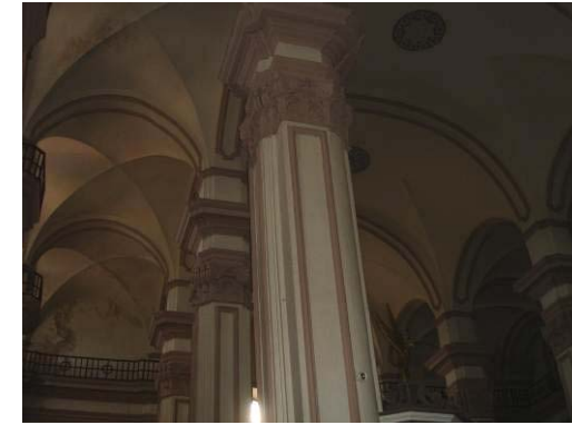
Fig. 45 Vista general: pilares
