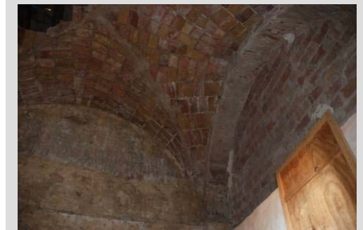
Fig. 27 Formación bóveda arista
