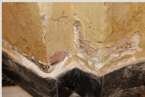
Fig.46 Desconchado por capilaridad
