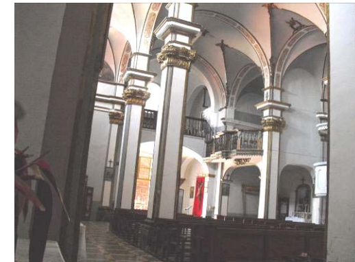
Fig. 90 Vista general: pilares
