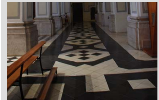
Fig. 43 Solado naves: baldosas hidráulicas
