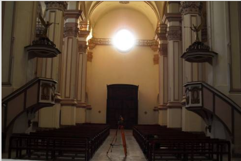
Fig. 33 Pandeo de los pilares
