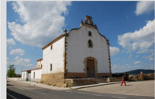
Fig. 12 Muro fachada evangelio
