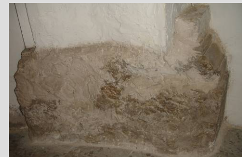
Fig. 38 Rotura antrópica de las basas (Brazo evangelio)
