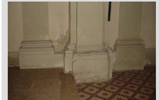
Fig. 31 Solado de baldosa hidráulica y terrazo (Capilla cabecera)
