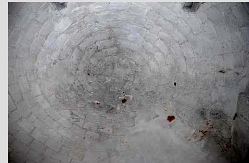
Fig. 46 Composición bóveda vaída
