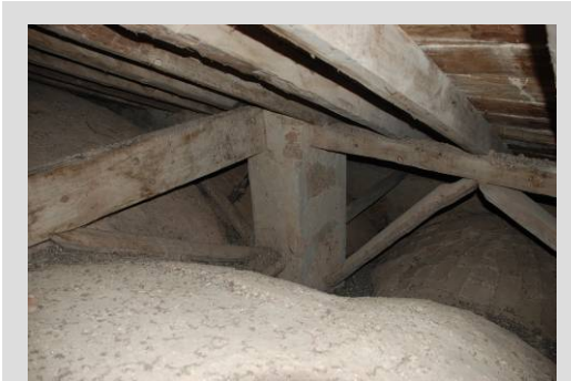
Fig. 35 Recreido de pilar
