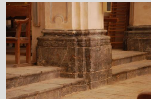
Fig.17 Escalones corridos en cabecera
