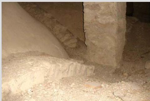
Fig. 25 Relleno de los riñones, recrecido de pilar de mampostería ordinaria
