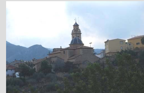
Fig. 2 Entorno (muro epístola y posterior)
