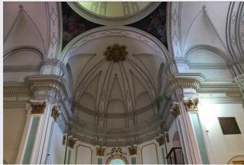
Fig. 26 Bóveda presbiterio (Benifairó de les Valls)
