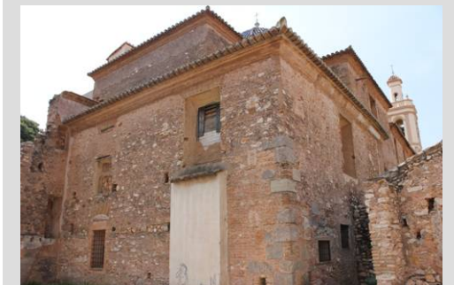
Fig.23 Ventanas fachada posterior
