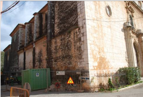
Fig. 52 Muros de sillería y mampostería ordinaria (Les Coves de Vinromà)
