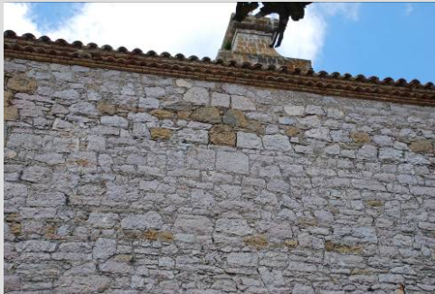
Fig. 23 Muro de calizas y margas
