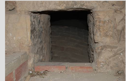
Fig. 18 Acceso a la zona bajo cubierta
