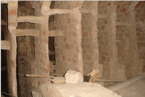
Fig. 25 Recreido de pilar y tabiquillos
