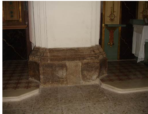
Fig. 47 Solados naves y capillas laterales
