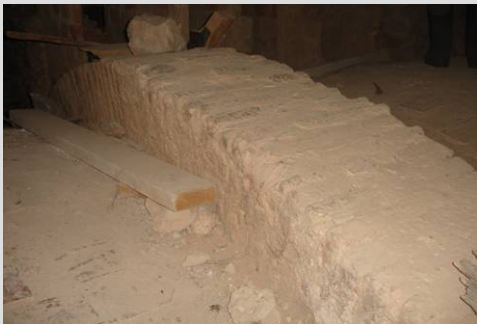
Fig. 26 Arco fornero (nave central)
