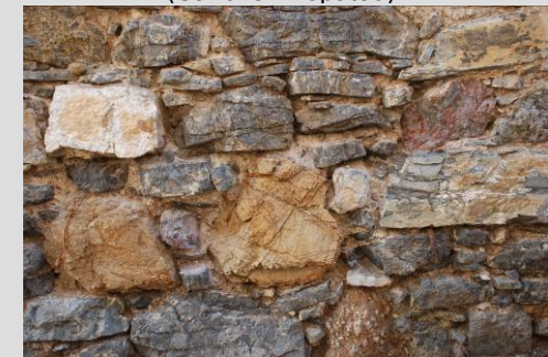
Fig.24 Muros de mampostería ordinaria
