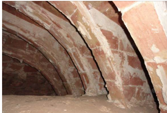
Fig. 10 Tabiquillos tramo pies
