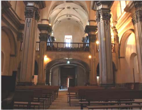
Fig.18 Vista interior hacia el coro
