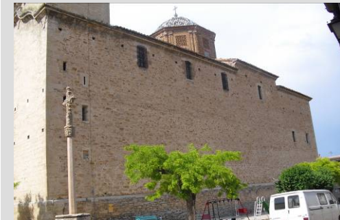
Fig. 13 Vanos (muro epístola)
