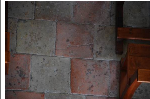
Fig. 153 Desgaste solado
