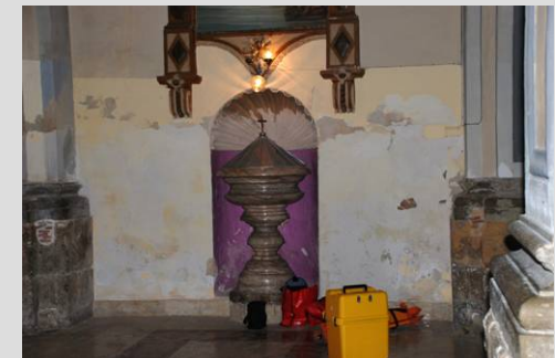
Fig. 61 Desconchado por capilaridad
