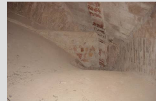
Fig.33 Lengüeta y relleno
