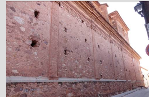
Fig. 33. Muro lateral: Moldura de zócalo de piedra y pilastras de ladrillo
