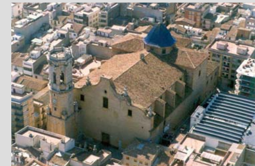
Fig.2 Vista aérea fachada principal ( http://www.cult.gva.es )
