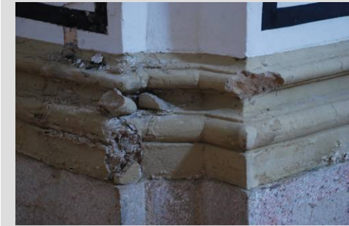
Fig. 43 Arenización molduras basas
