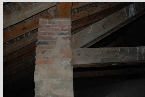
Fig. 41 Recreido de pilar: mampostería y ladrillo
