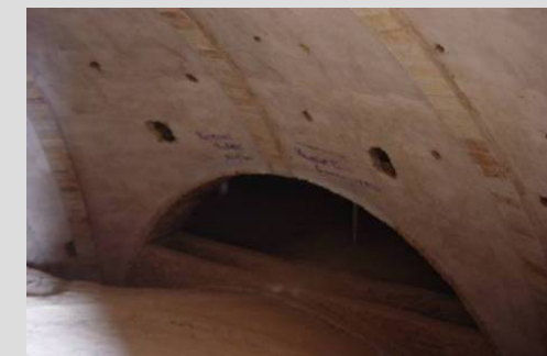
Fig. 34 Estribo sobre arco fornero
