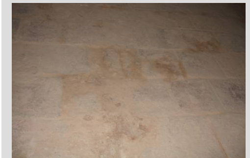
Fig.48 Arenización del solado
