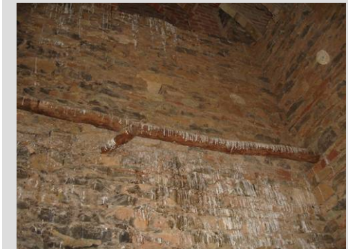
Fig. 21 Vista superior del almacén
