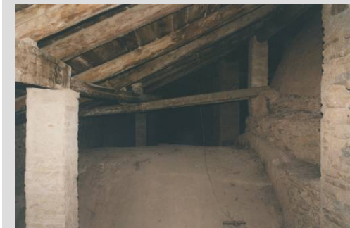
Fig.41 Cubierta: nave lateral (Martín 1998)
