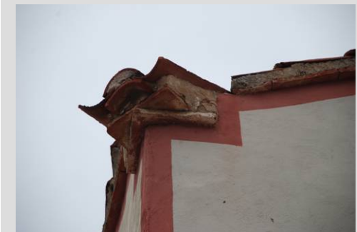
Fig. 39 Composición intersección vertientes
