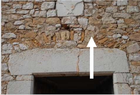
Fig. 53 Fisura dintel
