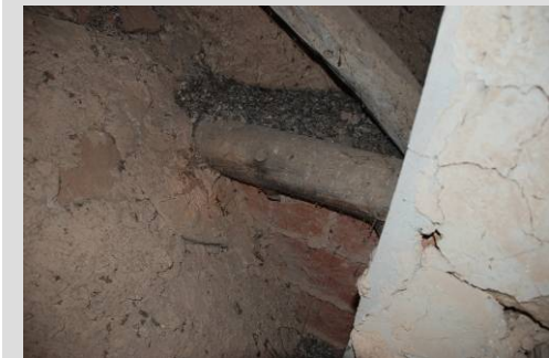
Fig. 41 Acodalamiento de la bóveda
