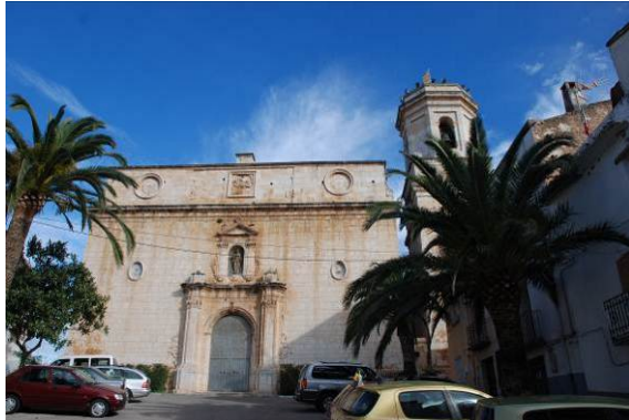
Fig. 49 Ventanas: jambas abocinadas, dintel recto
