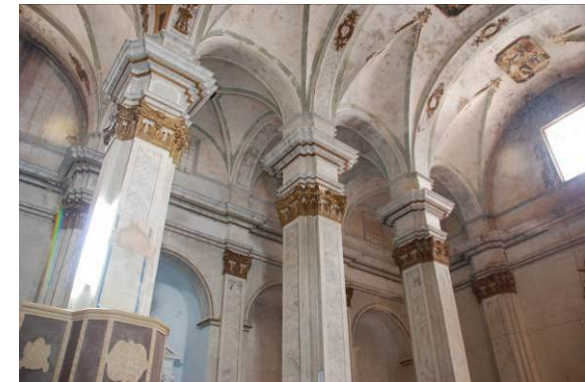
Fig. 126 Vista general: pilares
