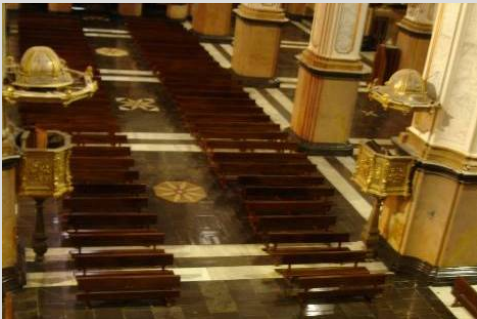
Fig.35 Solado de mármol (nave)
