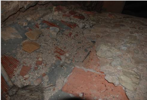
Fig. 37 Ladrillo macizo, piedras, mortero cal
