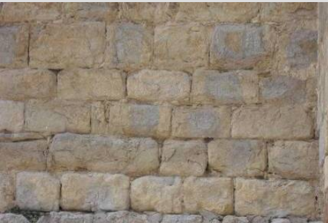
Fig.37 Meteorización de la fábrica de sillería
