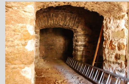
Fig.3 Acceso a las bóvedas que sustentan el convento
