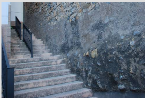
Fig. 42 Posible cimentación muro epístola
