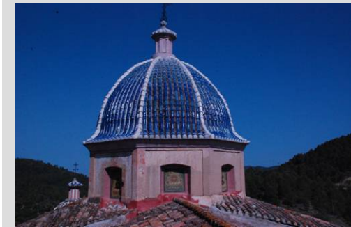
Fig. 16 Cúpula crucero (vista exterior)
