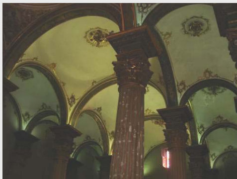
Fig. 30 Bóvedas naves (Callosa)
