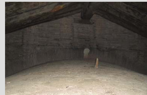
Fig.23 Muro de ladrillos formando el tambor
