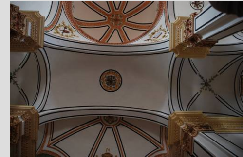
Fig. 14 Bóveda vaída nave principal
