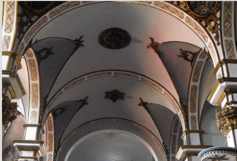
Fig.6 Bóvedas de arista (nave lateral)
