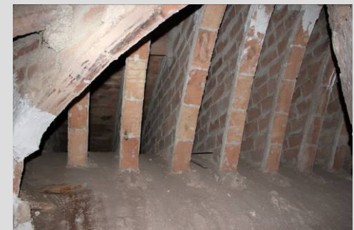
Fig. 34. Bajo cubierta (sobre sacristía)
