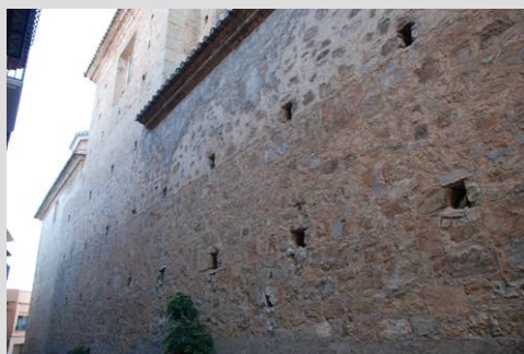
Fig. 43 Muro de mampostería y de mampostería y tapial
