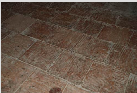
Fig. 24 Solado: baldosa cerámica artesanal (Culla)
