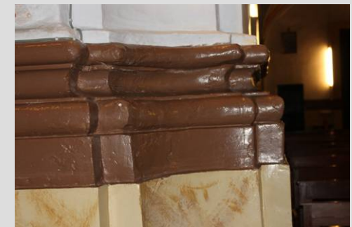
Fig.13 Pilar toral con esquina cóncava
