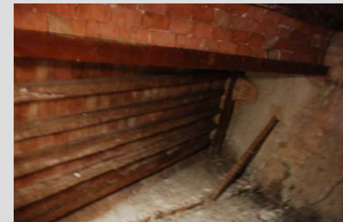
Fig. 17 Cubierta modificada (Sala sobre la sacristía)
