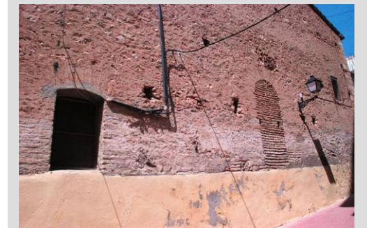
Fig. 19 Fachada posterior: ventana sacristía
