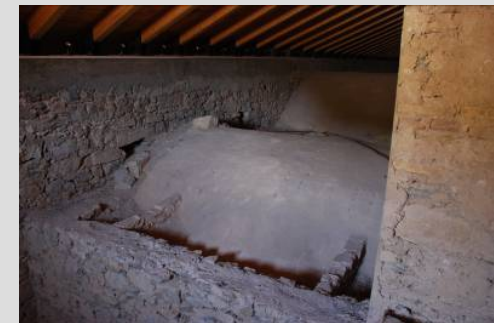
Fig.30 Lengüetas en las bóvedas de cañón
