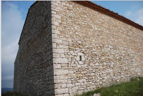
Fig. 51 Muros de mampostería ordinaria con encadenado en las esquinas (Culla)
