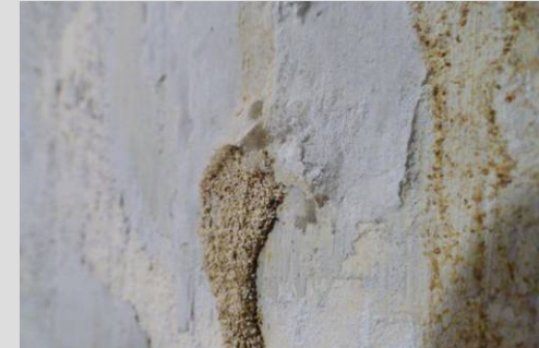
Fig.48 Túnel termitas
