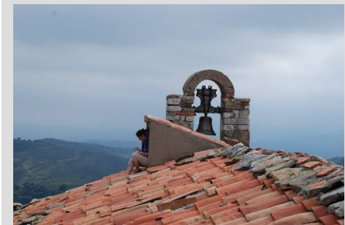
Fig. 42 Cubierta y buarda
