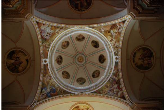
Fig. 22 Tabiquillos tramo pies
