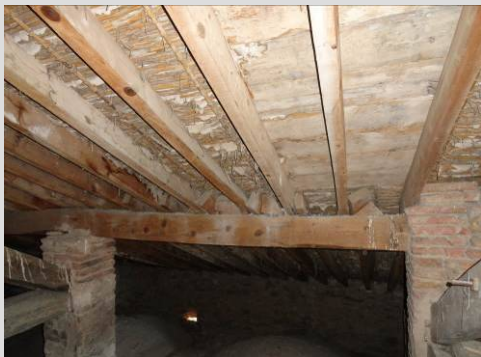
Fig. 12 Entablado (Vilar de Canes)
