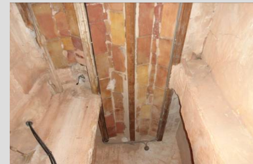
Fig. 39. Forjado de viguetas y revoltones (campanario)
