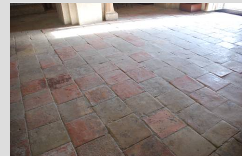
Fig. 28 Solado de barro cocido
