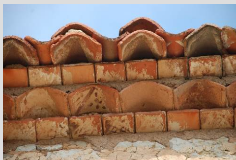
Fig. 69 Alero de hiladas de ladrillos y tejas (Culla)
