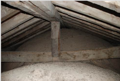
Fig. 10 Cubierta parhilera con pendolón y tirante (Culla)
