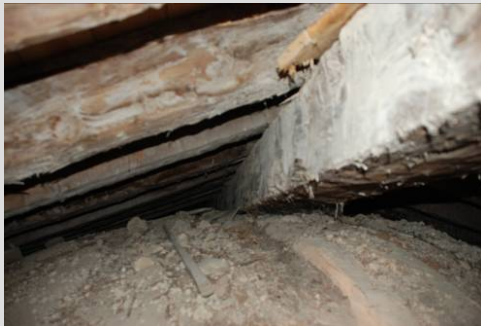
Fig. 29 Apoyo de cubierta sobre bóveda
