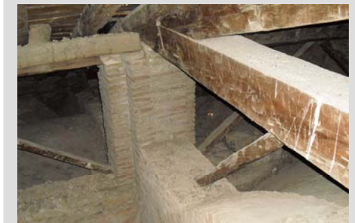
Fig. 28 Unión en el recrecido de pilar
