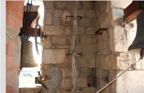
Fig. 42 Muro campanario: piedra y bloques de hormigón
