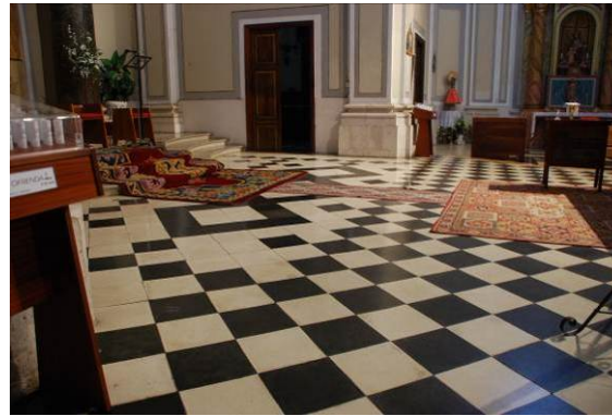
Fig. 56 Baldosas hidráulicas: naves
