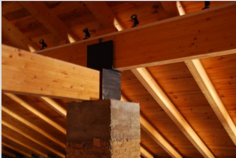
Fig.32 Unión en el recrecido de pilar (XX)
