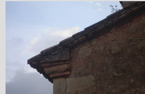
Fig. 27 Vertiente de la cubierta
