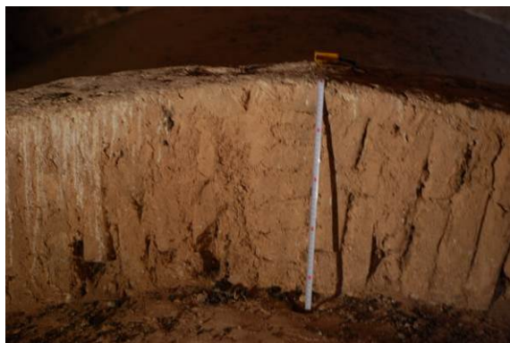
Fig. 76 Toma medida extradós bóvedas
