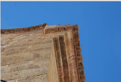
Fig.33 Alero: ladrillo y pétreos aplantillados
