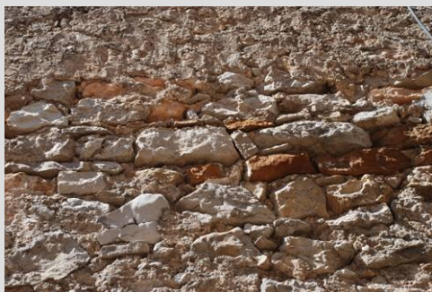
Fig. 39 Mampuestos margosos y calizos
