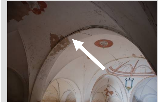
Fig. 50 Fisura longitudinal
