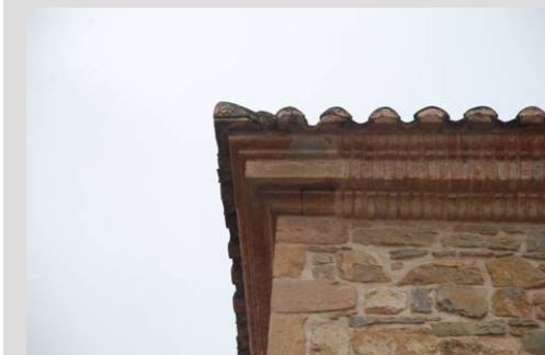
Fig. 29 Alero de ladrillos y sillares apantillados
