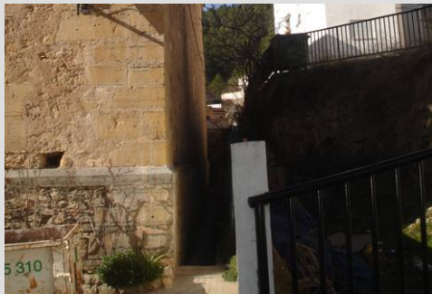
Fig.26 Encadenado de las esquinas y desmonte del terreno
