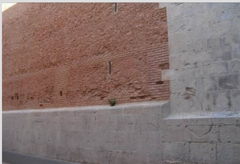
Fig. 53 Muros de mampostería verdugada (Vila-real)
