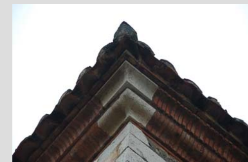
Fig. 38 Alero: ladrillos aplanillados y sillares
