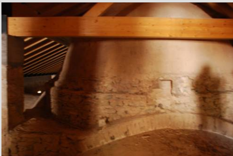
Fig. 63 Recrecido de la base (Montán)
