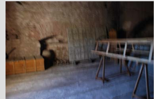
Fig. 16 Arco tapiado (Sala sobre la sacristía)
