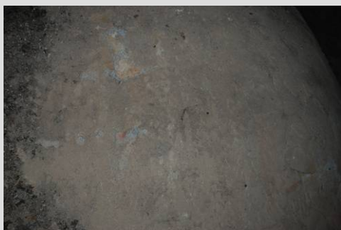
Fig. 45 Bóveda original (Presbiterio)
