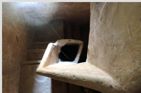
Fig.19 Escalera de perimetral (torre)
