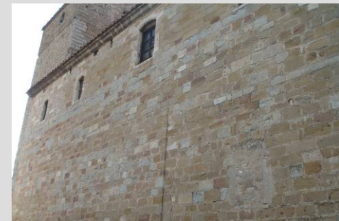
Fig.22 Muros de calizas y margas
