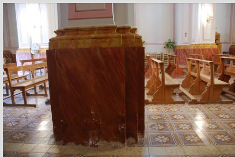
Fig. 35 Estuco y baldosas hidráulicas
