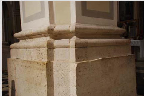
Fig. 28 Pilar del crucero: achaflanado de la esquina
