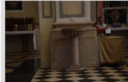
Fig. 25 Recrecido exterior muro (Primer tramo)
