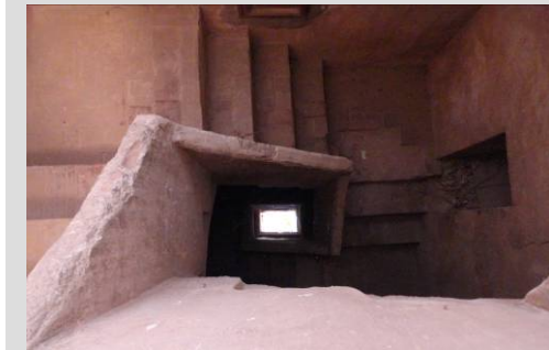
Fig. 20. Escalera castellana (torre)
