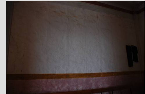
Fig. 46 Revoco maestreado
