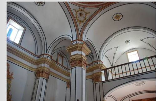
Fig. 13 Bóvedas vaídas y de cañón con lunetos
