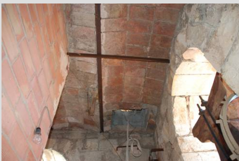
Fig. 53 Forjado campanario: viguetas metálicas, y revoltón de ladrillos
