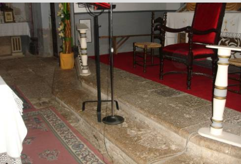
Fig.38 Desgaste escalones del presbiterio
