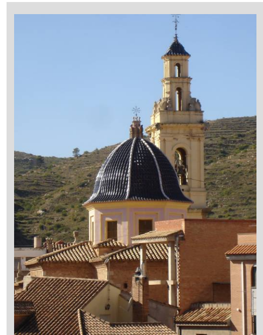
Fig. 15 Cúpula y torre
