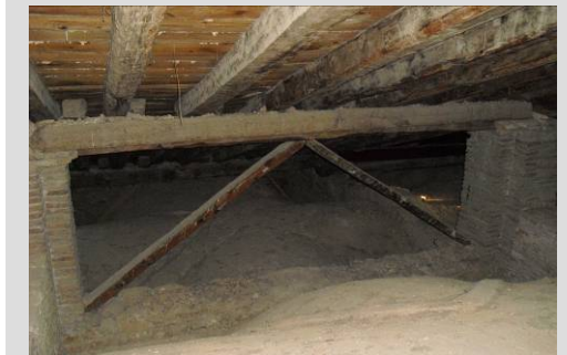
Fig. 27 Viga carrera
