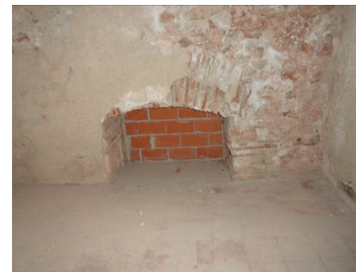
Fig. 96 Ventanas tapiadas, sobre sacristía
