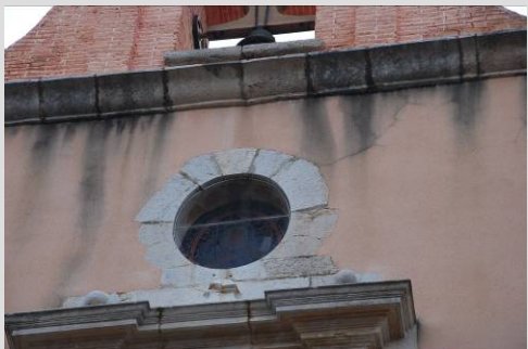
Fig. 43 Chorretones, afogado recubrimiento
