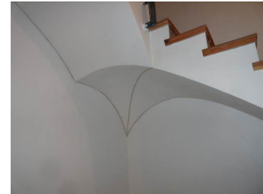
Fig. 99 Escalera coro nueva
