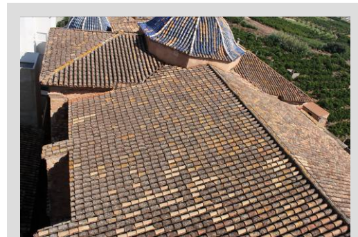
Fig. 38. Vista general cubiertas
