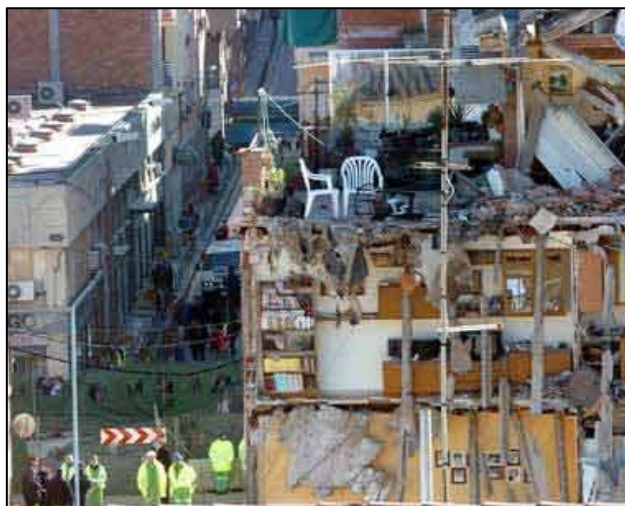
Figura 6.5.- Enderrocament del segon dels blocs al Carrer Conca de Trep, al gener del 2005. Font: www.tv3.cat
