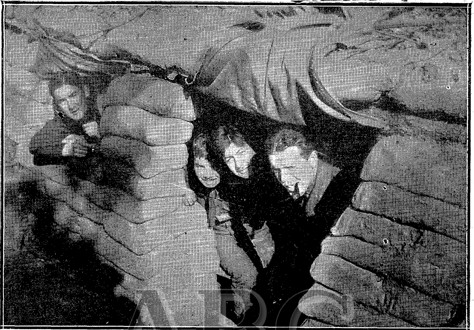
LOS ALIADOS EN LOS BALKANES TRINCHERA DE LOS INGLESES, HECHA CON SACOS DE ARENA, EN LA FRONTERA DE LA MACEDONIA GRIEGA. (FOTO TRAMPUS)
