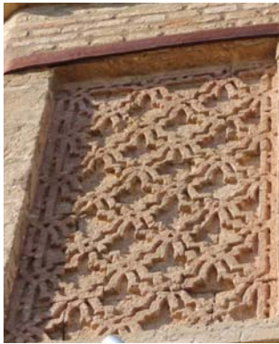
Torre del Oro, Sevilla, 1220-1221
