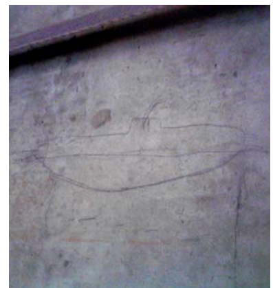
Interior del dipòsit de retenció d'aigües l'Estrella de Badalona, Barcelona, 2013
