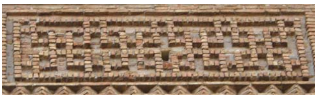
San Félix de Torralba de Ribota, torre, Zaragoza, s. XIV
