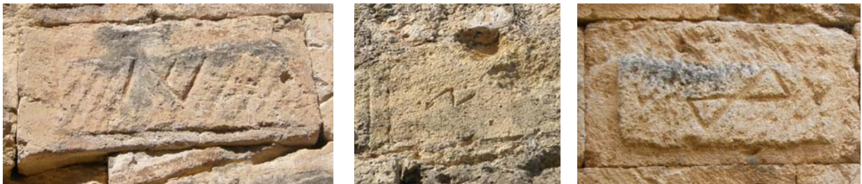
Diferents marques de picapedrer de la muralla de Tarragona, 150-125 a.C.
