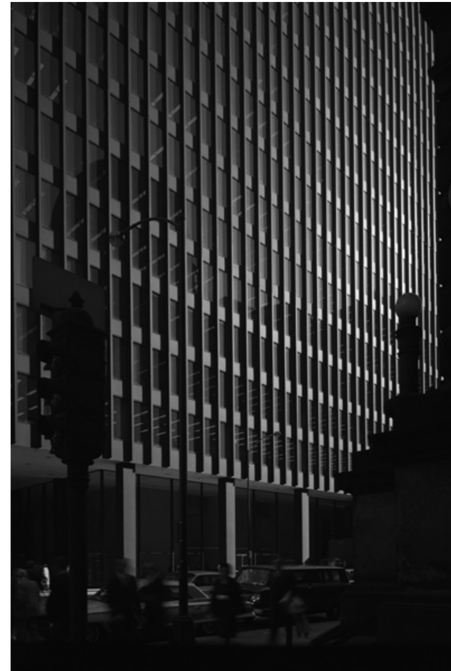
300. Fachada de la torre de juzgados del Federal Center en Chicago. Fuente: CHS - Disponible en: http://goo.gl/F3imS8
