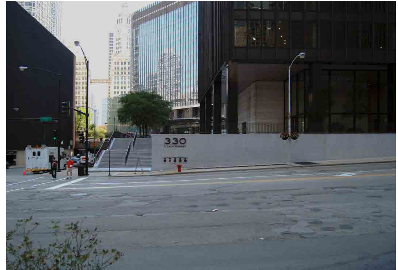
338. Vista del podio que salva la diferencia de nivel y sobre el que se asienta el edificio IBM. Fuente: Autor.
