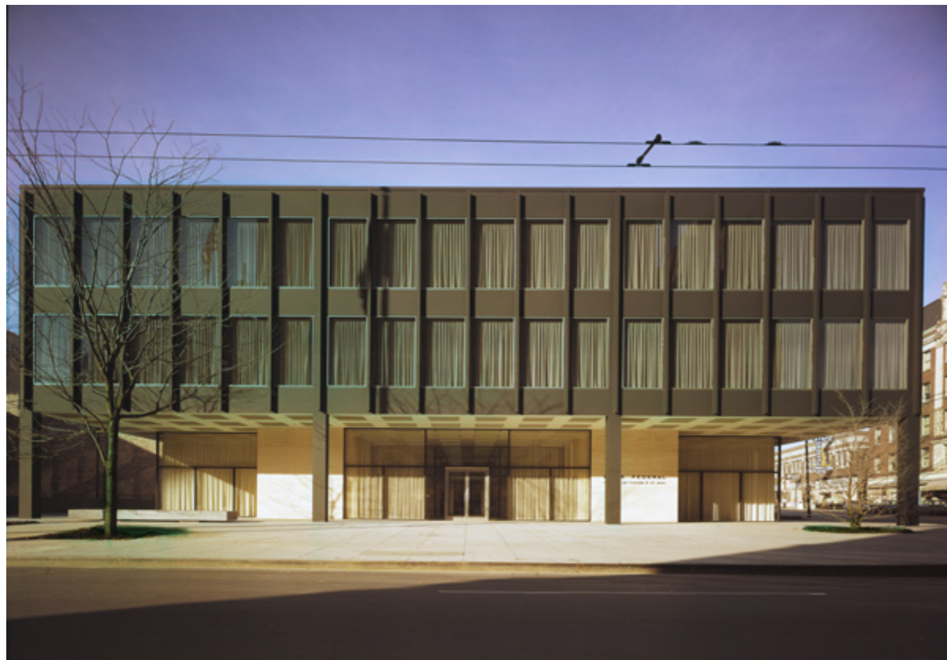
316. Vista frontal de la fachada de acceso. Fuente: CHS - Disponible en: http://goo.gl/Qs9NRO
