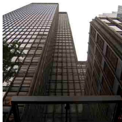
284. Vista de los paños opacos de la "espinal dorsal" de la fachada este del edificio Seagram en Nueva York. Fuente: Autor.
