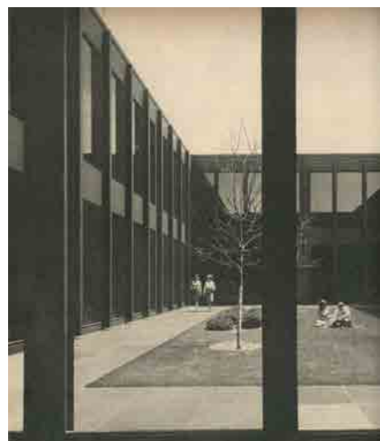
162. Patio interior. Fuente: Architectural Record (octubre 1965): 144.
