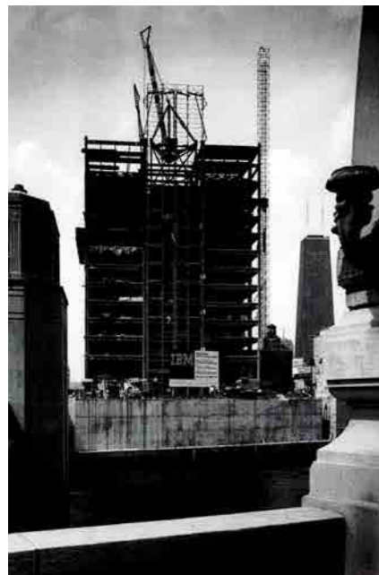
101. Edificio IBM en construcción y la torre John Hancock al fondo.
