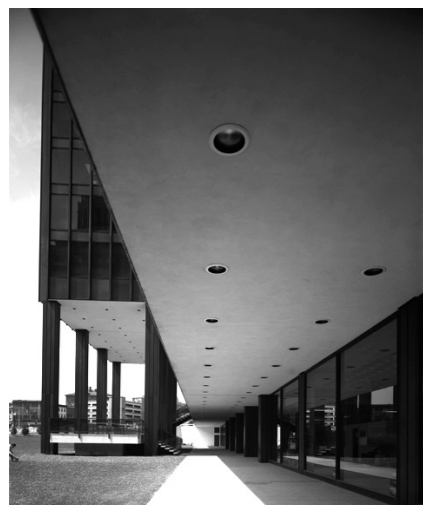
44. Fachada del espacio comercial colindante con el parque. Fuente: CHS - Disponible en: http://goo.gl/k7e0rk
