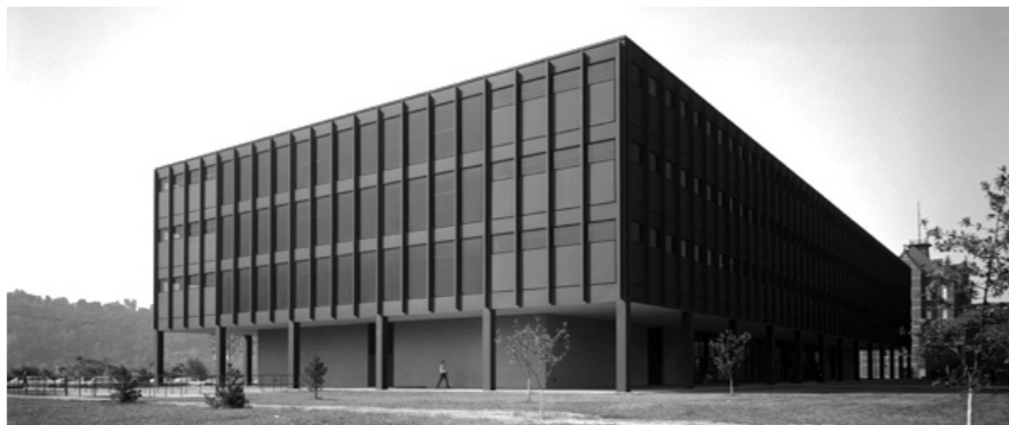
178. Escorzo de las fachadas norte y este. Fuente: CHS - Disponible en: http://goo.gl/bFPuCS
