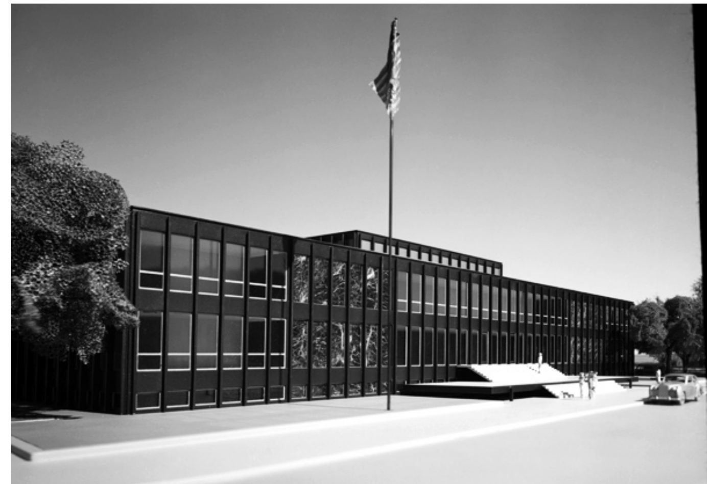
118. Escorzo de la fachada de acceso principal. Fuente: CHS - Disponible en: http://goo.gl/rvOZNw
