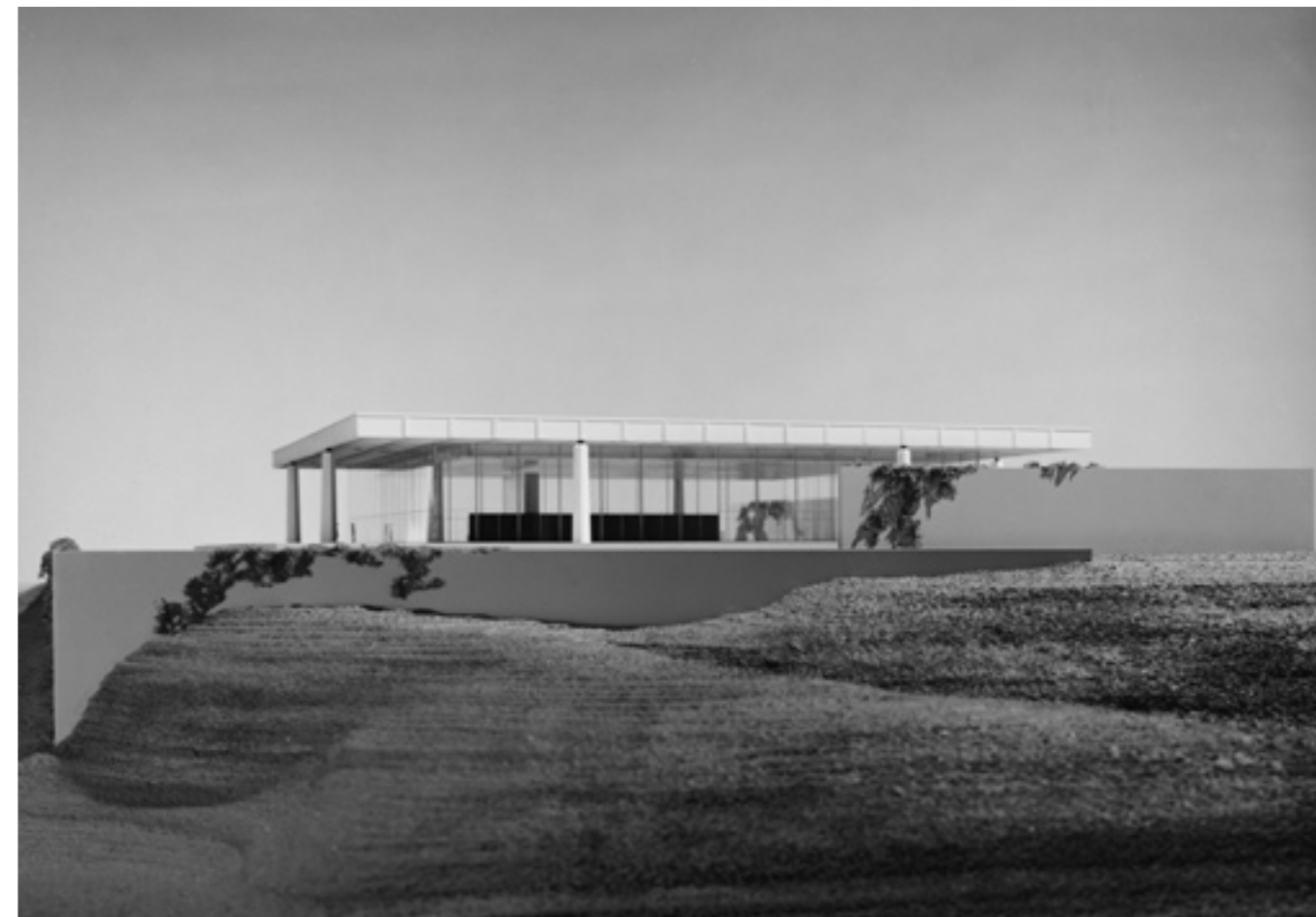
240. Muros de contención absorbiendo la diferencia de niveles del terreno.
