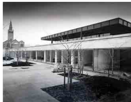
269. Patio de esculturas durante la construcción del edificio. Fuente: MoMA. Mies van der Rohe Archive. Archivo fotográfico.
