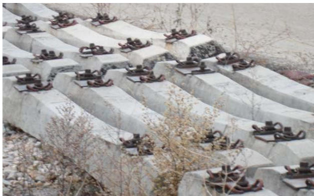
Acopio de material retirado
