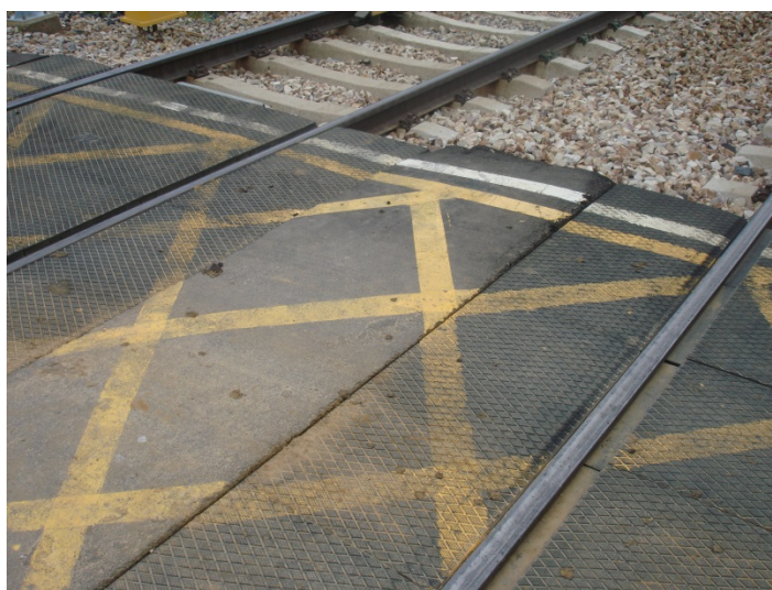
Figura 6.23.- Superficie polimérica de vía en un paso a nivel
