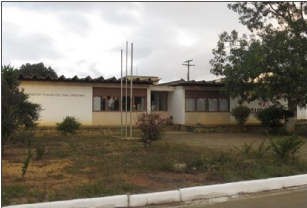
Figura 7.4: Sede administrativa do Distrito Industrial dos Imborés (observa-se a falta de conservação do imóvel).
