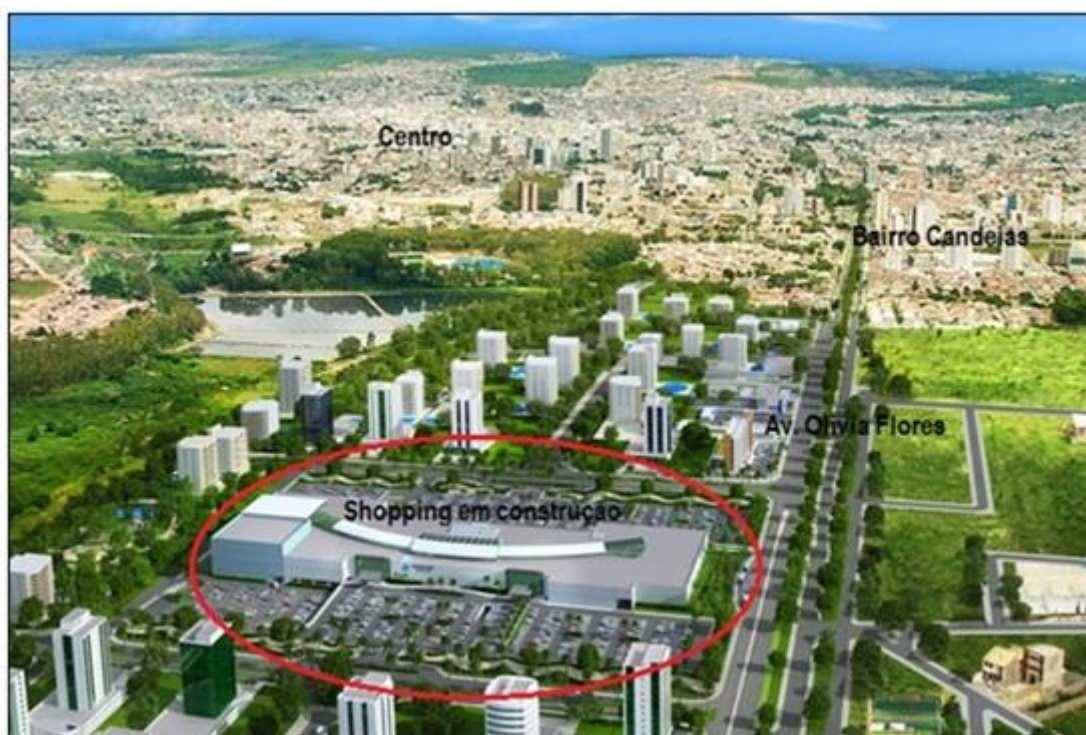
Figura 7.3: Projeto do novo shopping, localizado no bairro Candejas, 2014. (Em fase de construção)
