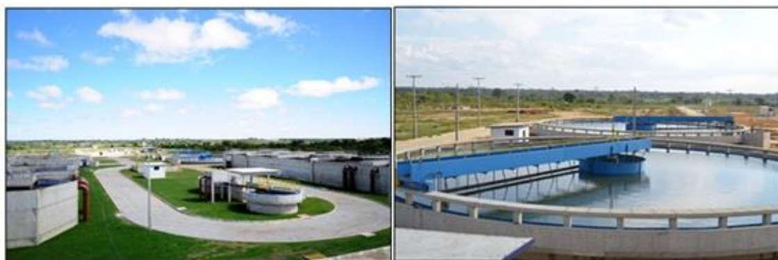
Figura 6.5: Nova estação de tratamento de efluentes (ETE) de Vitória da Conquista.
