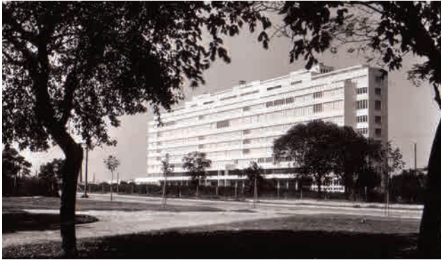
Hospital Churrucá, Buenos Aires, 1935. Autor: arquitecto Carlos Vilar (1891-1986).
