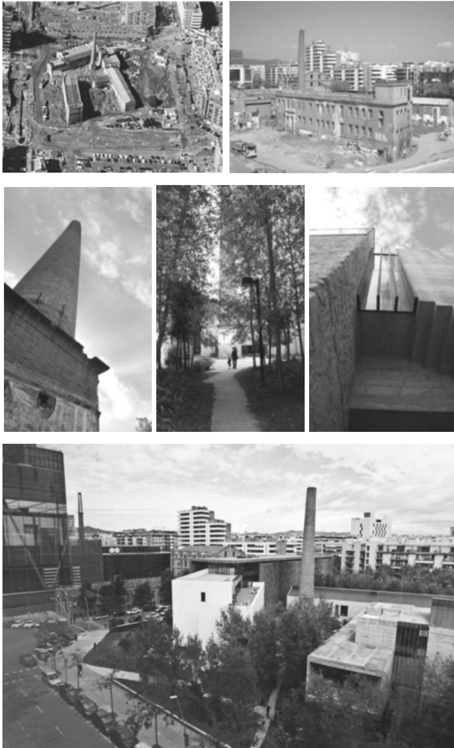
Fig. 5.57 e 5.58. Fotografia aérea e perspectiva desde C/ Roc Boronat antes das obras. Fig. 5.59., 5.60, 5.61. Elementos patrimoniais pré-existentes: chaminé; intervenção sobre as fachadas do antigo edifício fabril. Fig. 5.62. Edifício de Can Framis desde o edifício Media TIC.
