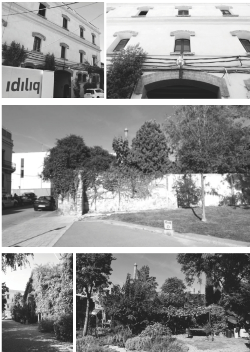
Fig.5.118. e 5.119. Um dos edificios patrimoniais característicos de Palo Alto. Fig.5.120. Vista desde os jardins Remedios Varo para o muro de Palo Alto. Destaca-se a presença da chaminé deste complexo. Fig.5.121. Edifício característico do recinto de Palo Alto, coberto de vegetação. Fig.5.122. Parte do espaço público ajardinado do recinto. Note-se a chaminé de Palo Alto e a Torre de les Aigues, da antiga Can Girona.
