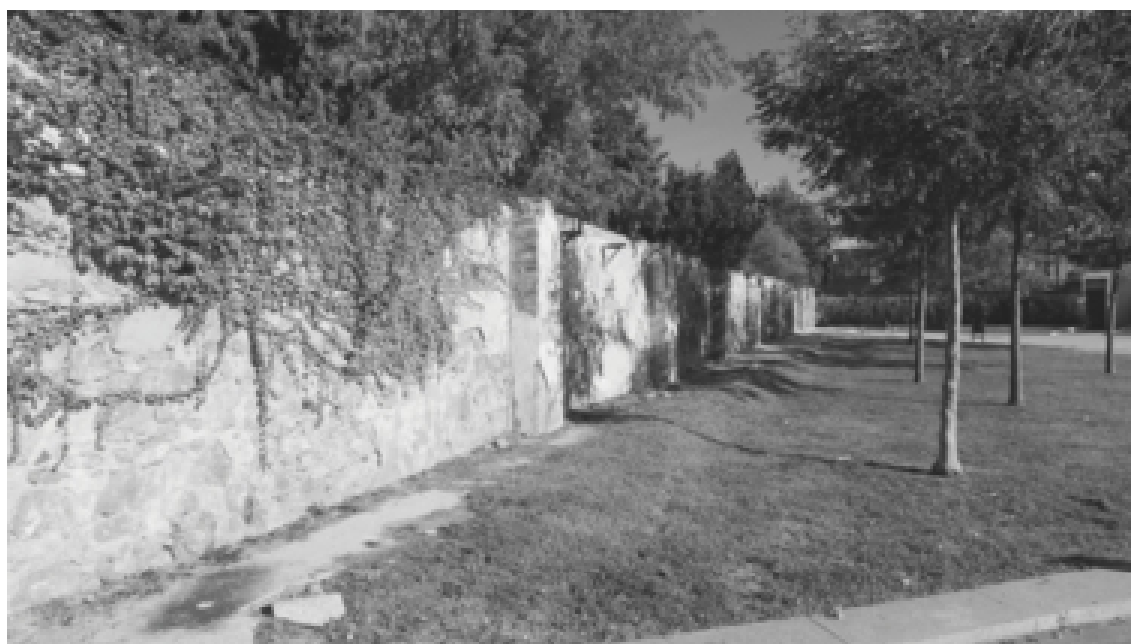
Fig.5.166. Perfis reguladores do PMU de 2010. Destaca-se a altura da chaminé do recinto relativamente aos demais elementos. Fig.5.167. Muro exterior após ser intervencionado, em 2012.
