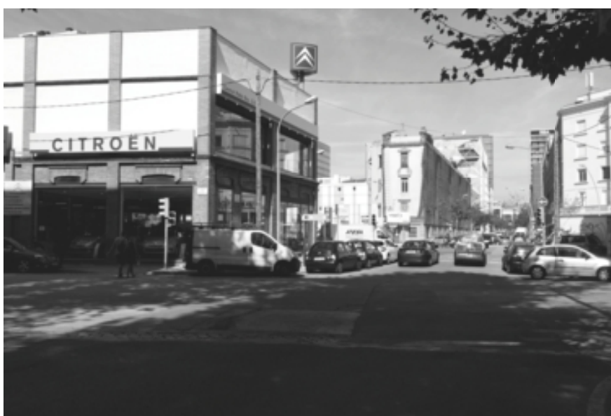
Fig.4.39., Fig.4.40. e Fig.4.41. A paisagem ainda em construção do 22@ em 2012, onde se acumulam diversas épocas: quarteirão de Can Ricart com vista para Pere IV; edificado novo e chaminé antiga, no Camí Antic de València; Sancho d'Àvila.
