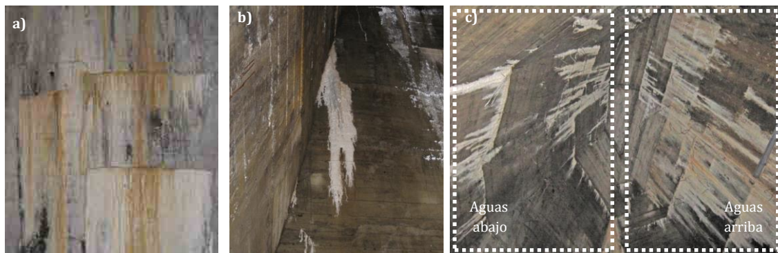
Figura 4.15.- Productos de reacciones: a) óxidos de hierro (ocres); b) y c) carbonato cálcico
