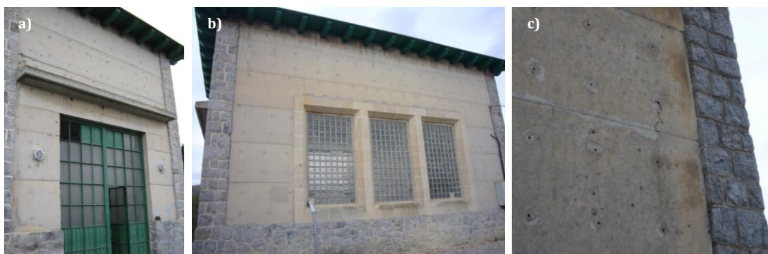
Figura 4.9.- Estructura auxiliar sin signos de daño relevantes
