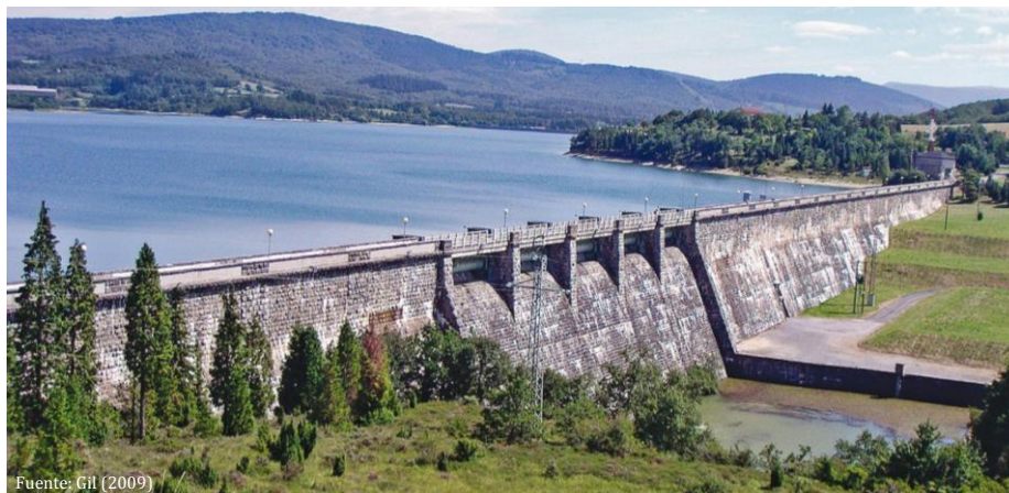
Figura 4.1.- Vista general de la presa (Gil, 2009)
