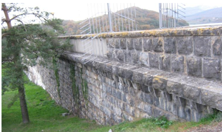
Figura 4.7.- Estribo de la presa
