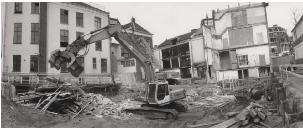
FIG.183: Demolición de los edificios para la creación de la plaza de entrada.
