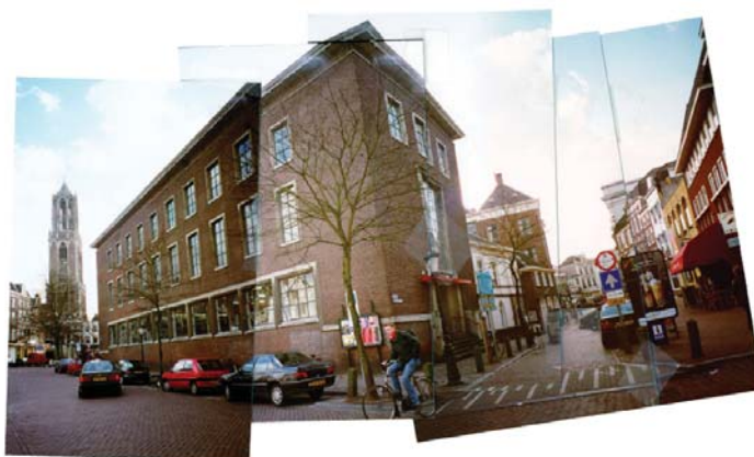
FIG.189: Edificio de Registro existente y previo a la intervención.
