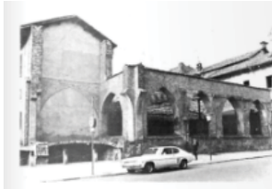
FIG.147: Estado previo a la intervención
