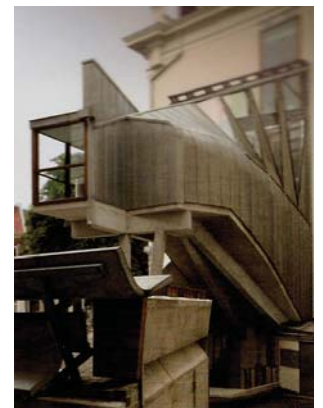
FIGS.192: Imágenes del perfil a tracción del cuerpo emergente, en su contacto con el muro de fachada.
