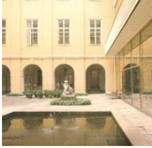
FIG.58: vista desde el patio del encuentro entre la nueva cristalera y voladizo con la fachada preexistente.
