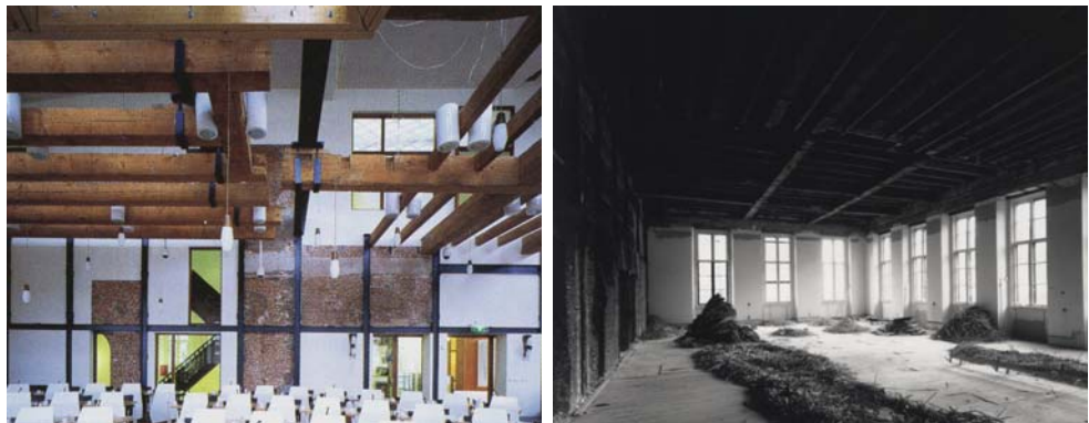
FIG.199: Sala de Plenos antes y tras la intervención.
