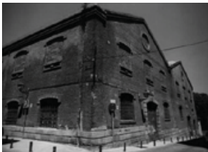
FIG.85: antigua central eléctrica.
