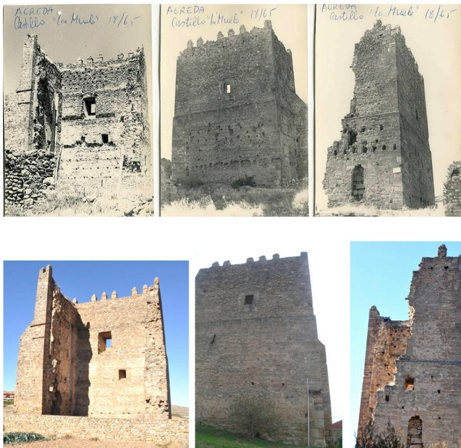
Figura 169. Las tres imágenes superiores muestran el estado de conservación del torreón en el año 1965, las tres de la parte inferior, son del momento anterior a la rehabilitación. Fuente: Archivo del Ayuntamiento de Ágreda.
