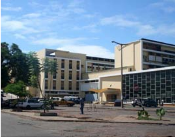
Ilustración 3: Vista de la entrada principal del Hospital Central de Maputo
