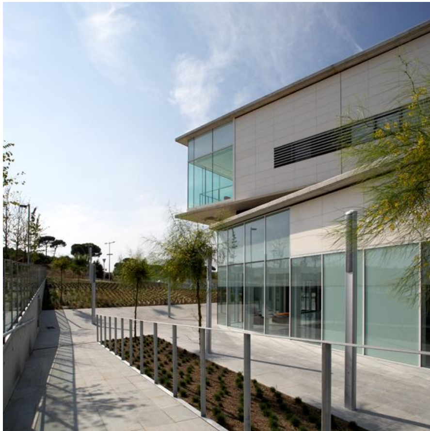
Figura 2.133 – Hospital de Mollet - Vista Exterior – Fachada sur (www.mariocorea.com)
