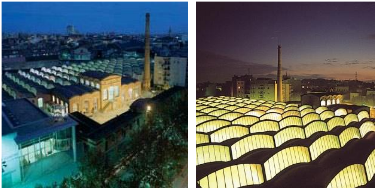
Figura 1.30 - Shed - cubierta en diente de sierra – MNACTEC ( www.interempresas.net )
