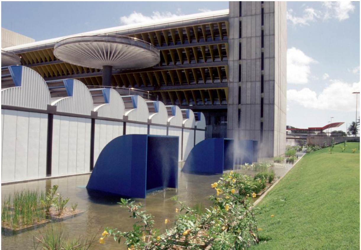
Figura 2.84 – H. Sarah Fortaleza - Fachada sureste - Vista exterior de los sheds y captadores de aire (archivo del CTRS)
