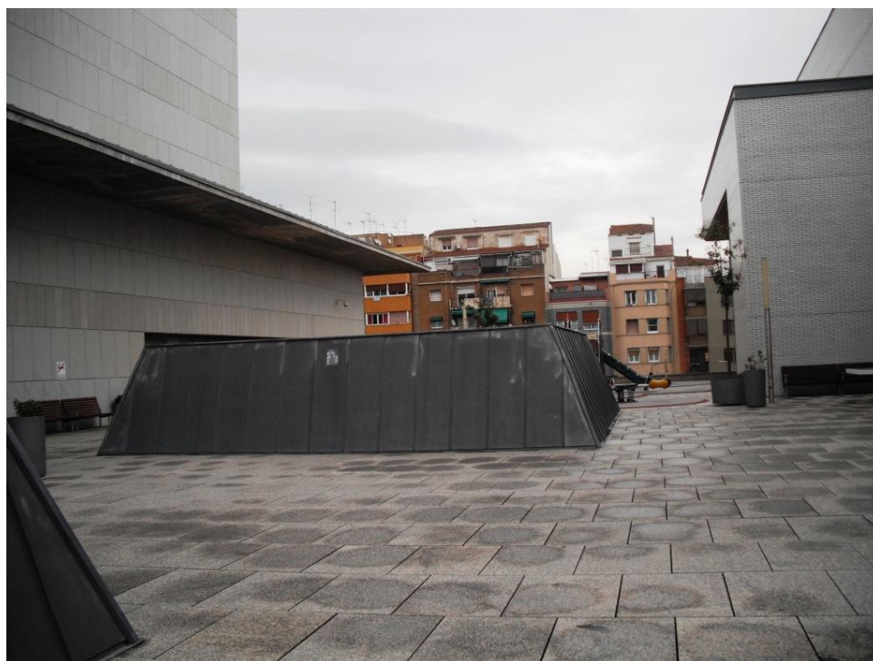
Figura 2.121 – H. de la Santa Creu i Sant Pau - Planta 2 – Terraza descubierta con patios de luz (archivo de la autora)
