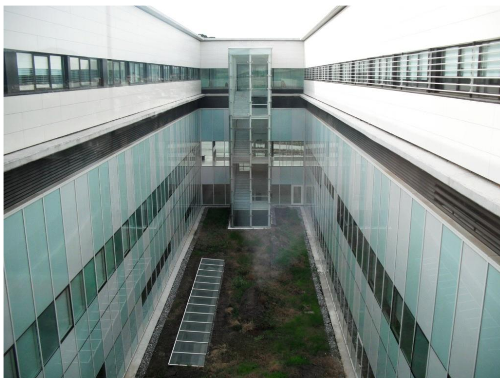
Figura 2.139 – Hospital de Mollet - Planta 1ª - Vista de patio ajardinado, ventanas de habitaciones, con protecciones externas (fachada sur) y sin protecciones (fachada norte) y vista de ventanas y lucernarios que iluminan el sótano (archivo de la autora)
