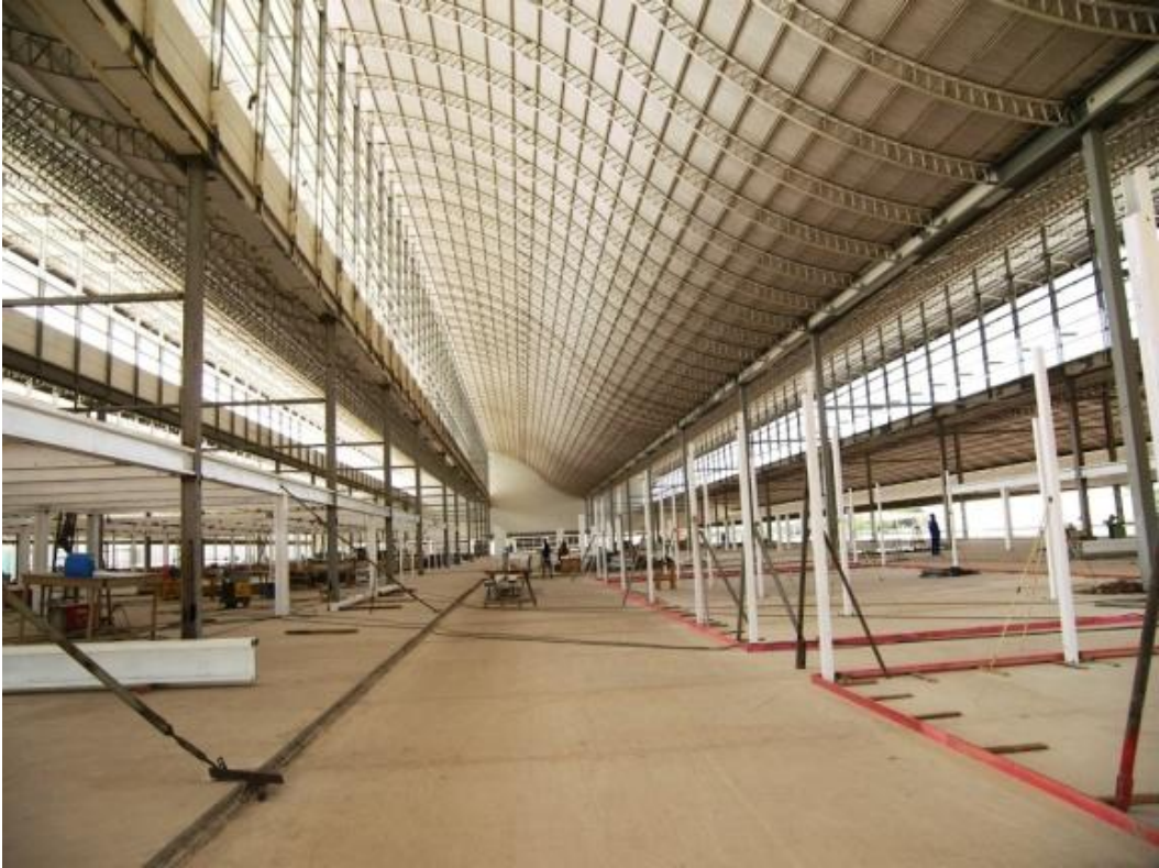
Figura 2.103 – H. Sarah Rio de Janeiro - Vista interior del suelo técnico – fase de obra (archivo del CTRS)
