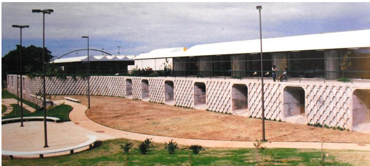
Figura 2.67 – H. Sarah Salvador - Fachada noreste. Vista exterior de galería. (LATORRACA, 1999, p.192)
