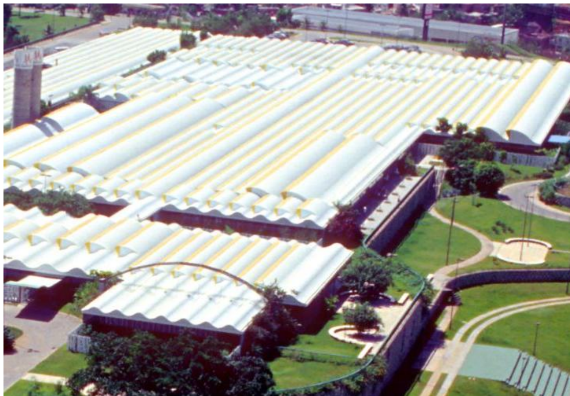
Figura 2.58 – H. Sarah Salvador - Vista aérea - Fachada noreste y sureste (archivo del CTRS)
