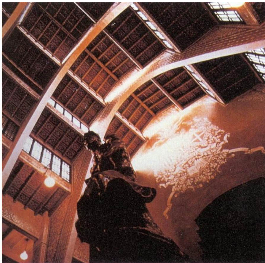
Figura 1.12 - Cubierta monitor (BAKER, 1993, p.5.15)
