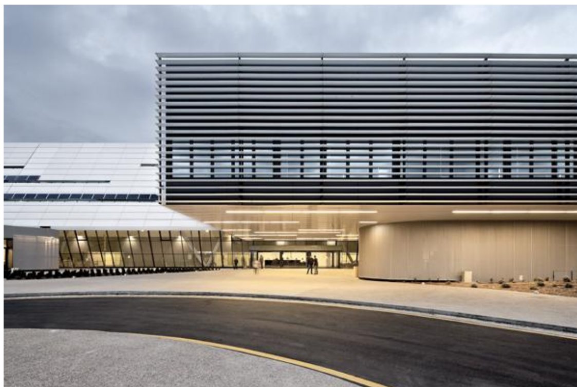
Figura 2.149 – H. Universitari Sant Joan de Reus - Fachada sur – Acceso principal y edificio administrativo/docencia ( www.mariocorea.com )
