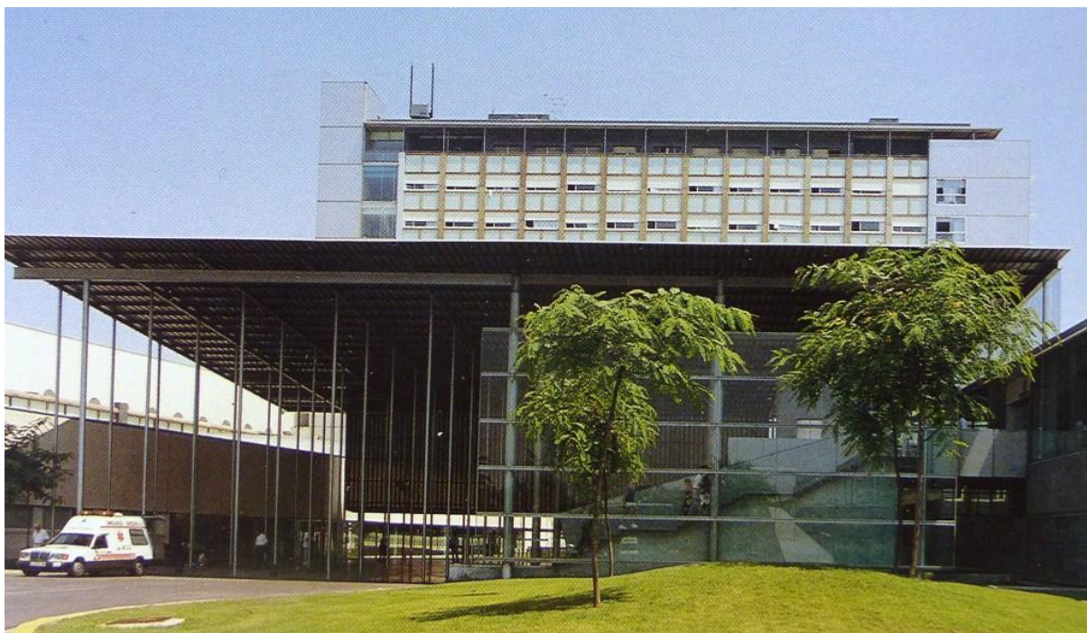
Figura 2.17 - Hospital del Mar (COMAS I COMA; MIRALLES, 1994, p. 85)
