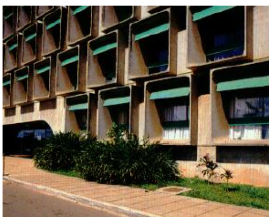
Figura 2.42 - Hospital Taguatinga – fachada frontal con las ventanas protegidas por brises (LATORRACA, 1999, pg.48)
