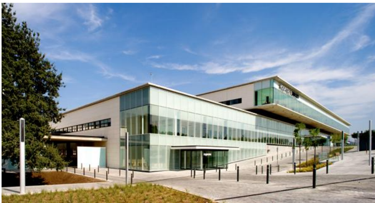
Figura 2.131 – Hospital de Mollet - Vista Exterior – Fachada norte y fachada oeste (www.mariocorea.com)
