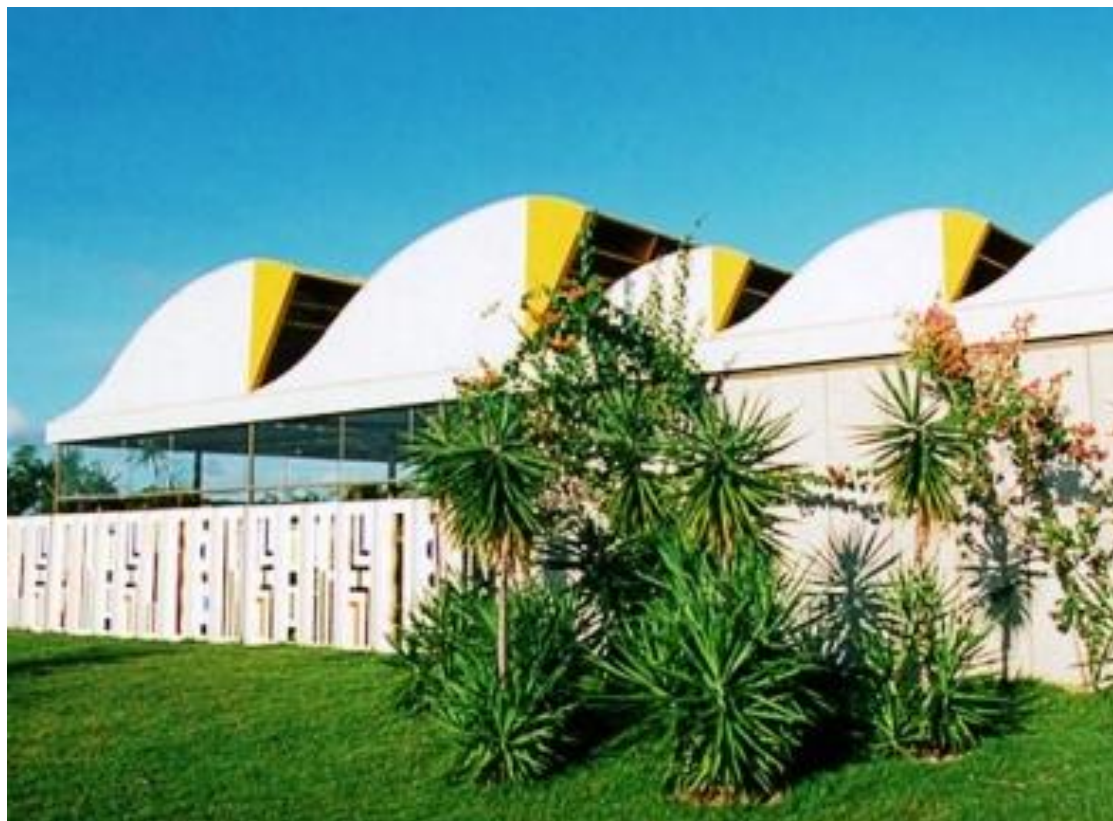
Figura 2.66 – H. Sarah Salvador - Cubierta en shed (archivo del CTRS)
