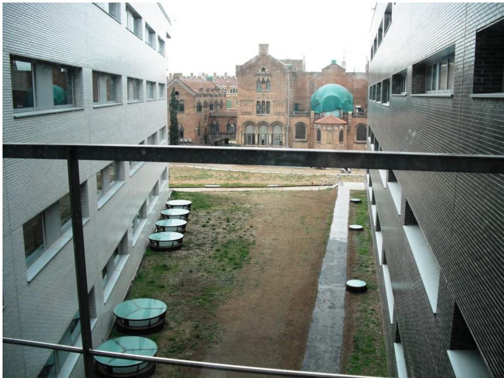
Figura 2.119 – H. de la Santa Creu i Sant Pau - Jardín entre bloques de hospitalización. Vista de lucernarios que iluminan sótano (archivo de la autora)
