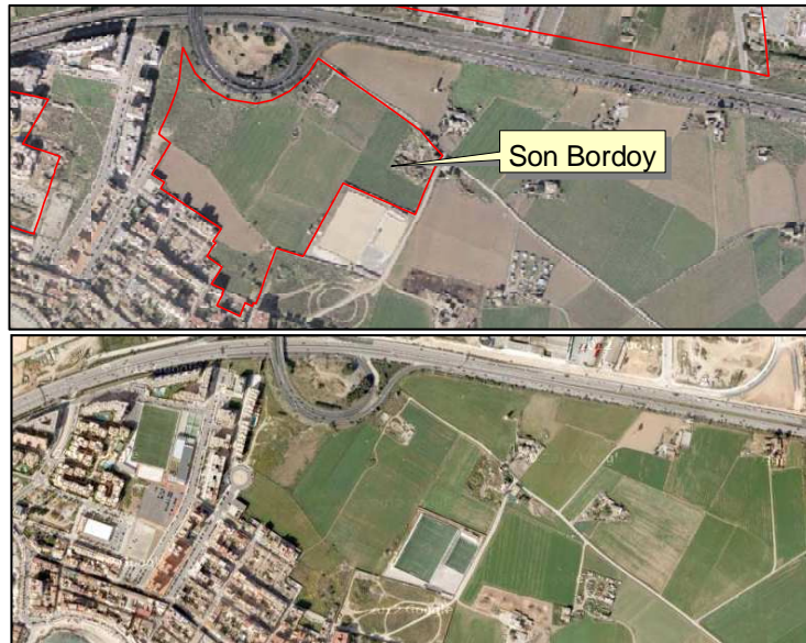
Figura 130, 131 i 132: transformació de Son Bordoy (111.821m 2 ), 2006, 2012 i projecte d'urbanització
