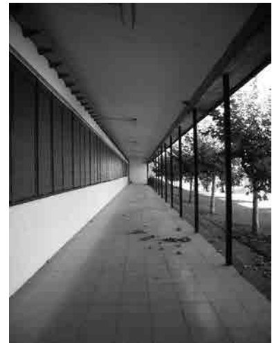
Fig. 36 Galería exterior abierta. En la imagen se observa el uso de esbeltos soportes de acero. Fotografía actual.
