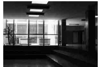
Fig. 25 y Fig. 26 Aulario de Ciencias. Patio con estanque (arriba, fotografía actual) y graderío junto al vestíbulo de acceso, iluminado por pequeños tragaluces cuadrados (abajo, fotografía de época).
