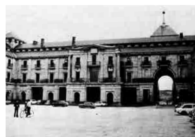
Fig. 38, Fig. 39 y Fig. 40 Vista de la torre alineada con el atrio corintio (arriba, fotografía actual), vista de la entrada en escorzo a la plaza central (centro, fotografía actual) y fachada frente a la capilla (abajo, fotografía de época).
