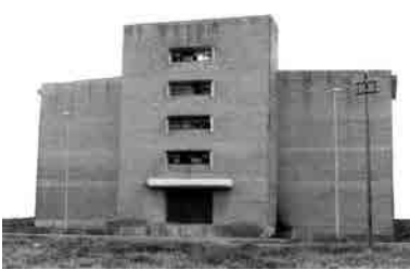
Fig. 9, Fig. 10, Fig. 11 y Fig. 12 Pabellones de usos complementarios. De arriba a abajo: almacenes, central eléctrica, establos y silo de grano. Fotografías actuales.
