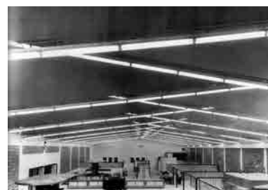
Fig. 38 y Fig. 39 Cocinas. Encofrado de la lámina de hormigón de la cubierta (arriba) y vista de la lámina desde el interior de la cocina (abajo). Fotografías de época.
