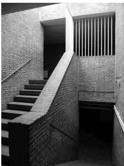
Fig. 13 Utilización de ladrillo cara vista y baldosas de Clinker en las escaleras de la zona docente (izquierda, fotografía actual). Fig. 14 Vista de la fachada principal de las viviendas para profesores (derecha, fotografía actual).
