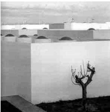
Fig. 49, Fig. 50 y Fig. 51 Vistas de los juegos de volúmenes encajados. Residencias (arriba), plaza principal (centro) y zona docente (abajo). Fotografías de época.
