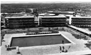
Fig. 127 Vista de una de las piscinas desde el mirador común de las residencias. Fotografía de época.
