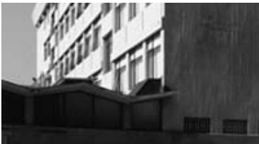
Fig. 47 y Fig. 48 Lucernarios en ala de gaviota del comedor. Vista parcial exterior del pabellón (arriba, fotografía de época) y vista del interior (centro, fotografía actual). Fig. 49 Este mismo tipo de lucernario sería empleado por los arquitectos en su Escuela de Náutica de Vigo, 1961 (abajo, fotografía actual), relacionándose formalmente, de otro lado, con los proyectados por José Luis Sert, Antonio Ochoa y Enrique Juncosa para el Estudio del pintor Joan Miró en Palma de Mallorca, 1957.
