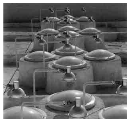
Fig. 39, Fig. 40 y Fig. 41 Agrupación de cuatro lucernarios. Detalle constructivo (izquierda) y vista de los situados en la cubierta del vestíbulo desde el interior (centro) y desde el exterior (derecha). Fotografías de época.
