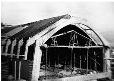
Fig. 37 y Fig. 38 Distintas fases de construcción de las bóvedas de cubierta. Fotografías de época.
