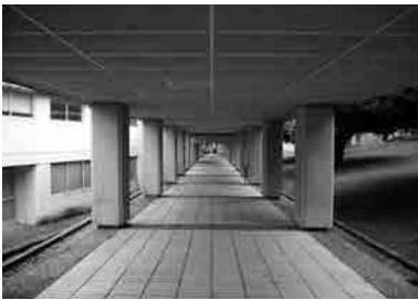
Fig. 72 y Fig. 73 Vista del porche de la planta baja del edificio de expansión de alumnos (arriba) y vista del paso cubierto que delimita el Norte de la plaza central (abajo). Fotografías actuales. En ambas imágenes se observa la utilización de falsos techos registrables que permiten canalizar las instalaciones a través de ellos.
