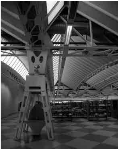
Fig. 48 y Fig. 49 Sección transversal del cuerpo de aulas de la Nave I de talleres (arriba) y soporte cuadrúpedo de las vigas-cajón (abajo, fotografía actual).
