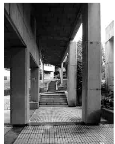
Fig. 70 y Fig. 71 Pasos elevados. Vista del interior (arriba) y vista desde abajo del arranque desde el edificio de usos comunes (abajo). Fotografías actuales. En la imagen inferior se observa la utilización de falsos techos registrables que permiten canalizar las instalaciones a través de ellos.
