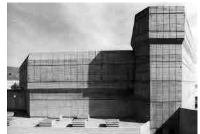
Fig. 10 y Fig. 11 Edificio de servicios. Vista parcial (arriba, fotografía actual) y planta (centro). Fig. 12 Vista de la fachada lateral del volumen del salón de actos (abajo, fotografía de época).
