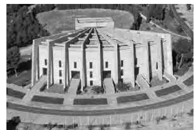
Fig. 42 Transformación sufrida por la fachada del paraninfo para cerrar su vestíbulo a la intemperie. Fotografía actual.
