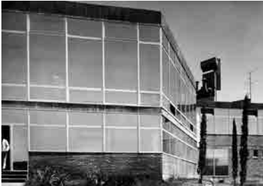
Fig. 10 y Fig. 11 Vista de la fachada de acceso al edificio de dirección (arriba, fotografía actual) y vista del acristalamiento de la fachada lateral del edificio de comedores-cocinas (abajo, fotografía de época). En la imagen superior se observa cómo la disolución de la estructura hexagonal mediante la creación de un porche permite la identificación del acceso en la fachada del edificio.
