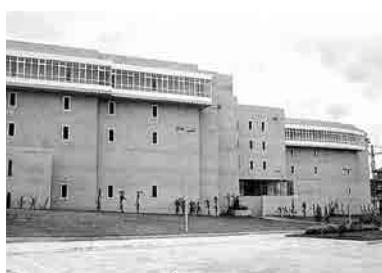
Fig. 10 Vista general de la fachada Norte de la zona de residencias. En la imagen se observa el dudokiano juego de monumentales volúmenes de hormigón, así como las galerías acristaladas que vuelan en la última planta.
