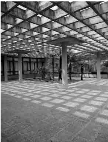
Fig. 45 y Fig. 46 Rectorado y cafetería. Vista parcial de la cafetería con la escalera sin contrahuella y los forjados volados de casetones huecos (arriba) y umbráculo en celosía entre ambos edificios (abajo). Fotografías actuales.
