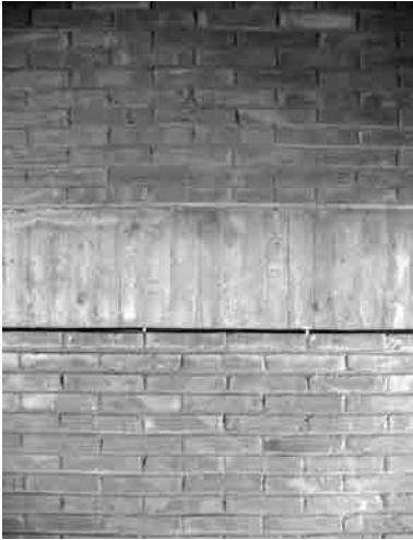
Fig. 87 Contraste entre la textura del hormigón visto, con el dibujado despiece de las tablillas de madera del encofrado, y la de las fábricas de ladrillo cara vista. En la imagen, el muro lateral de la escalera principal del edificio de dirección. Fotografía actual.
