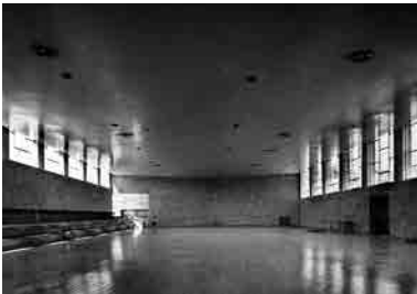
Fig. 57 Vista del interior del pabellón polideportivo. Fotografía de época.
