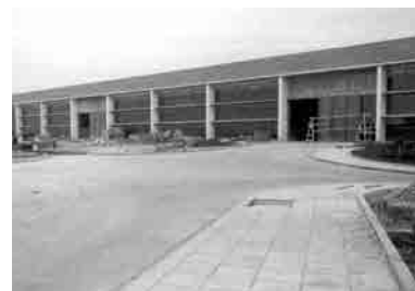
Fig. 64 y Fig. 65 Talleres. Vista general de la fachada Norte (arriba, fotografía actual) y vista general de la fachada Sur o de servicio (abajo, fotografía de época).
