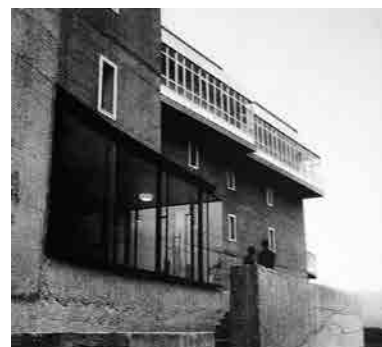
Fig. 46 Vista parcial de la fachada Norte de las residencias. En la imagen se observa la galería acristalada que vuela en la última planta, así como la caja de vidrio que alberga uno de los dos vestíbulos de acceso. Fotografía de época.
