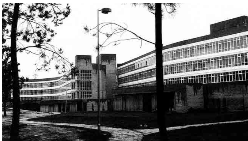
Fig. 74 Vista general de la fachada Sur de las residencias.
