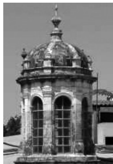
Fig. 23 y Fig. 24 Sala de exposiciones. Niños jugando en el porche junto a la fachada exterior de la sala (arriba) y lucernarios en la cubierta (centro). Fotografías de época. Fig. 25 Lucernario de la antigua Real Fábrica de Tabacos; Ignacio Sala, Diego Bordick Deverez y Sebastián Van der Bosch; Sevilla, 1728-1763 (abajo, fotografía actual).
