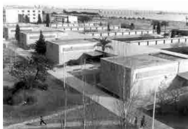
Fig. 40 Vista general del grupo escolar. Fotografía de época.
