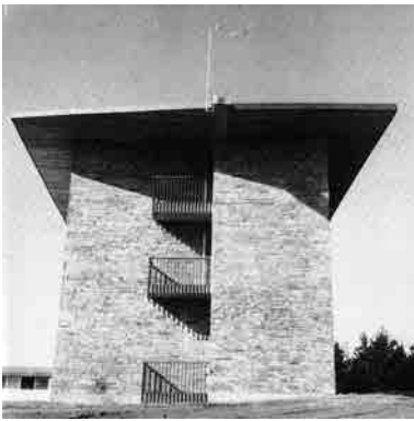
Fig. 46 Vista de la fachada lateral de uno de los edificios de residencia. Fotografía de época. En la imagen se observan los voladizos del forjado de hormigón de la cubierta, así como el canalón central de hormigón en forma de U y la mampostería de pizarra de la fachada.
