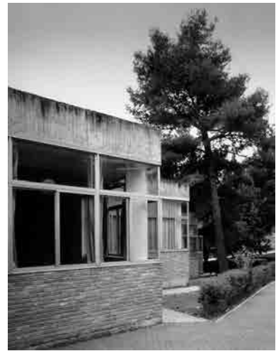
Fig. 73 Vista de detalle de una fachada en la que se observa cómo se combinan los paños de cerramiento de ladrillo visto de Velilla con los frentes de forjado de hormigón visto. Fotografía de época.
