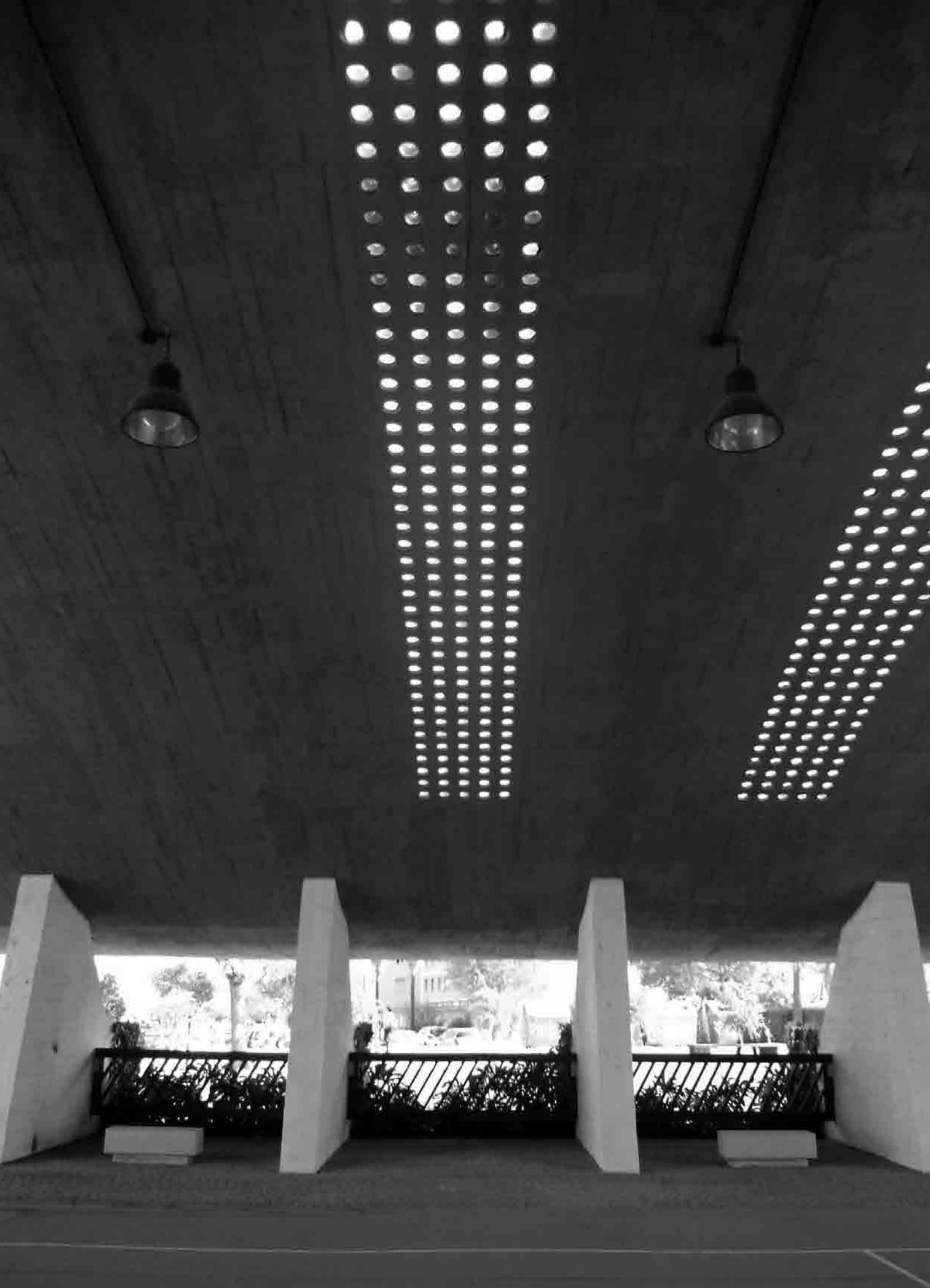
Fig. 1 Lámina de hormigón de la cubierta de los gimnasios. Fotografía actual.
