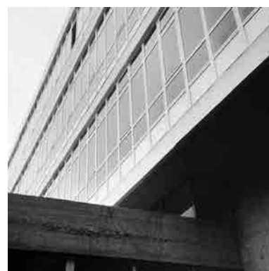
Fig. 72 y Fig. 73 Comparativa entre los marcos de hormigón prefabricados utilizados para encajar las carpinterías del polígono de viviendas sociales en Vite, Santiago de Compostela, 1959 (arriba) y las carpinterías de aluminio anodizado y esmaltado en blanco utilizadas en el Centro de Orense (abajo). Fotografías de época.
