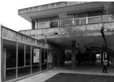
Fig. 7, Fig. 8 y Fig. 9 Zona docente. Vista del patio del edificio de dirección con los parasoles de la sala de conferencias (arriba, fotografía de época), vista del porche perimetral y del acceso al pabellón del club-biblioteca (centro, fotografía de época) y vista del encuentro entre el edificio de dirección y el pabellón de Formación Profesional (abajo, fotografía actual).
