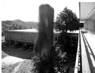
Fig. 73 Vista general de la fachada Norte del edificio del club-biblioteca desde la galería exterior del edificio de dirección. Fotografía actual.
