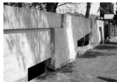
Fig. 24 y Fig. 25 Vista exterior del pabellón de la portería (arriba, fotografía de época) y vista de detalle del vallado de hormigón en la zona de acceso al conjunto (abajo, fotografía actual).
