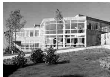
Fig. 8 y Fig. 9 Vista de la fachada trasera del aula principal (arriba) y vista de la fachada lateral del edificio de dirección (abajo). Fotografías de época. En la imagen inferior se observa cómo el edificio se construye sobre una ladera contenida por un muro de hormigón, de manera que su fachada delantera o de acceso tiene una planta, mientras que la trasera se abre con dos a las vistas.
