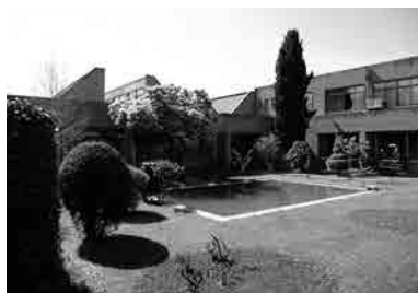
Fig. 6 y Fig. 7 Patio de acceso. Vista hacia el pórtico de entrada al conjunto (arriba) y vista hacia los cuerpos del comedor y de dirección (abajo). Fotografías actuales.
