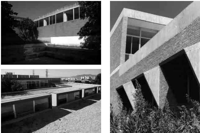
Fig. 22, Fig. 23 y Fig. 24 Aulario de Lenguaje-Antropología. Patio (arriba izquierda, fotografía actual), lucernarios (abajo izquierda, fotografía actual) y elementos de control solar en forma de voladizos y viserones (derecha, fotografía de época).
