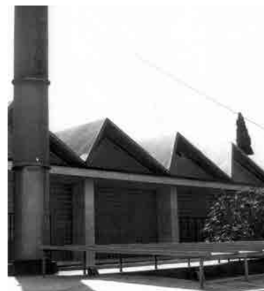
Fig. 36 y Fig. 37 Cocinas. Planta de cubiertas (izquierda) y vista parcial de la fachada abierta al patio de servicio (derecha, fotografía de época). En la imagen se observa la chimenea por la que se expulsan los humos producidos en la cocina.
