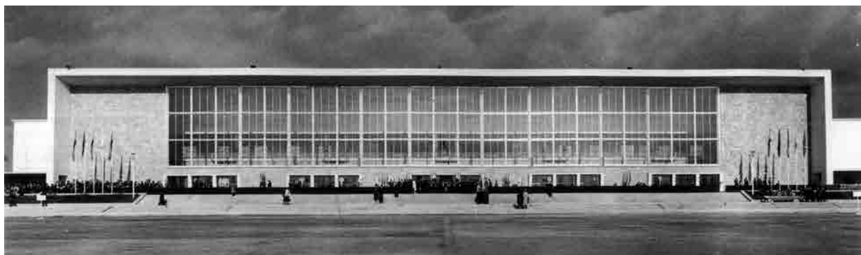
Fig. 26 Vista general de la fachada del pabellón del comedor presidiendo la explanada central del conjunto. Fotografía de época.
