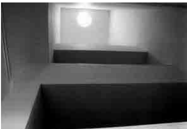
Fig. 27 Vista del lucernario que ilumina el vacío de las escaleras de las residencias. Fotografía actual.
