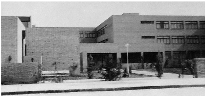
Fig. 11 Vista parcial de la fachada de la residencia.
