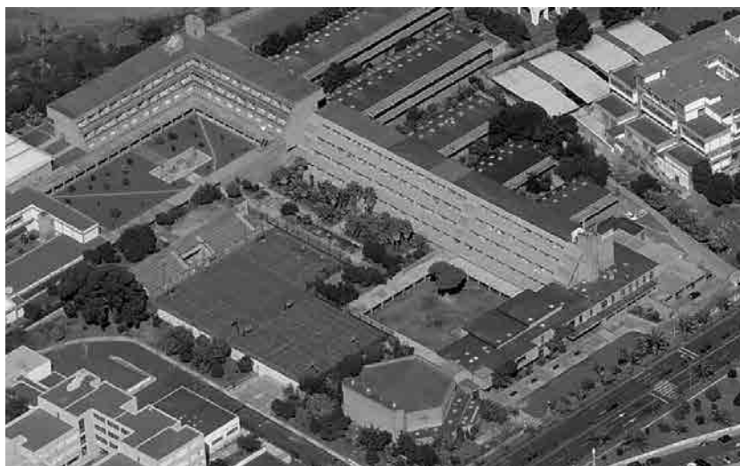
Fig. 2 Vista aérea general del conjunto desde el Sureste. Fotografía actual.
