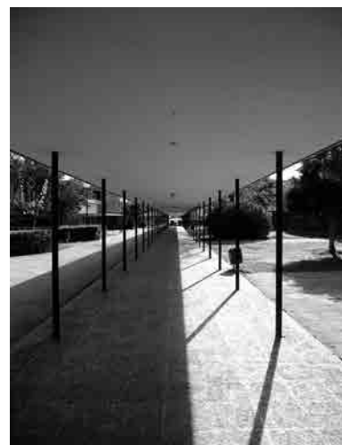
Fig. 9 Pérgolas de conexión entre los talleres y las residencias.
