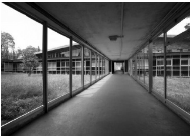
Fig. 27 Galerías cubiertas de circulación peatonal. Fotografía actual.
