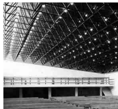
Fig. 50 Estructura estérea de barras de acero de la cubierta de la capilla. Fotografía de época.
