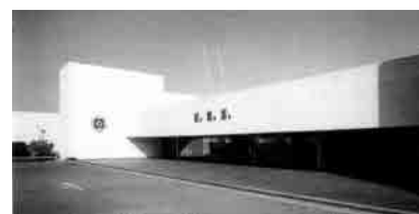
Fig. 23 Vista del acceso al edificio bajo el imponente dintel. Fotografía actual.
