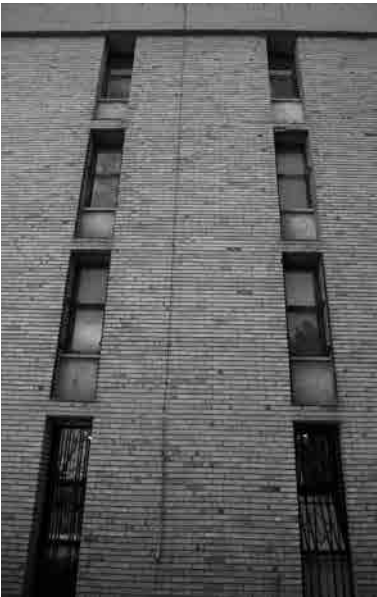
Fig. 15 Vista parcial de la fachada posterior del cuerpo de residencia. Fotografía actual.
