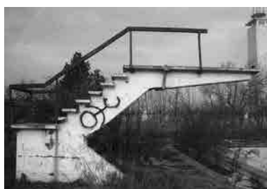
Fig. 61 Trampolín de saltos de hormigón armado. A la derecha, en la imagen, la torre del Centro. Fotografía actual.
