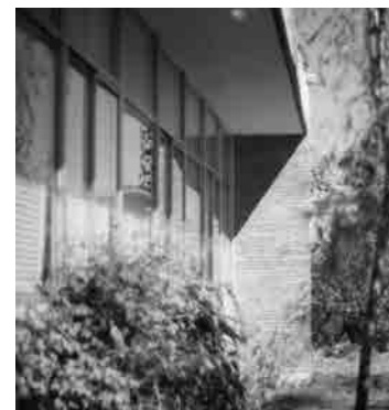
Fig. 32, Fig. 33 y Fig. 34 Aula de Formación Profesional. Planta (arriba), vista general del pabellón con su cubierta tapizada de lucernarios orientados a Norte (abajo izquierda, fotografía actual) y vista de detalle de la fachada Sur protegida por el vuelo de la cubierta (abajo derecha, fotografía de época).
