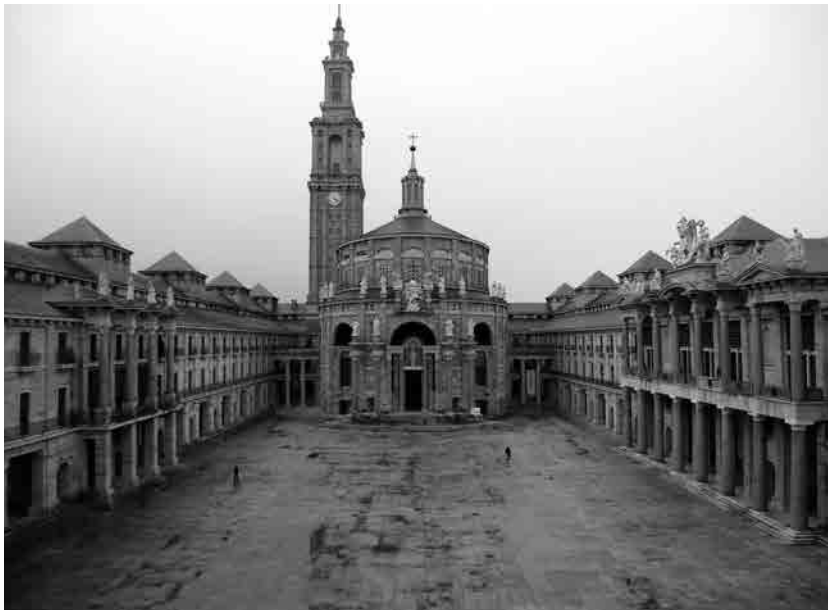
Fig. 28 Tensión figurativa entre las fachadas de los edificios institucionales y la torre en la plaza central. De izquierda a derecha en la imagen: patronato, torre, capilla y teatro.
