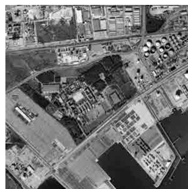
Fig. 10 Ortofoto de situación del conjunto en la actualidad.
