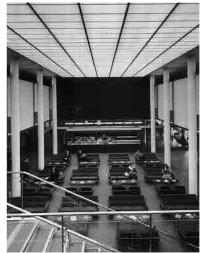
Fig. 49 Vista del vestíbulo del edificio S.A.S./Royal Hotel de Arne Jacobsen en Copenhague (Dinamarca), 1956-1961. Fotografía de época.
