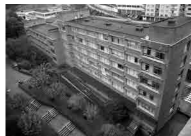
Fig. 18 Vista general de la fachada principal del edificio nº 2. Fotografía actual.
