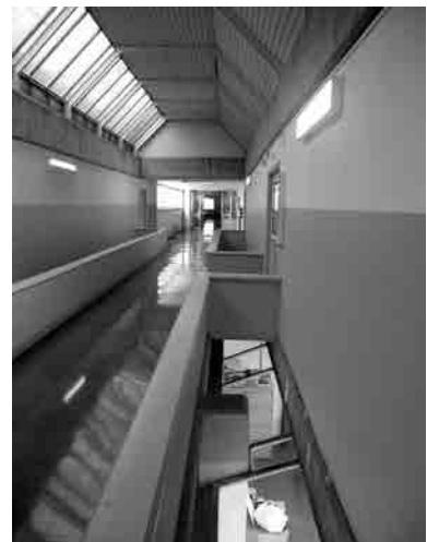
Fig. 67 Vista del corredor de la planta superior de la Escuela de B.U.P.-C.O.U. En la imagen se observa el lucernario de sección trapezoidal de la cubierta, así como las aberturas lineales practicadas en el suelo para iluminar las aulas de la planta inferior. Fotografía actual.
