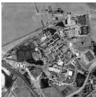
Fig. 3 Ortofoto de situación del conjunto en la actualidad.
