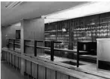
Fig. 43, Fig. 44 y Fig. 45 Edificio de comedores-cocinas y servicios. Vista parcial de la fachada Sur (arriba), vista parcial de la fachada Norte (centro) y vista de la zona de autoservicio (abajo). En la imagen del centro se observa cómo la terraza prevista en la esquina Noreste del edificio fue finalmente cerrada con fábrica de ladrillo para incorporarla al espacio interior. Fotografías de época.
