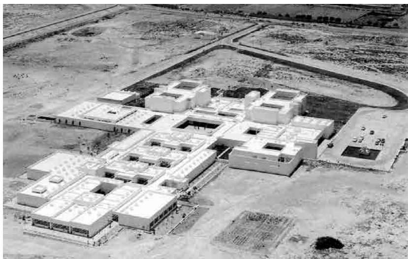
Fig. 6 Vista aérea general del conjunto. Fotografía de época.
