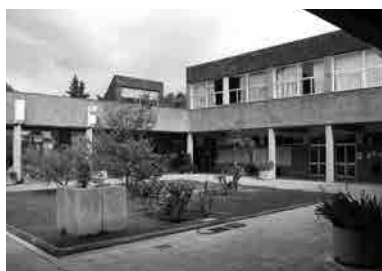
Fig. 5 y Fig. 6 Plaza de acceso. Comparativa de la misma fotografía tomada con casi cuatro décadas de diferencia: estado original (arriba) y estado actual (abajo). En ambas imágenes, a la izquierda, el pórtico de acceso a la plaza desde el exterior y, a la derecha, el cuerpo que acoge la zona de dirección.
