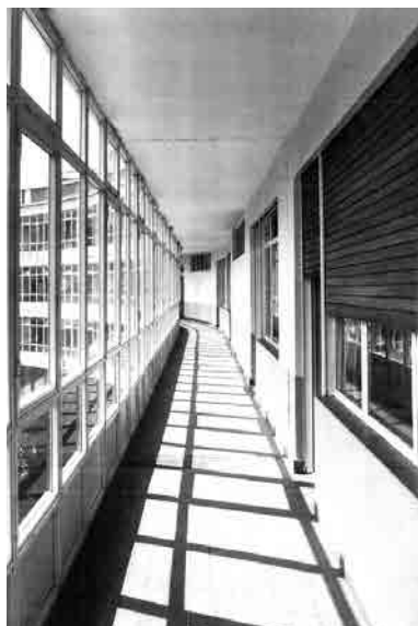
Fig. 70 Vista de las galerías de La Marina en La Coruña (arriba, fotografía actual). Fig. 71 Vista del interior de una de las galerías de las residencias (abajo, fotografía de época).
