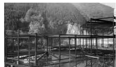
Fig. 13 Vista de la estructura metálica del edificio de servicios en construcción. Fotografía de época.
