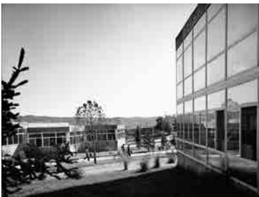
Fig. 77 Utilización de carpinterías de aluminio enrasadas a haces exteriores. Normalmente éstas llegan al dintel o forjado de techo y se apoyan sobre antepechos de altura variable. En los locales especiales se llevan hasta el suelo. En la imagen, la fachada de la biblioteca del edificio de dirección a la derecha y el aula principal a la izquierda. Fotografía de época.
