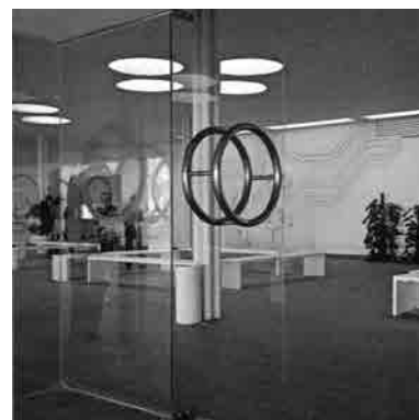
Fig. 52 Vestíbulo. En la imagen se observa la utilización de puertas de cristal sin carpintería y de tiradores circulares, así como de lucernarios redondos agrupados en ramillete. Fotografía de época.
