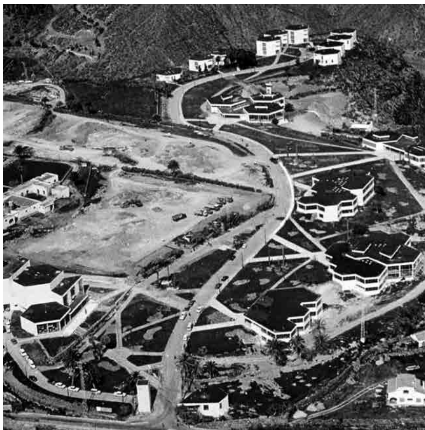
Fig. 3 Vista aérea general del conjunto. Fotografía de época.
