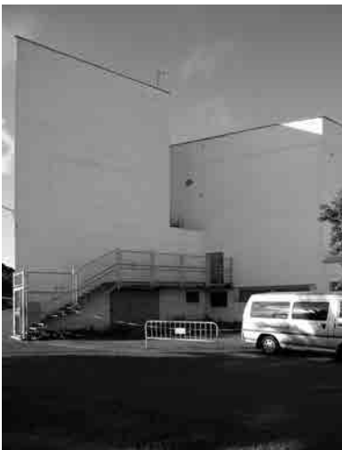
Fig. 30 Fachadas pintadas de blanco en contraste con la vegetación y utilización de carpinterías metálicas enrasadas a haces exteriores (arriba, fotografía de época). En la imagen, la fachada de uno de los comedores. Fig. 31 Vista parcial del volumen de la sala del teatro y de la caja escénica, ambos también pintados de blanco (abajo, fotografía actual).
