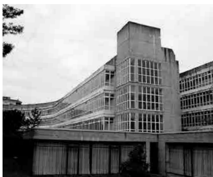
Fig. 44 y Fig. 45 Comparativa entre la fachada Sur de las residencias, rematadas en su extremo más próximo al comedor por sendos tendederos a modo de torreones acristalados (izquierda) y la fachada del edificio De Nederlanden van 1845 de Willem Marinus Dudok en Arnhem (Holanda), 1938 (derecha). Fotografías de época. En la imagen de la izquierda se observa además el cuerpo bajo que acoge las zonas comunes de las residencias, con sus carpinterías en color tabaco.
