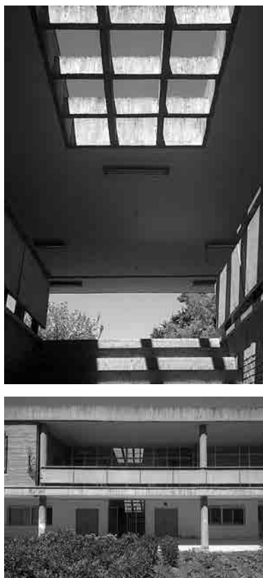
Fig. 80 y Fig. 81 Edificio de mediopensionistas. Vista de la escalera de enlace entre ambas plantas cubierta por un umbráculo en celosía (arriba) y vista parcial de la fachada Sur (abajo). Fotografías actuales.
