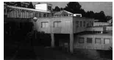
Fig. 40 Vista general del edificio de dirección-administración y enfermería. Fotografía de época.
