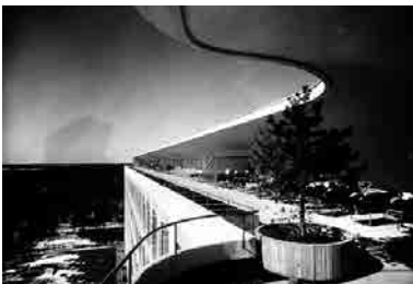
Fig. 33, Fig. 34 y Fig. 35 Comparativa entre la fachada del edificio de servicios comunes de la Universidad Laboral (arriba, fotografía actual), la del Sanatorio Antituberculoso de Leza de Pablo Zabalo Ballarín, Álava, 1934-1935 (centro, fotografía actual) y la galería de convalecientes del Sanatorio en Paimio, Finlandia, de Alvar Aalto, 1929-1933 (abajo, fotografía de época).
