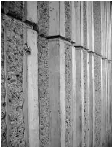
Fig. 37 y Fig. 38 Salón de actos. Vista de la estructura estérea de barras de acero de la cubierta (arriba) y vista de detalle del acabado de los muros interiores absorbentes de la sala (abajo). Fotografías actuales.
