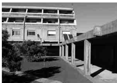
Fig. 29, Fig. 30 y Fig. 31 Ampliación de la residencia. Encuentro con el edificio de la primera fase (arriba), vista parcial del nuevo patio (centro) y vista de la fachada (abajo). Fotografías actuales.
