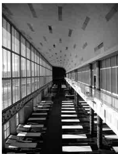
Fig. 25 Vista del interior del pabellón del comedor. Fotografía actual.
