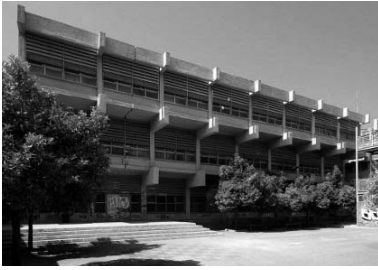
Fig. 15 Instituto Pintor Sorolla; José Ramón Azpiazu Ordóñez; Valencia, 1964-1967. En la imagen se observa el parecido con la fachada Este de los cuerpos de aulas del Centro de Tenerife.
