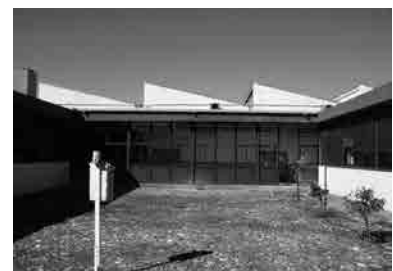
Fig. 15 y Fig. 16 Vistas de uno de los cuatro patios iguales que organizan la zona de aulas. Fotografías actuales.
