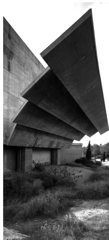
Fig. 23 Escultórico tornavoz de hormigón armado en la fachada trasera del paraninfo. Fotografía actual.
