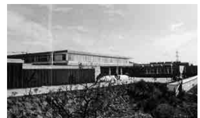
Fig. 6 Vista general de la fachada Oeste o principal de la zona docente. Fotografía de época.
