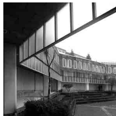
Fig. 54 Vista del porche y de la visera de cristal colgada del edificio de comedores-cocinas y servicios. Fotografía actual.
