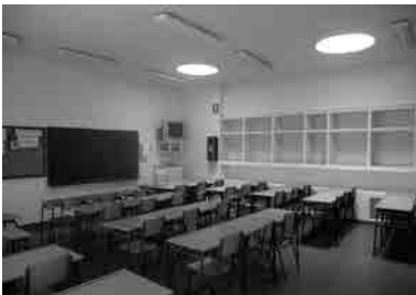
Fig. 37 y Fig. 38 Vista de uno de los patios que iluminan las aulas (arriba, fotografía de época) y vista del interior de un aula con lucernarios en su zona más profunda a fin de compensar sus inferiores niveles de iluminación (abajo, fotografía actual).
