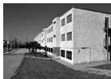
Fig. 31 Vista de uno de los pequeños patios vinculados a aulas tras la transformación de la zona de talleres por parte de los autores del proyecto original en 1970-1971 (arriba). Fotografía actual.
