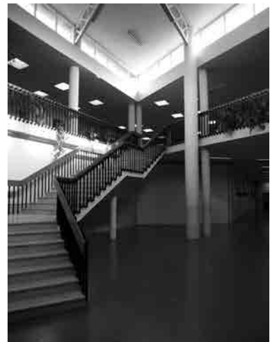
Fig. 74 Utilización de cerchas metálicas de perfiles tubulares en celosía. En la imagen, el vacío de la escalera del aula principal. Fotografía actual.
