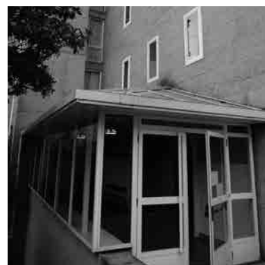
Fig. 77, Fig. 78 y Fig. 79 Principales transformaciones estéticas sufridas por el edificio. Colocación de remates en los petos de hormigón, así como de cubiertas de chapa a dos aguas y de canalones en los edificios de las residencias (arriba); colocación de una cubierta de chapa en el pabellón del comedor (centro); y colocación de cubiertas de chapa sobre las cajas de vidrio de acceso a las residencias (abajo). Fotografías actuales.
