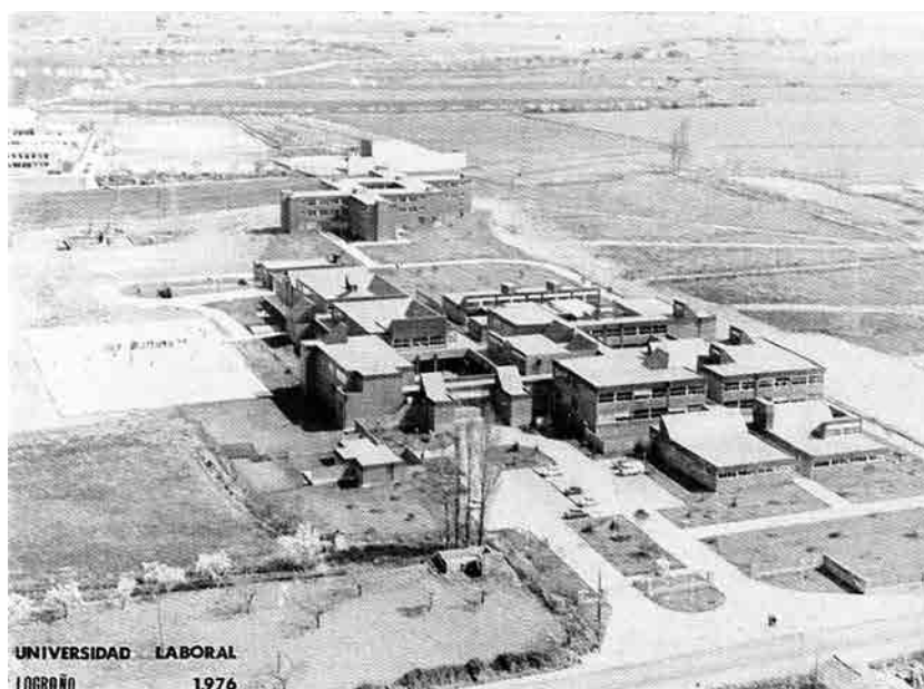
Fig. 4 Vista aérea general del conjunto. Fotografía de época.
