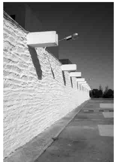
Fig. 21, Fig. 22 y Fig. 23 Guarnecidos bastos de cal en los hitos que flanquean el acceso al conjunto (arriba), en el vestíbulo del salón de actos (centro) y en la fachada del edificio (abajo). En la imagen inferior se observan además las escultóricas gárgolas de hormigón armado de las cubiertas de los talleres. Fotografías actuales.
