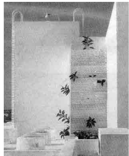
Fig. 67, Fig. 68, Fig. 69 y Fig. 70 Utilización del círculo en huecos de ventana y en maceteros ornamentales (arriba, izquierda y derecha, fotografías actuales) y utilización de tubos de acero pintados de blanco en celosías (arriba derecha, fotografía actual, y abajo derecha, fotografía de época) y puertas (abajo izquierda, fotografía actual).
