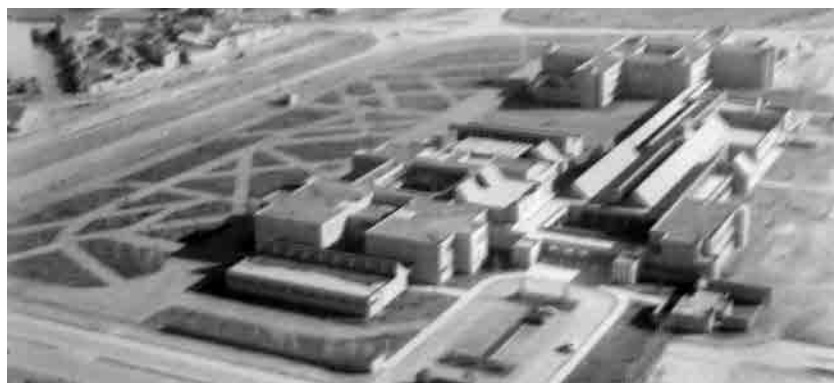
Fig. 4 Vista aérea general del conjunto. Fotografía de época.
