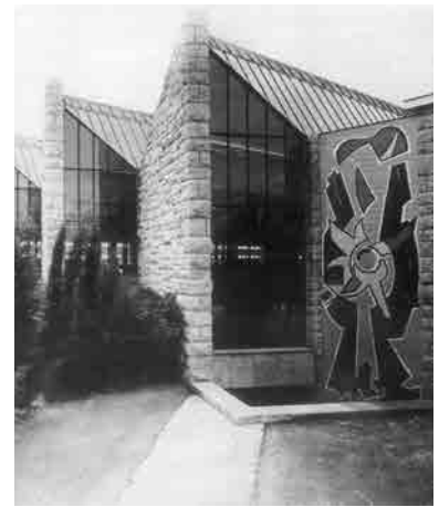
Fig. 72 y Fig. 73 Cerramiento lateral quebrado de la nave de talleres. Vista nocturna de los tramos de muro (izquierda) y vista de los tramos de carpintería y del mosaico en el encuentro entre la nave y el cuerpo de aulas (derecha). Fotografías de época.
