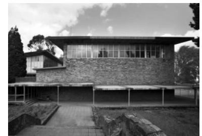
Fig. 38 y Fig. 39 Vista del interior de una de las naves de talleres (arriba) y vista de la fachada principal del pabellón del gimnasio (abajo). Fotografías actuales.
