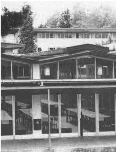
Fig. 46 Vista de la fachada lateral de uno de los edificios de residencia. Fotografía de época. En la imagen se observan los voladizos del forjado de hormigón de la cubierta, así como el canalón central de hormigón en forma de U y la mampostería de pizarra de la fachada.
