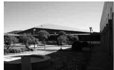
Fig. 4 Vista general del patio principal. Fotografía actual.
