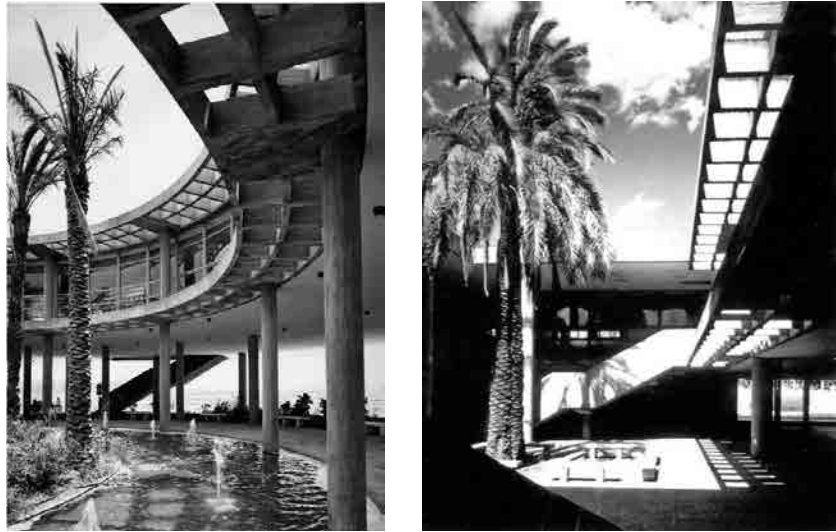
Fig. 86 y Fig. 87 Vista del patio de un comedor circular (izquierda) y vista del patio de un comedor cuadrado (derecha). Fotografías de época.
