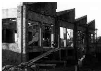
Fig. 9, Fig. 10 y Fig. 11 Distintas etapas de construcción de la Universidad Laboral: de la iglesia y su torre (arriba), de la bóveda de la iglesia (centro) y de las naves de los talleres (abajo). Fotografías de época.
