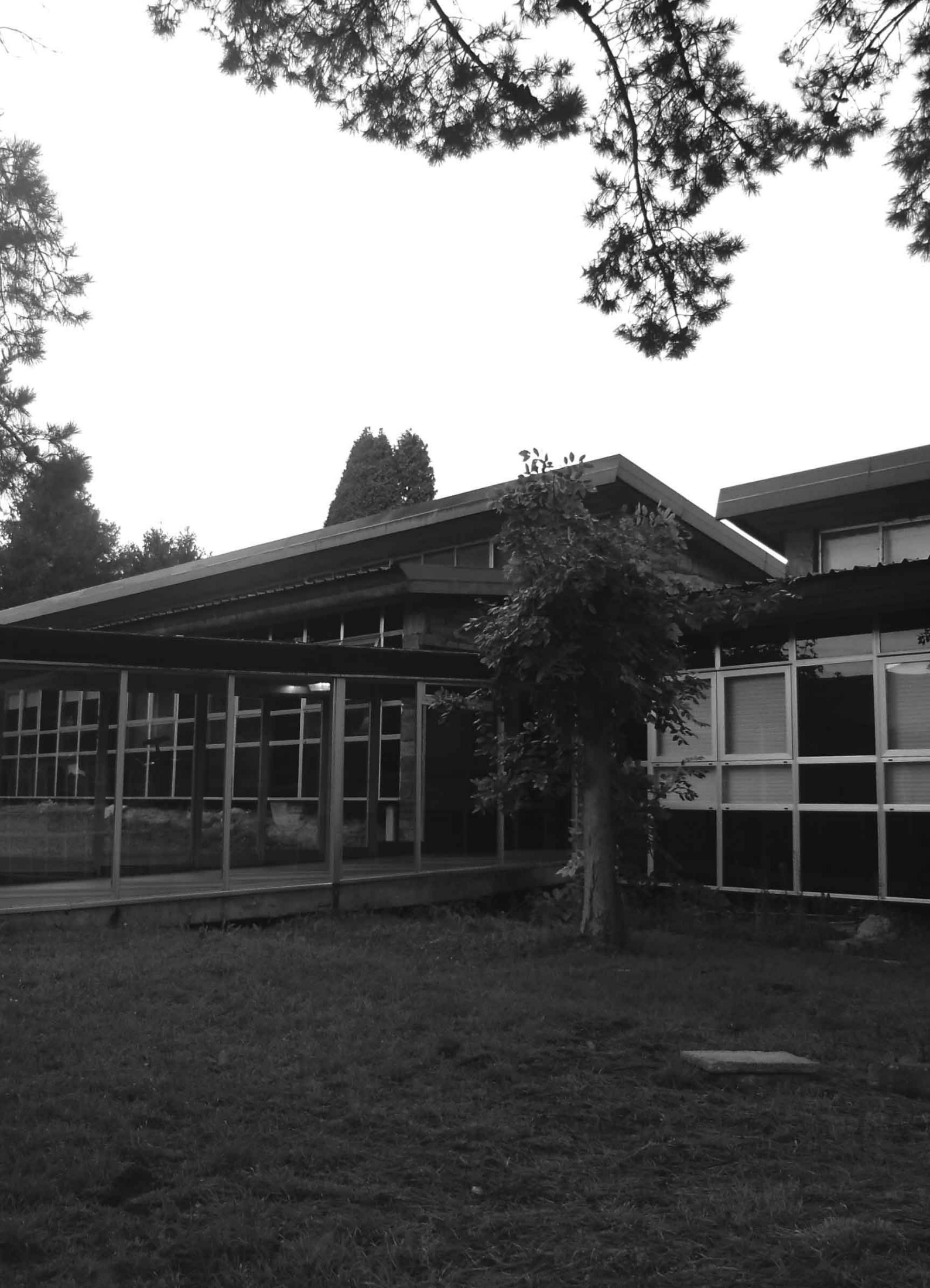
Fig. 1 Fachada Sur de un ala de aulas y galería cubierta de circulación peatonal. Fotografía actual.
