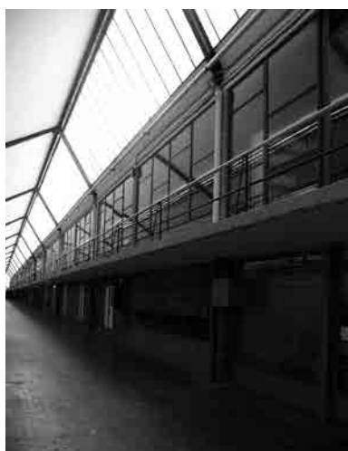
Fig. 70 y Fig. 71 Interior de la nave de talleres. Vista general (arriba, fotografía de época) y vista del corredor abierto en la planta superior del cuerpo de aulas (abajo, fotografía actual).
