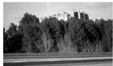
Fig. 14, Fig. 15 y Fig. 16 Vista de la plaza frente a la fachada Sur del edificio departamental (arriba, fotografía de época), vista del hospital desde dicha plaza (centro, fotografía de época) y vista del volumen del paraninfo sobresaliendo por encima de la arboleda desde la carretera (abajo, fotografía actual).
