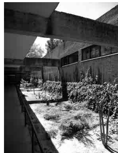
Fig. 12 Galería cubierta de conexión entre el edificio de servicios y la residencia. Fotografía actual.
