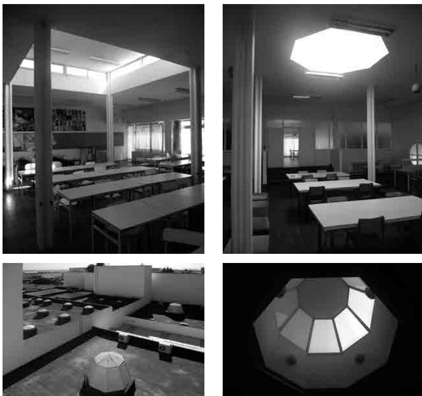
Fig. 42 Vista desde el interior del lucernario lineal de una de las aulas de Dibujo (arriba izquierda, fotografía actual). Fig. 43, Fig. 44 y Fig. 45 Lucernarios octogonales de las salas de estar de las residencias. Vista desde el interior (arriba derecha), vista desde la cubierta (abajo izquierda) y vista de detalle (abajo derecha). Fotografías actuales.
