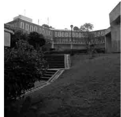
Fig. 74 y Fig. 75 Utilización de jardineras (arriba) y de taludes extendidos (abajo) para conseguir la transición entre el terreno modificado y el terreno natural. Fotografías actuales.
