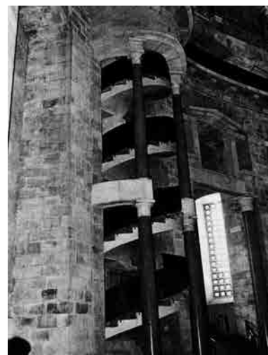
Fig. 51 y Fig. 52 Interior de la capilla. Bóveda (arriba) y escalera de acceso a las galerías superiores de la nave (abajo). Fotografías de época.
