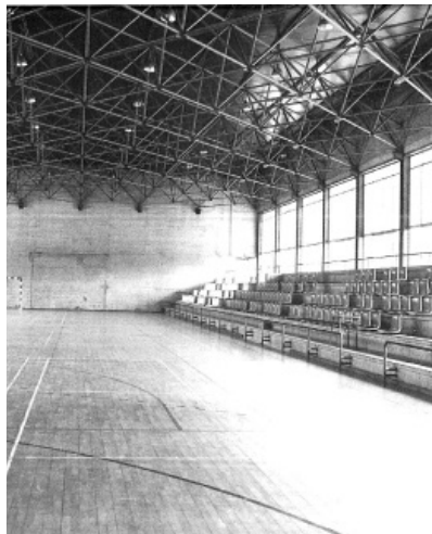
Fig. 61, Fig. 62 y Fig. 63 Pabellón polideportivo. Vista parcial de la fachada (izquierda), vista del interior con la grada y la estructura estérea de la cubierta (centro) y vista del volumen de vidrio de acceso al edificio (derecha). Fotografías de época.
