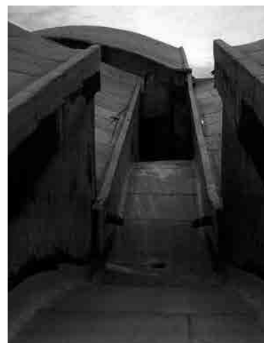
Fig. 81 Canalones de desagüe entre las naves de talleres. Fotografía actual.
