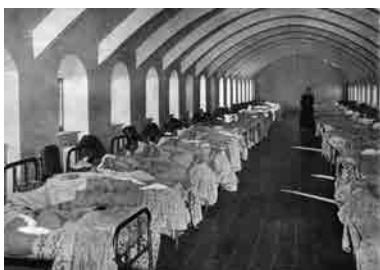
Fig. 20 y Fig. 21 Pabellón de alumnos internos. Vista general (arriba) e interior de uno de los dormitorios comunes (abajo). Fotografías de época.
