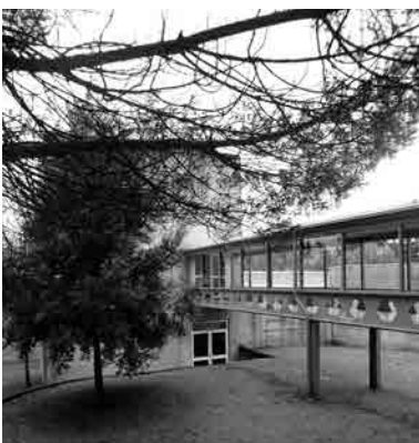
Fig. 48 y Fig. 49 Fachada Sur del aula de B.U.P. y Actividades Estéticas (arriba) y pasarela de conexión con los talleres (abajo). Fotografías actuales.
