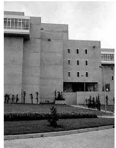
Fig. 95 Vista parcial de la fachada trasera (Norte) de los bloques de residencia del Centro de Universidades Laborales de Orense. En la imagen se observa cómo se maclan los contundentes volúmenes de hormigón visto. Fotografía de época.
