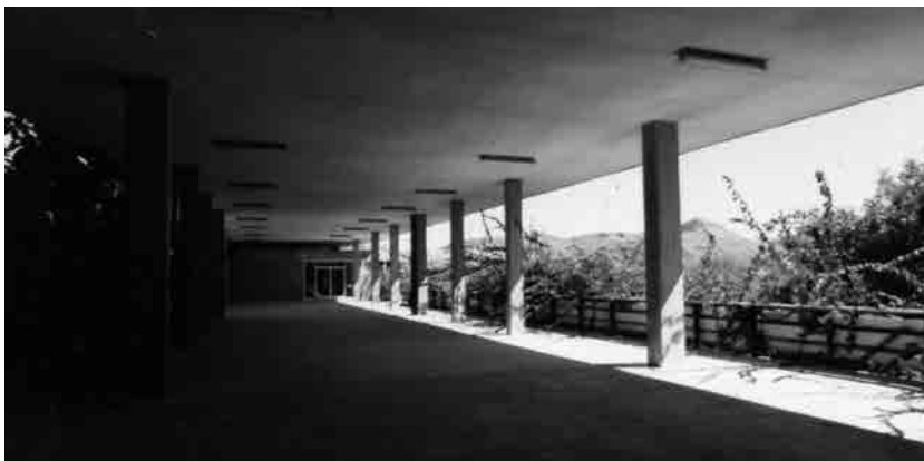
Fig. 31 Porche perimetral del edificio de dirección del Centro de Málaga para recreo de los alumnos y para organizar el acceso a los pabellones docentes. Fotografía de época.
