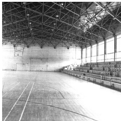
Fig. 28, Fig. 29 y Fig. 30 Pabellón polideportivo del Centro de Universidades Laborales de Orense. Vestíbulo acristalado de acceso (izquierda), vista del interior con la estructura estérea de la cubierta (centro) y fachada (derecha). Fotografías de época.
