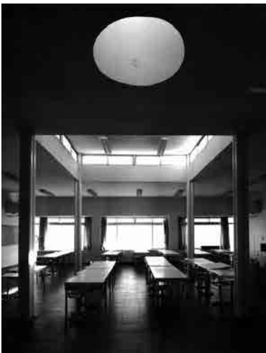
Fig. 16 y Fig. 17 Vista del interior de un aula de Dibujo (arriba) y de un taller o laboratorio (abajo) del Centro de Universidades Laborales de Almería. Fotografías actuales. Además de los lucernarios circulares al fondo de las aulas, en algunos casos aparecen recortes del forjado del techo elevados sobre pilares enanos dando lugar a lucernarios perimetrales.
