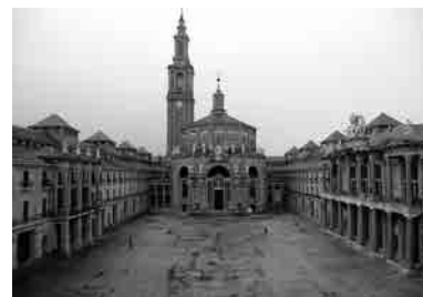
Fig. 4 Plaza o patio central de la Universidad Laboral de Gijón. En la imagen se observa, además del enorme parecido con la Città Ideale , el diálogo y la gran tensión figurativa que se producen en este espacio vacío entre la capilla, que preside el conjunto, y las fachadas del teatro (a la derecha en la imagen) y del patronato (a la izquierda). Fotografía actual.
