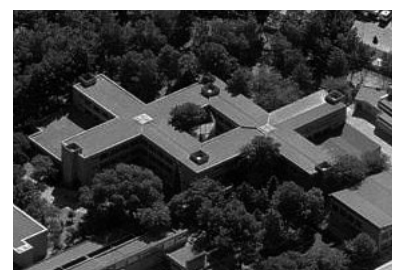
Fig. 43 y Fig. 44 Edificios de residencia de los Centros de Lardero (arriba) y de Albacete (abajo).
