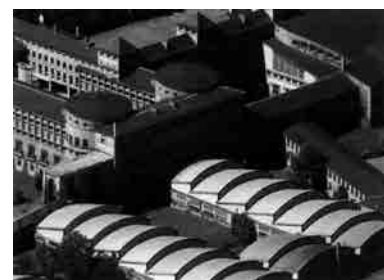
Fig. 1, Fig. 2, Fig. 3, Fig. 4, Fig. 5 y Fig. 6 Talleres de la Universidad Laboral de Gijón (de arriba a abajo): esquema de la planta general del Centro con indicación de la posición de los talleres; vista general; galería de la fachada Sur; galería de la fachada Norte; apéndice inacabado de la galería Sur; y encuentro de las naves con el edificio noble.
