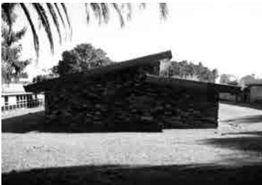
Fig. 33 Parasoles de hormigón armado prefabricado de la biblioteca del Centro de Universidades Laborales de Málaga (arriba, fotografía de época). Fig. 34 Voladizos de la cubierta de las bandas de aulas de la Universidad Laboral de La Coruña (abajo, fotografía actual).
