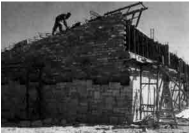
Fig. 8 Colocación de sillares de piedra de Mèdol en el grupo escolar de la Universidad Laboral de Tarragona. Fotografía de época.
