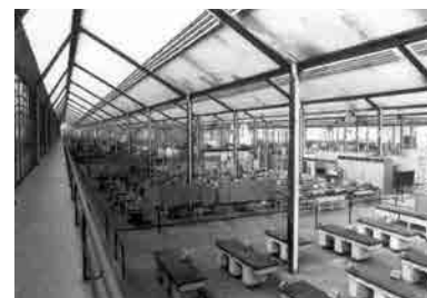
Fig. 19, Fig. 20 y Fig. 21 Taller de la Universidad Laboral de Tarragona. Vista general de la fachada Norte del cuerpo de aulas o de acceso (arriba, fotografía actual), vista general de la fachada Sur de la nave o de servicio (centro, fotografía de época) y vista del interior de la nave (abajo, fotografía de época).
