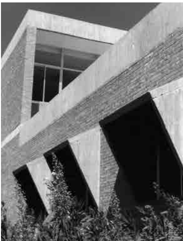
Fig. 35 Viseras de hormigón armado prefabricado sobre los huecos del aula de Lenguaje-Antropología del Centro de Málaga. Fotografía de época.
