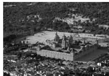
Fig. 1 Vista aérea de la posición relativa de la Universidad Laboral de Gijón respecto a la ciudad asturiana. En la fotografía se observa cómo la fachada principal del conjunto, la orientada a Este, no mira hacia la ciudad, sino que le da la espalda. Fotografía de época. Fig. 2 Vista aérea del Real Sitio o Monasterio de San Lorenzo de El Escorial.
