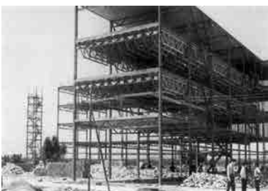
Fig. 9 y Fig. 10 Construcción de las estructuras de los colegios de las Laborales de Córdoba (arriba) y de Tarragona (abajo). Fotografías de época.
