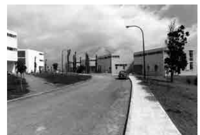
Fig. 46 Esquema de la planta general del Centro de Universidades Laborales de Toledo indicando las partes construidas y los vacíos (arriba). Fig. 47 y Fig. 48 Espacio libre entre el pabellón de dirección y el de comedores-cocinas del Centro de Toledo (centro) y conjunto de residencias del Centro de Las Palmas (abajo). Fotografías de época.
