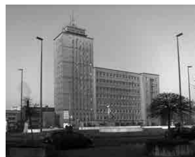
Fig. 2 Edificio principal de la Universidad del Trabajo “Paul Pastur” de Charleroi (Bélgica). Fotografía actual.
