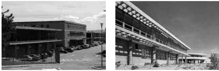
Fig. 21 y Fig. 22 Comedores y servicios del Centro de Cheste. Vista general de la fachada trasera (izquierda, fotografía actual) y comedores (derecha, fotografía de época).
