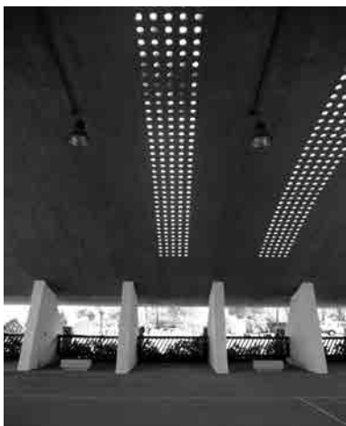
Fig. 5 y Fig. 6 Pabellones cubiertos de gimnasia de la Universidad Laboral de Sevilla. Vista desde el interior de las perforaciones cilíndricas en los tramos centrales de la bóveda (izquierda) y vista general exterior (derecha). Fotografías actuales.
