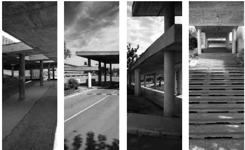
Fig. 9, Fig. 10, Fig. 11 y Fig. 12 Circulaciones peatonales exteriores a cubierto del Centro de Orientación de Universidades Laborales de Cheste. Fotografías actuales.
