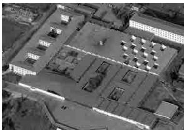
Fig. 10 Universidad Laboral de Cáceres. El ala de residencias se sitúa en el borde Este del conjunto. Fotografía actual.
