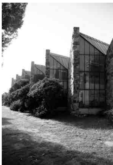
Fig. 24 y Fig 25 Cerramiento lateral quebrado de la nave del taller de la Universidad Laboral de Tarragona. Vista de los tramos de muro (arriba) y de los tramos de carpintería (abajo). Fotografías actuales.
