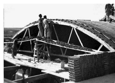
Fig. 1, Fig. 2 y Fig. 3 Universidad Laboral de Gijón. Iglesia en construcción (arriba), esquema de construcción de las bóvedas tabicadas (centro) y bóvedas en construcción (abajo). Fotografías de época.
