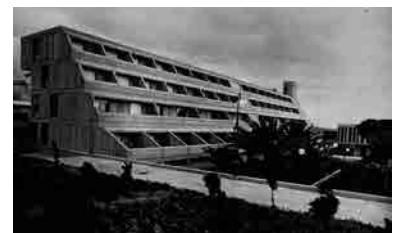
Fig. 16 Fachada Sur del bloque escalonado de residencia del Centro de Tenerife. Fotografía de época.
