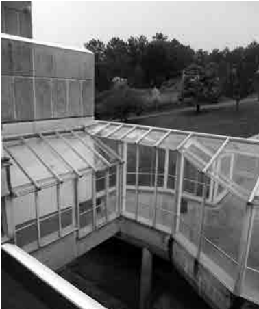
Fig. 116 Pasarela elevada acristalada de conexión entre la zona común y las residencias. Fotografía actual.
