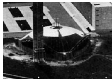
Fig. 16 Construcción de la torre y de la cubierta de la capilla de la Universidad Laboral de Córdoba. Fotografía de época.
