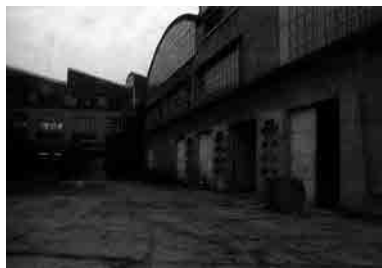
Fig. 3 Talleres de la Universidad Laboral de Gijón. Fachada Norte o trasera con portones de servicio para el acceso de mercancías y maquinaria al plano de trabajo.
