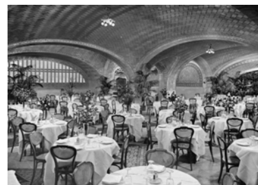
Fig. 4 Las bóvedas tabicadas de Luis Moya podrían relacionarse con las tradicionales bóvedas catalanas. Un maravilloso ejemplo de la capacidad técnica y belleza de este sistema constructivo lo encontramos en la obra del arquitecto valenciano Rafael Guastavino i Monero (Valencia 1842 - Baltimore 1908), que importó la técnica a los EE.UU., donde The R. Guastavino Company realizó, en colaboración con algunas de las figuras más destacadas del panorama americano, gran número de edificios que constituyen a día de hoy parte de la identidad arquitectónica norteamericana. Hasta 1962, año en que cierra La Compañía, ésta construye más de 1000 edificios, sobre todo en EE.UU., pero también en otros países como Canadá, India o Cuba. Para ampliar la información se recomienda consultar la web < http://www.rafaelguastavino.com > creada con motivo de la Exposición conmemorativa del Centenario de su desaparición. Asimismo existen numerosas publicaciones. En la imagen, el Oyster Bar en Grand Central Terminal, Nueva York, 1912.
