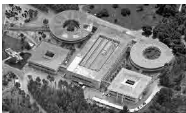
Fig. 5 y Fig. 6 Esquema de la planta general del Centro de Cheste con indicación de la posición del edificio de comedores-cocinas y servicios (arriba) y vista del mismo (abajo, fotografía actual).
