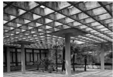
Fig. 23 y Fig. 24 Centro de Cheste. Costillas de hormigón armado del paraninfo (arriba, fotografía de época) y forjados reticulares en el edificio del rectorado y cafetería (abajo, fotografía actual).
