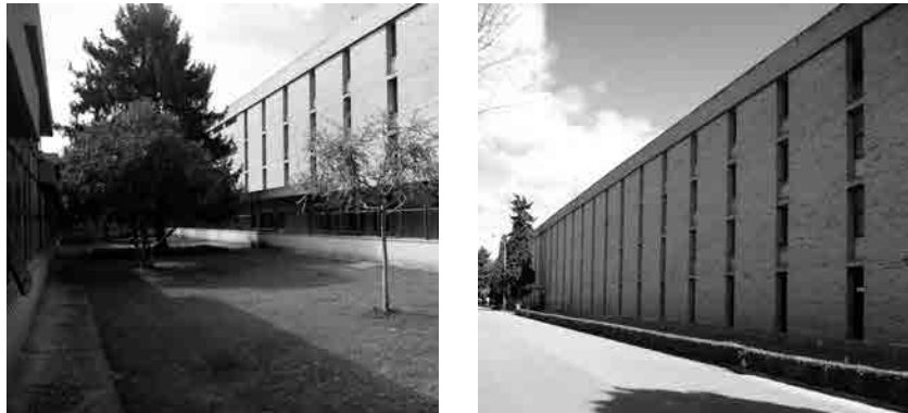
Fig. 70 y Fig. 71 Residencias de la Universidad Laboral de Huesca. Vista de la fachada desde el patio que separa la zona de residencia de la zona de dirección (izquierda) y vista general de la fachada posterior (derecha). Fotografías actuales.
