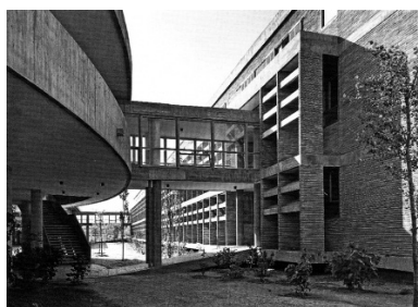
Fig. 34 y Fig. 35 Edificio de servicios del Centro de Cheste. Fachada lateral con parasoles y persianas mallorquinas (arriba) y galería de conexión entre las cocinas y uno de los comedores circulares (abajo). Fotografías de época.
