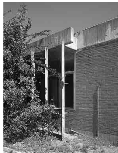
Fig. 32 Parasoles de hormigón armado prefabricado del aula de Ciencias del Centro de Universidades Laborales de Málaga. Fotografía actual.
