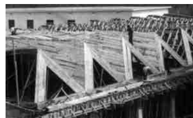
Fig. 11, Fig. 12 y Fig. 13 Universidad Laboral de Tarragona. Construcción de las cerchas metálicas de los talleres (arriba), de la cubierta del comedor (centro) y de la lámina de hormigón de la cocina (abajo). Fotografías de época.
