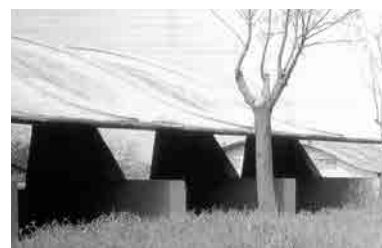
Fig. 14 y Fig. 15 Universidad Laboral de Sevilla. Estructura metálica de las naves de talleres (arriba) y lámina de hormigón de los gimnasios (abajo). Fotografías actuales.
