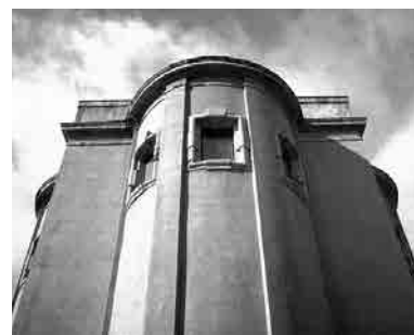
Fig. 25 Vista exterior del volumen que alberga el presbiterio de la iglesia de la Universidad Laboral de Zamora. Fotografía actual.
