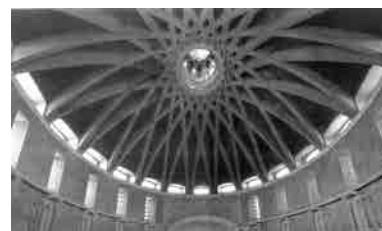
Fig. 11 y Fig. 12 Plano de la estructura de la cubierta de la iglesia de la Laboral de Gijón (arriba) y vista interior de la cúpula nervada (abajo, fotografía de época).
