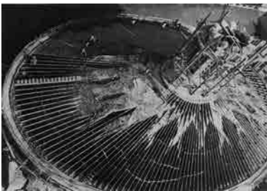
Fig. 5, Fig. 6 y Fig. 7 Vistas de las distintas fases de la construcción de la bóveda de arcos entrelazados de la iglesia de la Universidad Laboral de Gijón. Fotografías de época.
