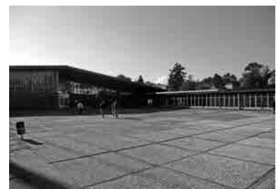
Fig. 34 y Fig. 35 Plazas de acceso de las Universidades Laborales de Sevilla (arriba, fotografía de la década de los 80) y de La Coruña (abajo, fotografía actual).
