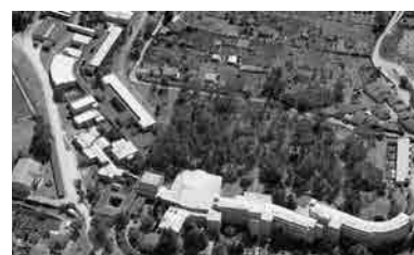
Fig. 42 y Fig. 43 Centro de Universidades Laborales de Orense. Vista aérea general de la fachada orientada a Sur y abierta al pinar (arriba) y de la fachada orientada a Norte (abajo). Fotografías actuales. En la imagen inferior se observa el aspecto encastillado de los volúmenes de la zona de residencias.
