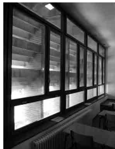
Fig. 30 y Fig. 31 Vista de las soluciones de parasoles de hormigón armado prefabricado utilizadas en las fachadas orientadas a Sur de los talleres y aulas del Centro de Cheste (arriba, fotografía de época) y vista del interior de un aula tipo (abajo, fotografía actual).
