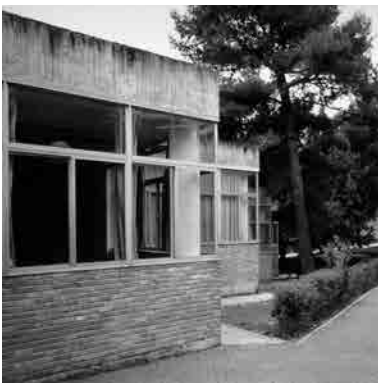
Fig. 17, Fig. 18 y Fig. 19 Centro de Cheste. Despiece de los encofrados del hormigón de las costillas del paraninfo (arriba), parasoles de ladrillo y carpinterías de madera en el hospital (centro) y ladrillo acústico en el interior de algunos locales (abajo). Se trata del mismo tipo de ladrillo empleado en la construcción de los cerramientos, esta vez colocado a panderete. Fotografías actuales.
