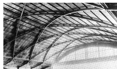
Fig. 31, Fig. 32 y Fig. 33 Vistas del interior de la Nave I de talleres de la Laboral de Sevilla (arriba), de la Imprenta en Tours (centro) y del Hangar en Cuatro Vientos (abajo). Fotografías de época.
