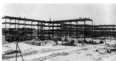
Fig. 28 Universidad Laboral de Tarragona. Residencias en construcción. Fotografía de época.
