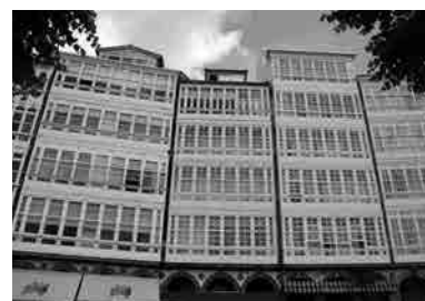
Fig. 47, Fig. 48, Fig. 49 y Fig. 50 Comparativa entre (de arriba a abajo) las galerías acristaladas del Centro de Orense (fotografía actual), las del Auditorio de Galicia (fotografía de época), las de las viviendas en Vite (fotografía de época) y las de La Marina en La Coruña (fotografía actual).
