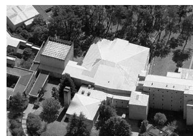
Fig. 11 y Fig. 12 Centro de Universidades Laborales de Orense. Esquema de la planta general del conjunto con indicación de la posición del edificio de comedores, cocinas y cafetería (arriba) y vista del mismo (abajo, fotografía actual).
