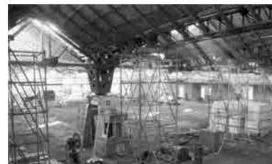
Fig. 11, Fig. 12 y Fig. 13 Universidad Laboral de Tarragona. Construcción de las cerchas metálicas de los talleres (arriba), de la cubierta del comedor (centro) y de la lámina de hormigón de la cocina (abajo). Fotografías de época.
