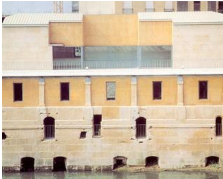
_Juan Navarro Baldeweg, Ricostruzione dei Mulini del Rio Segura e trasformazione in Centro Culturale e Museo Idraulico, Murcia (Spagna), 1990.
