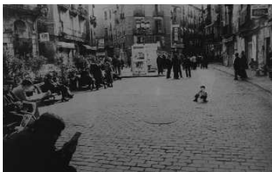
Fig. 4-13_ Peatonalización de la Plaza de Sant Agustí en el Casc Antic.
