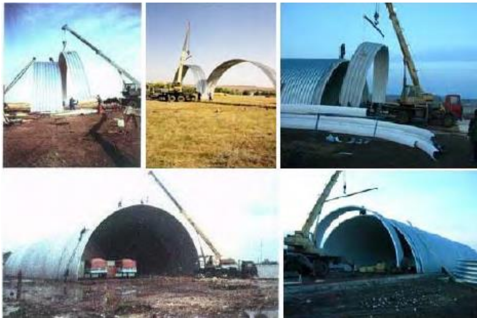
Figura 2.48. Construcción de un hangar. ( www.archconstruction.ru/data/Chine_machines.pdf ).
