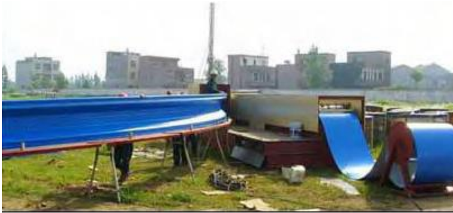
Figura 2.46. Proceso de fabricación "in situ", ( www.archconstruction.ru/data/Chine_machines.pdf )
