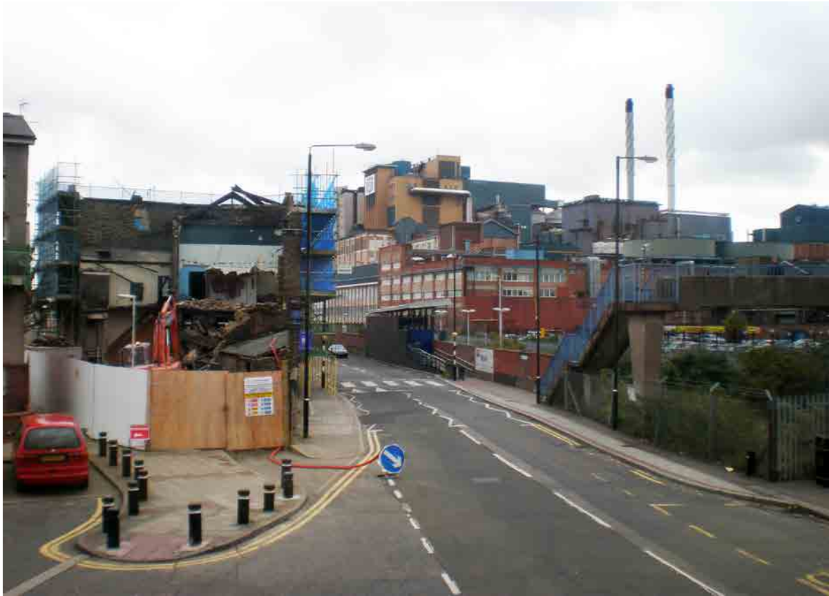
Figura 5-1: Enderrocament d'habitatge i teixit industrial a l'entrada de Woolwich North, Road Factory, Royal Docks. Accés amb línia d'autobús urbà. Imatge: M.Serra durant la visita al lloc, octubre 2010.
