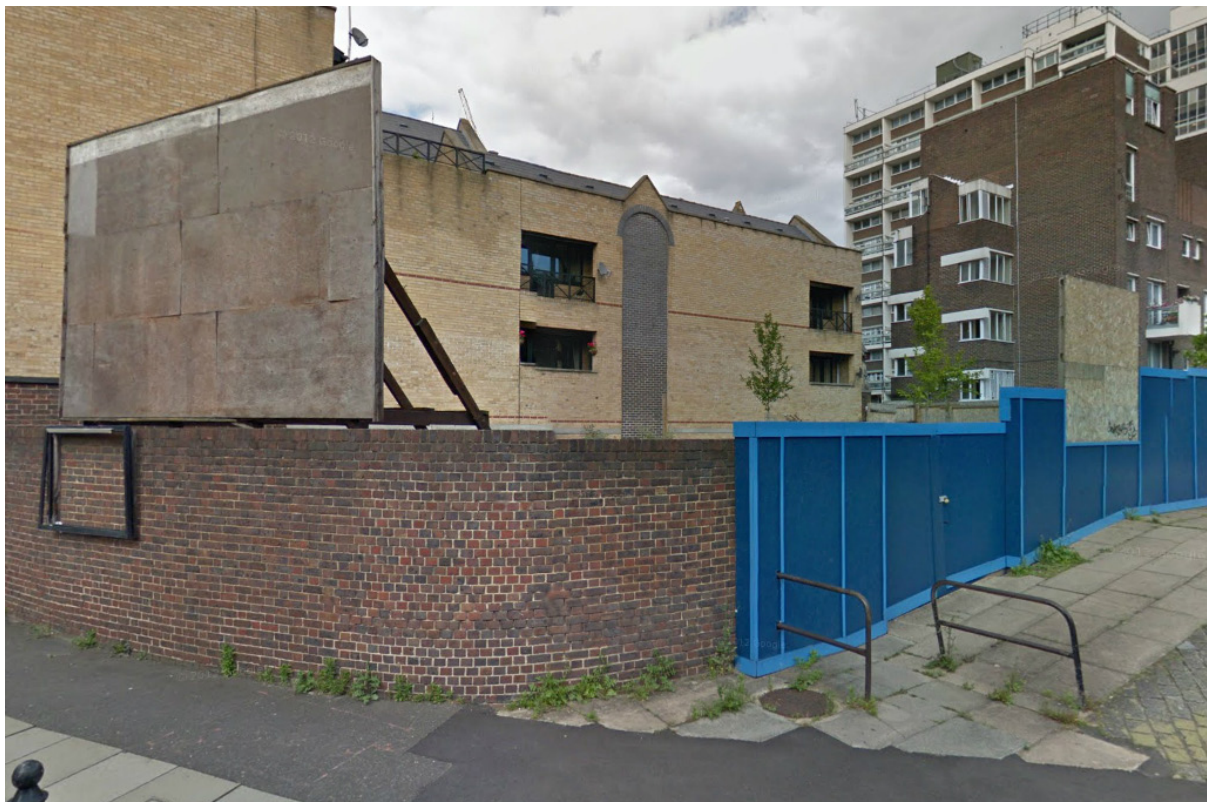
Figura 5-12: Situació actual 2012. Restes del plafó i estructura de suport 30 anys després. Font: Google Maps.
