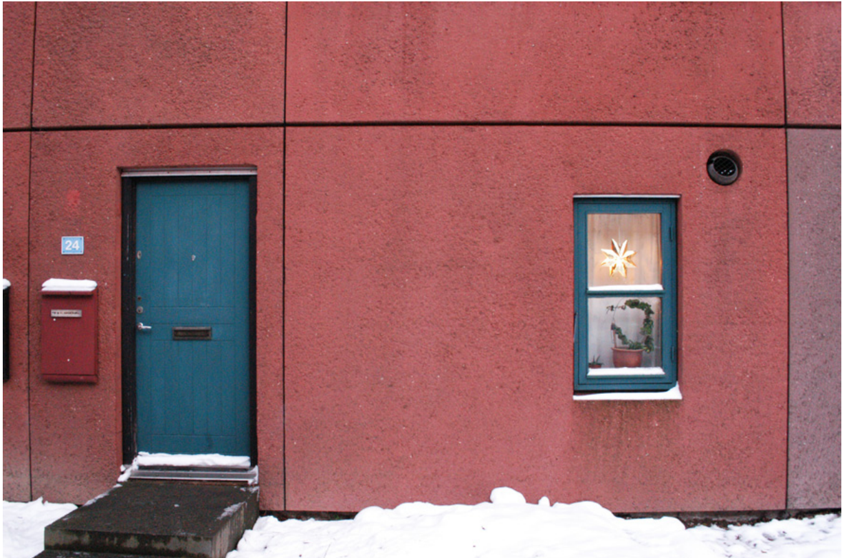
Figura 2-7: Imatge actual de façana prefabricada al barri de HyldeSPAeldet, creixement posterior que es va fer seguint els mateixos criteris funcionals de cases amb pati interior. Autora: M.Serra durant la visita a Albertslund, desembre 2009.
