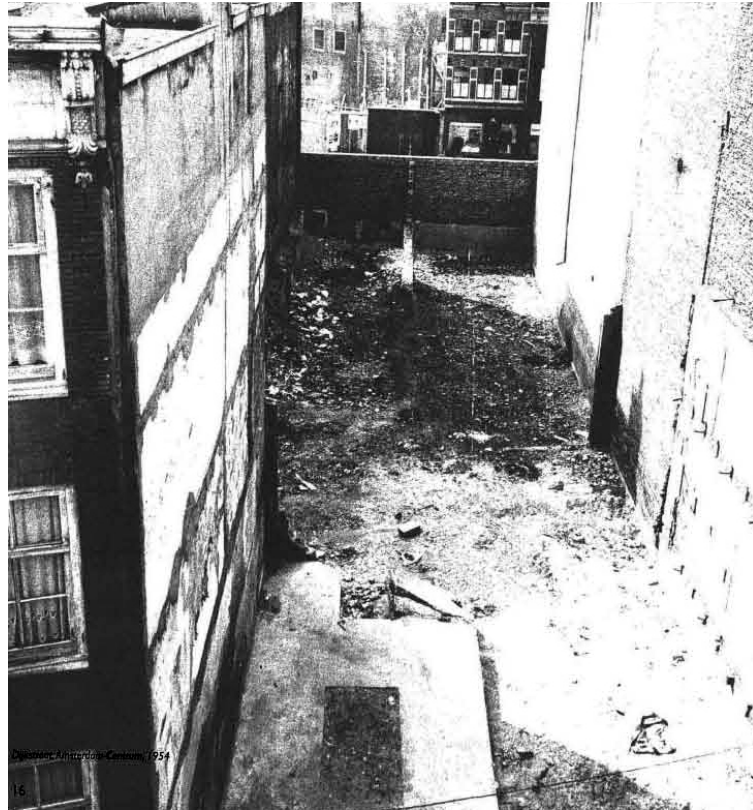
Figura 4-15: Solar abandonat Dijkstraat, Amsterdam Centre. Aldo van Eyck, 1954. Font: (Lefavre et al. 2002)
