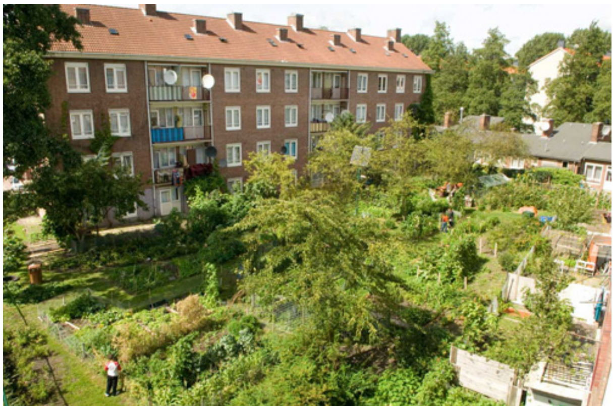
Figura 3-13: Solar kijkgroen després de la intervenció, octubre 2010. Font: (Potrč i Wilde Westen 2010:20)
