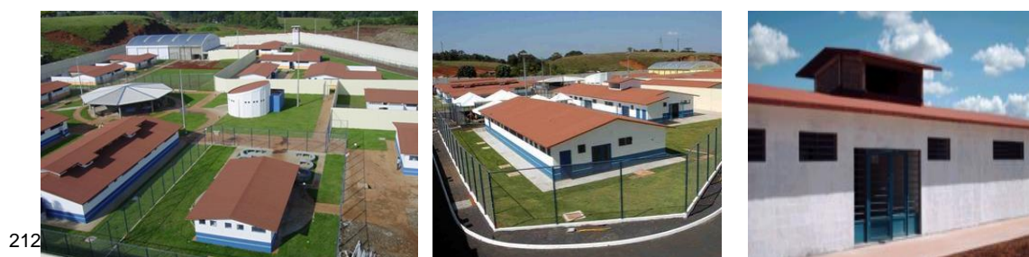
ILUSTRACIÓN 137: VISTA AÉREA DEL CONJUNTO DEL CENSE Y DETALLE DE LA FACHADA DEL EDIFICIO SIN ACABAMIENTO
