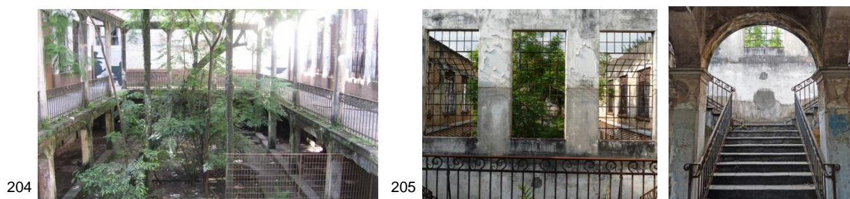
ILUSTRACIÓN 131: EL HIERRO UTILIZADO COMO ELEMENTO DE COMPOSICIÓN EN LAS BARANDILLAS, ANTEPECHOS Y PASAMANOS DE LA CIRCULACIÓN INTERNA DEL EDIFICIO
