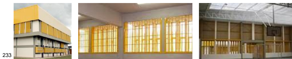
ILUSTRACIÓN 152: VISTA EXTERNA DEL ELEMENTO DE HORMIGÓN EN EL CERRAMINETO Y VISTA INTERNA DE LA REJAS DE CONTENCIÓN
