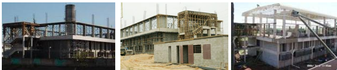
ILUSTRACIÓN 136: ESTRUCTURA EN HORMIGÓN Y COBERTURA METÁLICA DE LOS CENTROS DE LA FUNDACIÓN CASA
