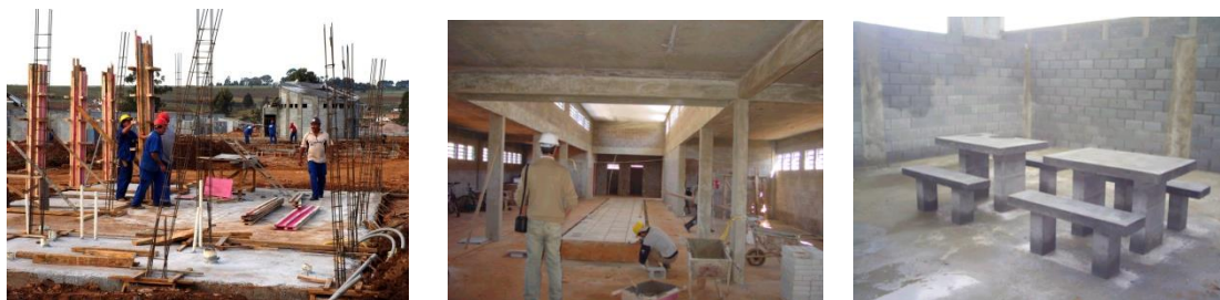
ILUSTRACIÓN 138: CANTERO DE OBRA, VISTA INTERNA Y MOBILIARIO EN HORMIGÓN
