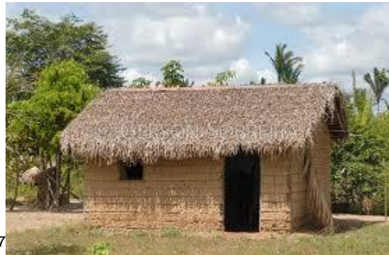
ILUSTRACIÓN 12: ESTRUCTURA PRIMARIA DE LA CONSTRUCCIÓN RUSTICA DE REVESTIMIENTO EN BARRO Y COBERTURA DE PAJA
