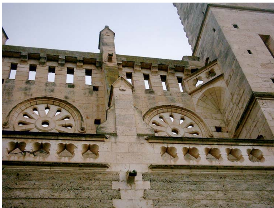
Fig. 34. Exterior de la Església Nova (detalle)
