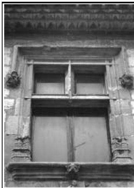
D. Finestra situada damunt la porta d'entrada de l'hospital de Montblanc.
