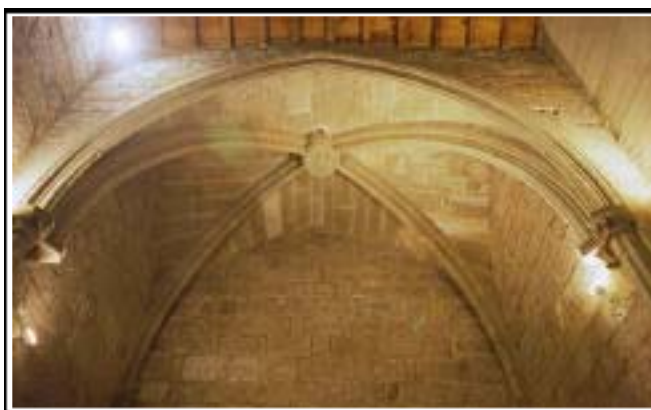
Vista general i volta de creueria, de la capella situada a l'angle nord-est de l'edifici.
