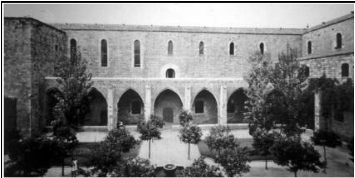
B. Vista del sector nord-occidental del claustre, a mitjan s. xx. A l'esquerra, en el sobreclaustre septentrional, s'observa la galeria afegida durant les restauracions dirigides per Adolf Florensa.
