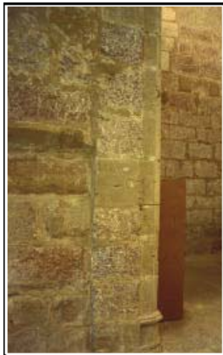
A. Detall de la unió de la capella amb els murs preexistents de l'edifici.
