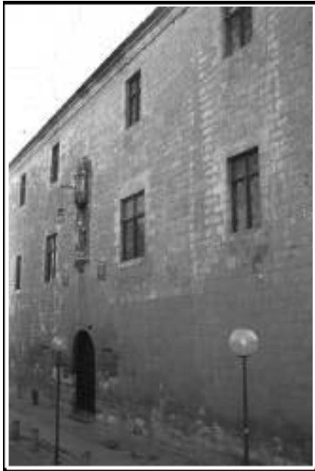
A. Façana principal.
