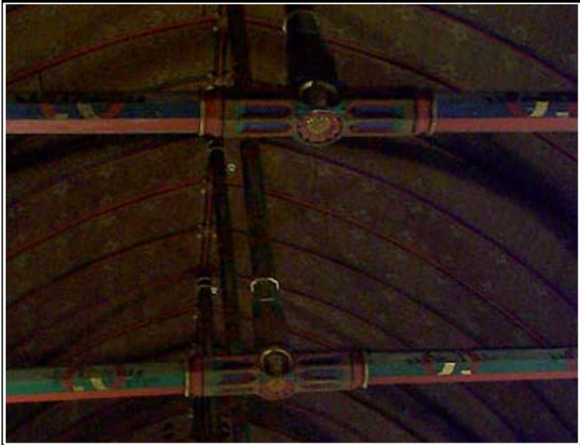
A. Detall de la volta policromada de fusta i reforçada amb tirants, de l'hotel-Dieu de Beaune. (Clixé: Hôtel-Dieu de Beaune)
