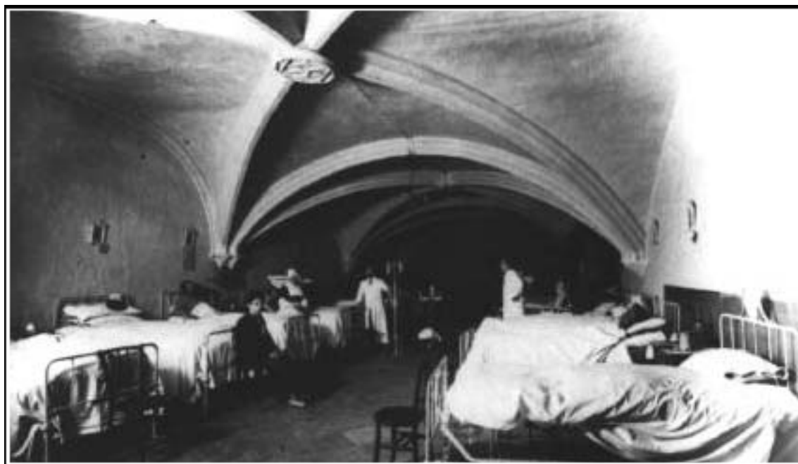
Fotografies de la fi del s. XIX de dues crugies de la planta baixa de l'antic hospital de Santa Maria de Lleida. S'observa l'existència d'un forjat que dividia aquests àmbits en dos nivells, eliminat en intervencions posteriors.
