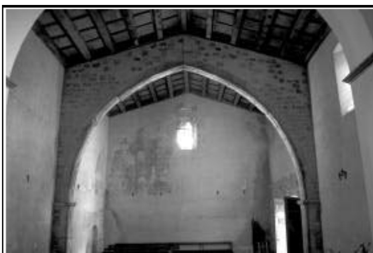
D. Detall del vèrtex dels arcs diafragma del nivell superior.
