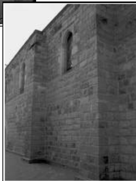
D. Eixamplament del mur del sobreclaustre septentrional.
