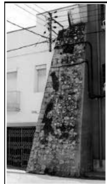
D. Rafa emprada com a element de contrafort de l'angle sud-oriental de l'hospital.
