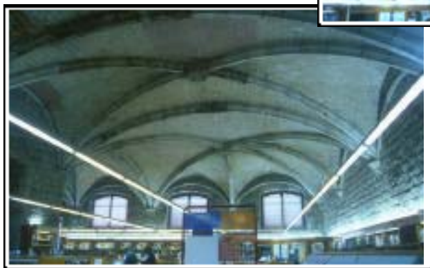
B–C. Detall de les voltes reconstruïdes i peraltades al s. XVII, de la meitat occidental de la crugia inferior septentrional.
