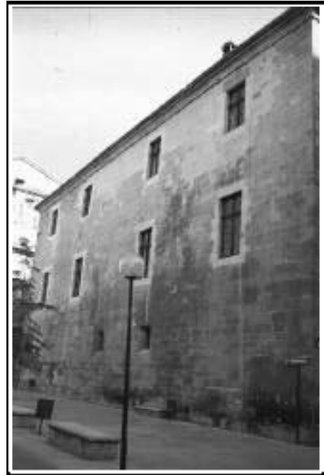
B. Façana occidental.
