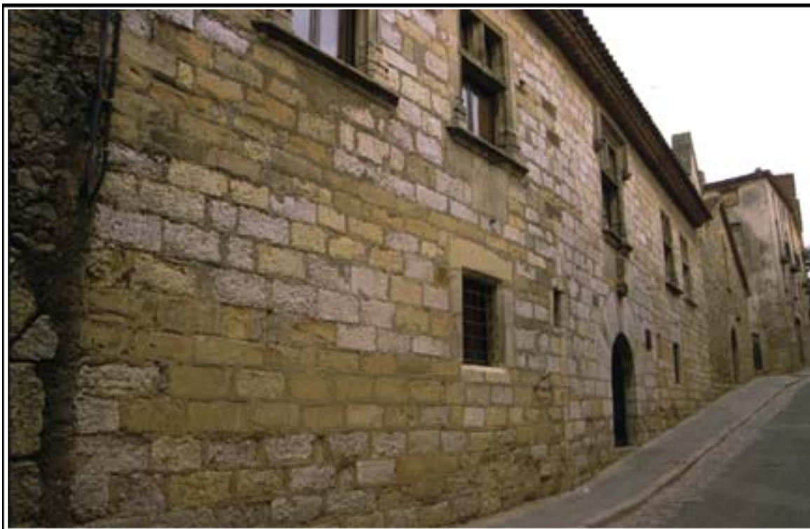
Vistes generals de la façana, en direcció sud i nord respectivament.
