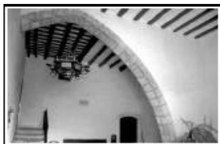
C. Detall d'un arc diafragma del nivell inferior.
