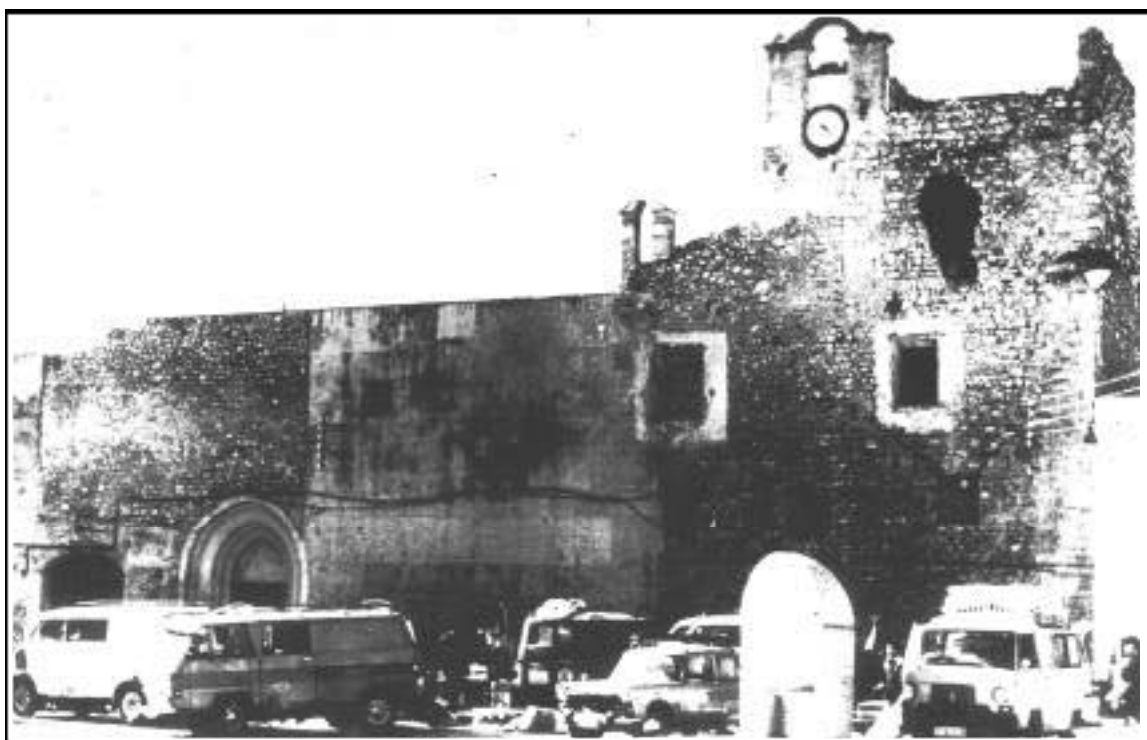
B. Vista de la façana anterior, poc abans de la demolició (1968). S'observa com una part del mur fou adreçat de formigó, per tal de poder-hi jugar a pilota. (Clixé: AVH, Arxiu fotogràfic )
