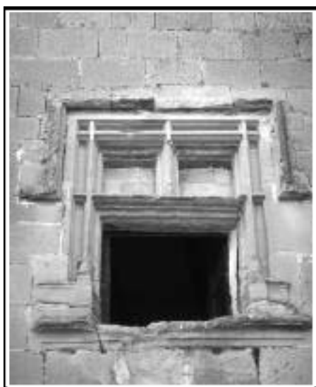
C. Finestra situada damunt la porta d'entrada del castell de Castellmeià.
