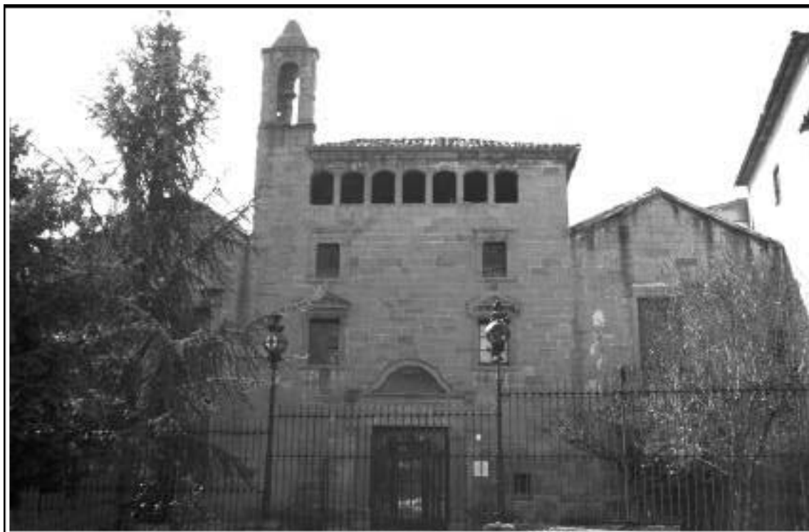
A. Façana principal de l'hospital d'en Terrades de Vic. (ss. xvi–xvii).
