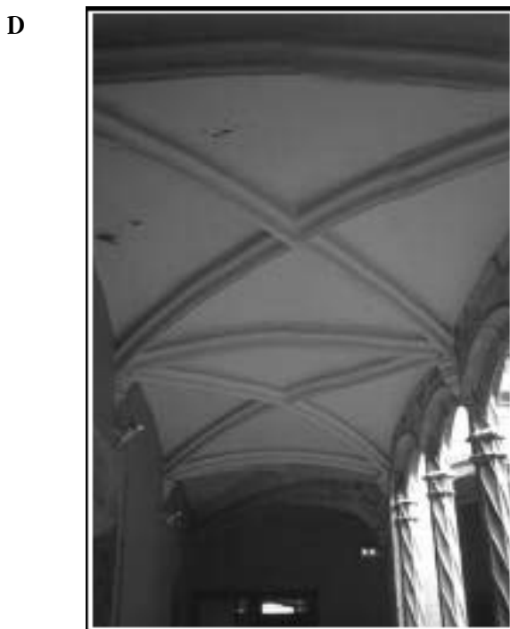
A. Detall de la volta d'aresta de les galeries de la planta baixa. B. Solució del pilar raconer del claustre inferior. C. Porta situada en l'extrem septentrional de la galeria del primer pis. D. Detall de la volta de creueria de les galeries de la planta noble. E. Obertura-balcó, a la primera planta, que dona al vestíbul d'accés a l'hospital. (Clixés: Antoni Conejo)
