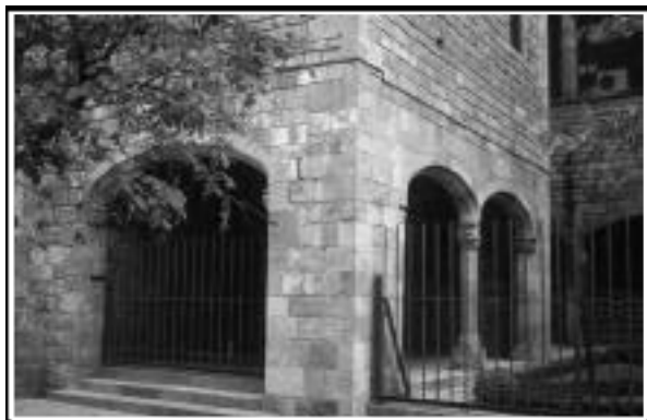
A. Porxo emplaçat en el sector sud-est del claustre, corresponent al nivell inferior de l'arxiu de l'hospital.
