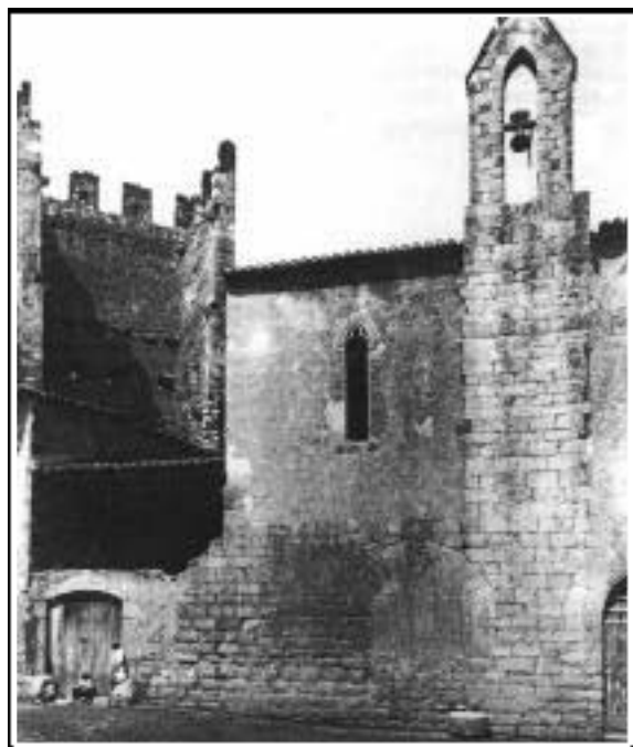
B. Façana principal de l'hospital, l'any 1918. S'aprecia com els carreus del nivell inferior, es desenvolupaven més enllà de l'edifici existent, confirmant que antigament comptava amb una altra tramada en aquest sector. (Fotografia: ap. PORTA BALANYÀ—SERRA 1992, 159)
