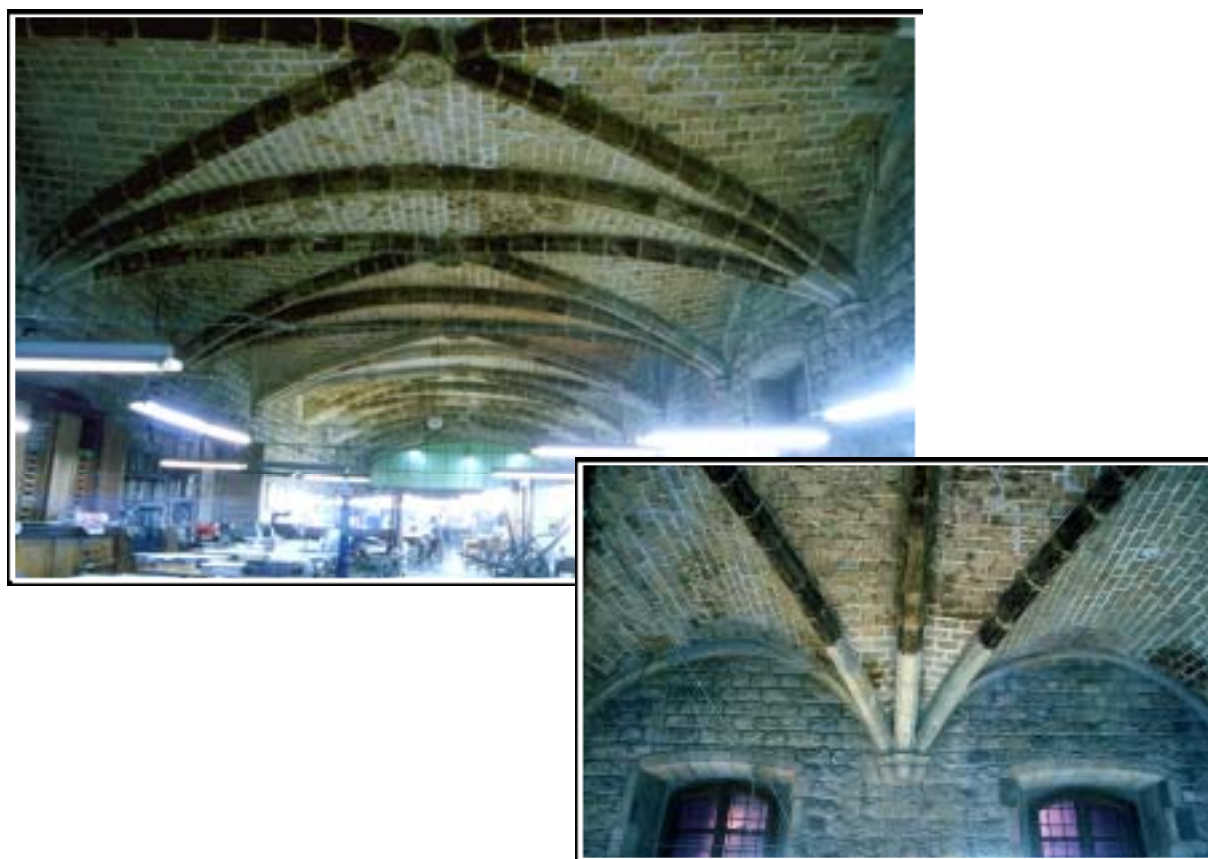
B–C. Interior de la crugia inferior oriental, avui utilitzada com a Escola de Conservació del Llibre. Igualment, s'observa l'arrencament de les voltes, d'acord amb l'esquema original, i no peraltades o alterades, com en altres punts de l'edifici.
