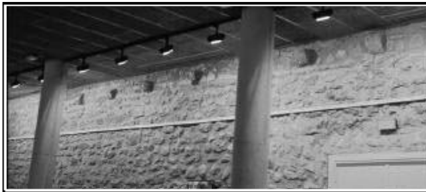
C. Permòdols de cap de biga, conservats a l'interior del mur nord-occidental, avui sala d'exposicions Infant Pere de l'Hospitalet de l'Infant.
