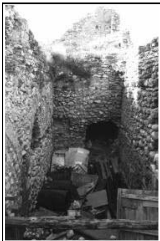
Detalls de les runes de la crugia septentrional c. 1960. S'aprecia la divisió bipartita interior, mitjançant una successió d'arcs de mig punt, avui desapareguts.
