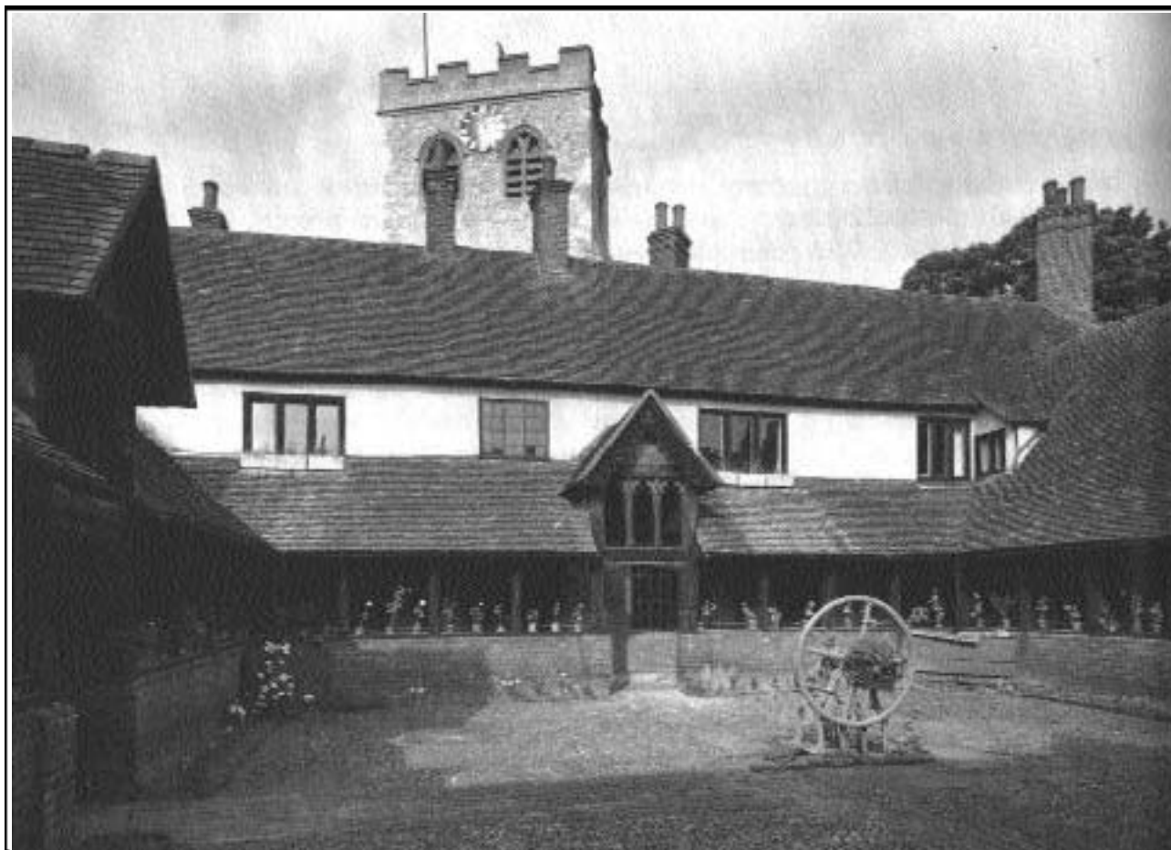
Vista parcial del claustre de l'almshouse d'Ewelme (Oxon), 1437–1442. (Imatge: ap- ORME–WEBSTER 1995, 142)
