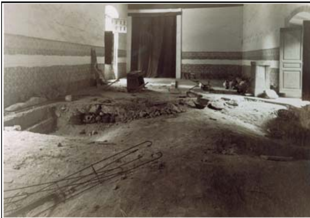
A. Restauració de l'actual aula magna de l'IEI el 1940: extradòs de les voltes de creueria del nivell inferior i, al fons, gerros i càntirs utilitzats per a llur reompliment, trobats en el transcurs d'aquesta intervenció.
