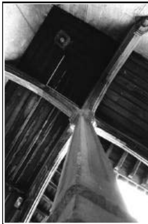
B. Detall d'un dels angles de les galeries del pati.
