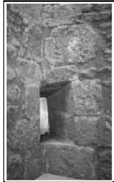
A-B. Detalls exterior i interior, de dues sageteres dels nivells inferiors dels murs de l'hospital.
