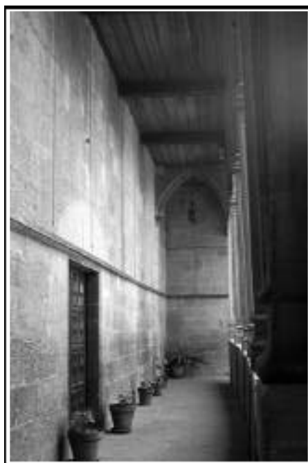
B. Galeria occidental.
