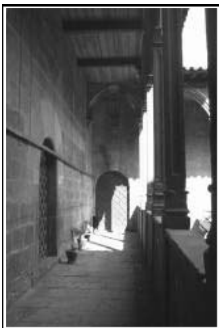
A. Galeria septentrional.
