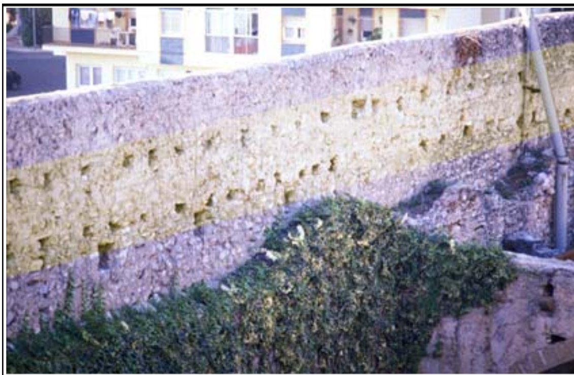
A. La banda groga senyala els forats de les parts altes del mur occidental, on s'haurien encabit bigues de fusta per a sostenir algun tipus d'estructura, possiblement les verdesques documentades en els llibres de comptes de l'hospital.
